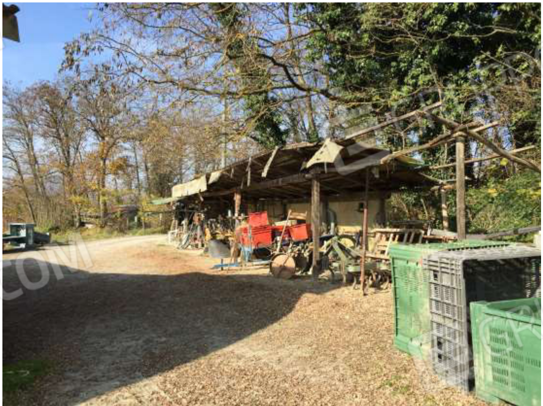
Foto 16 – Baracche presenti sul sedime
