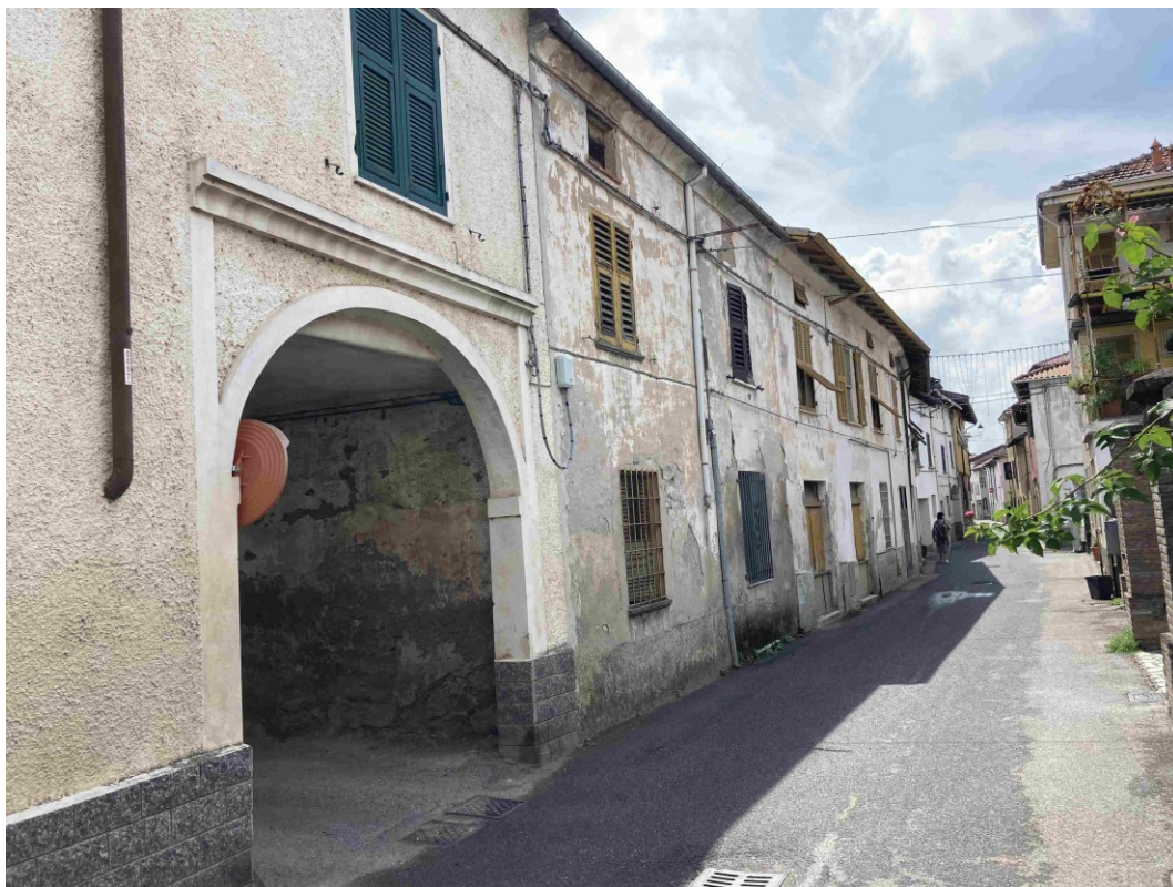
Foto 1 – Prospetto da Via Italia
