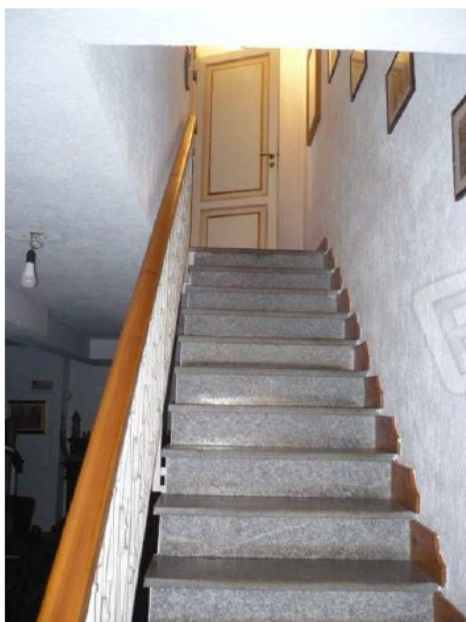
23 – Particolare scala di accesso al piano seminterrato
