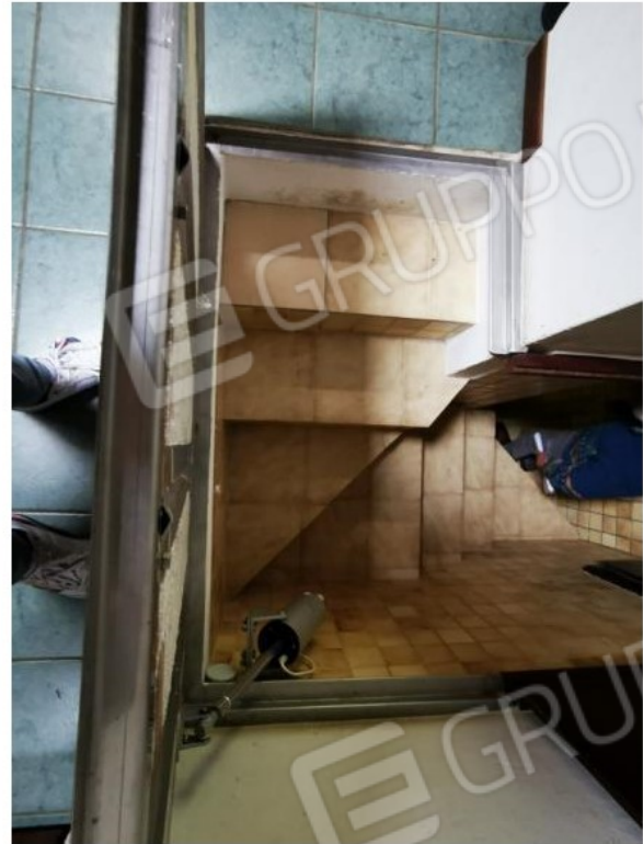
Residenza - Scala accesso alla cantina
