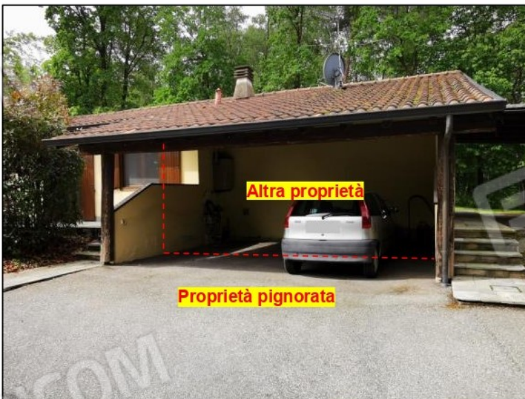
Porzione di tettoia
