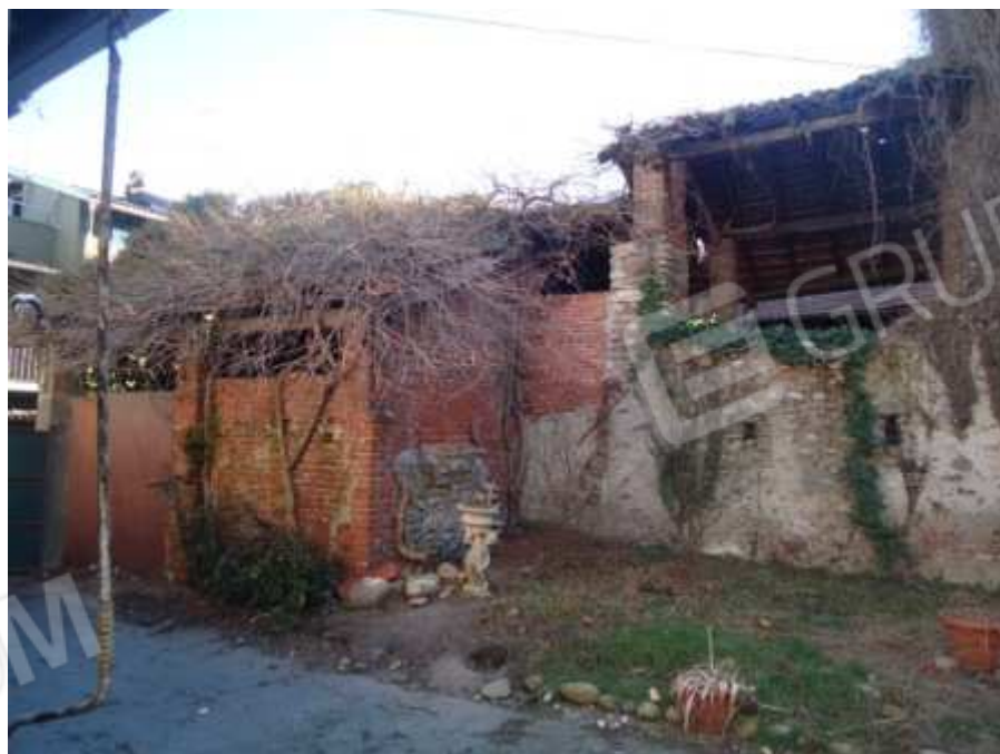
Foto 12: Vista esterna dell'immobile Foglio 11 mappale 19
