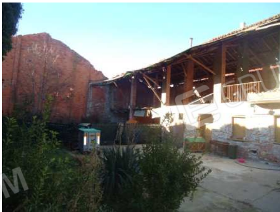
Foto 14: Vista esterna dell'immobile Foglio 11 mappale 470
