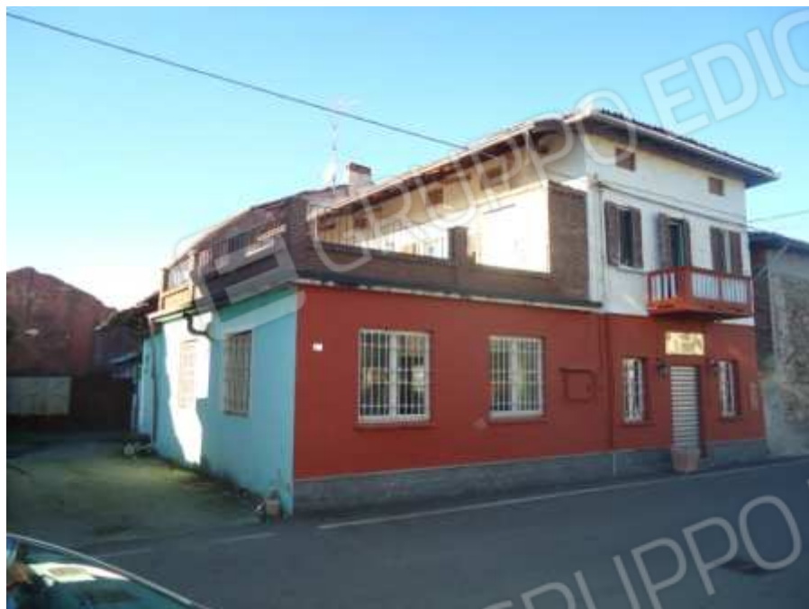
Foto 3: Vista esterna dell'immobile Foglio 11 mappale 18 - 470
