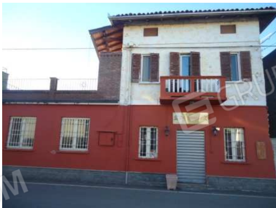
Foto 4: Vista esterna dell'immobile Foglio 11 mappale 18
