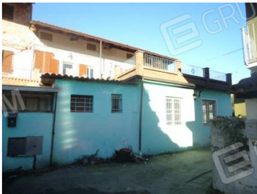
Foto 6: Vista esterna dell'immobile Foglio 11 mappale 18 - 470
