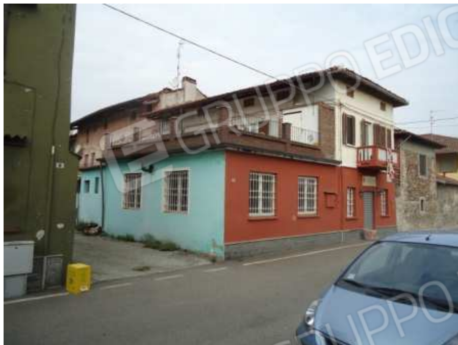
Foto 1: Vista esterna dell'immobile Foglio 11 mappale 18 - 470
