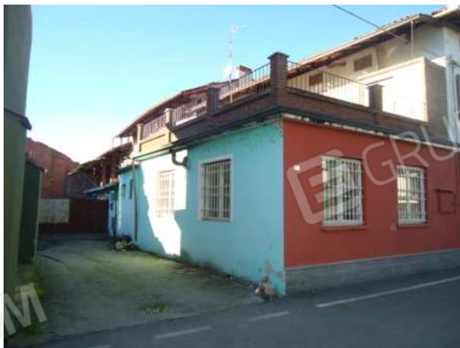
Foto 2: Vista esterna dell'immobile Foglio 11 mappale 18 - 470
