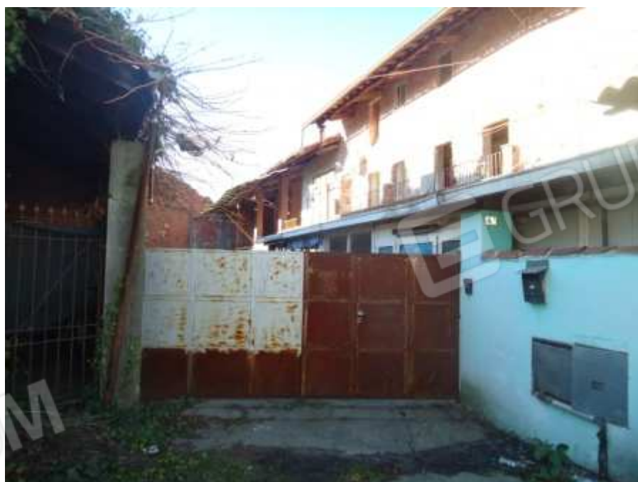
Foto 8: Vista esterna dell'immobile Foglio 11 mappale 18 - 19 - 470
