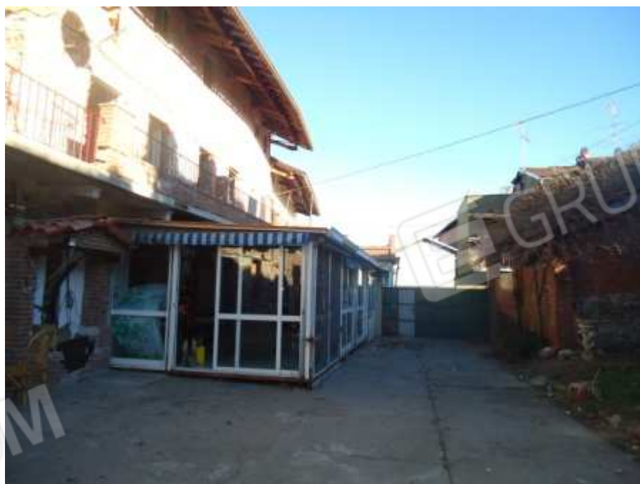
Foto 20: Vista esterna dell'immobile Foglio 11 mappale 18 - 19 - 470
