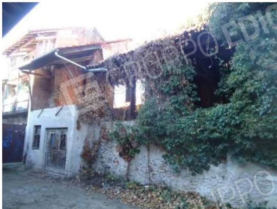
Foto 13: Vista esterna dell'immobile Foglio 11 mappale 19
