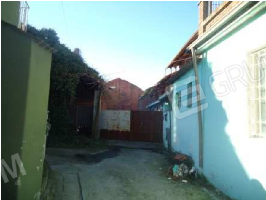
Foto 10: Vista esterna dell'immobile Foglio 11 mappale 18 - 19 - 470
