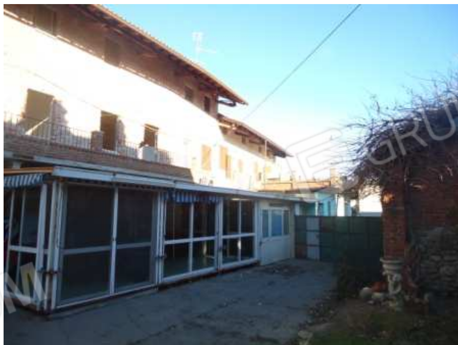
Foto 16: Vista esterna dell'immobile Foglio 11 mappale 18 - 19 - 470
