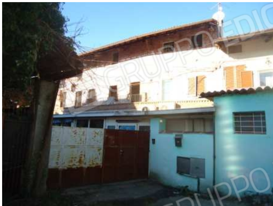
Foto 7: Vista esterna dell'immobile Foglio 11 mappale 18 - 19 - 470
