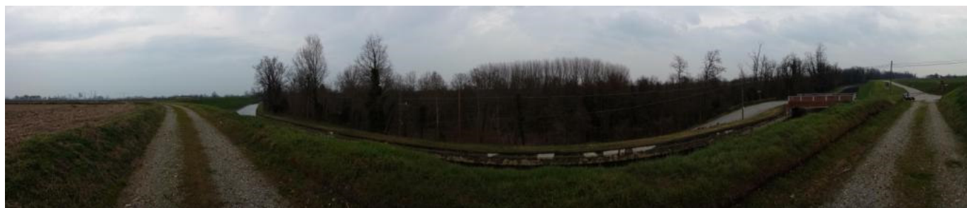
panoramica 22 area boscata e ripa stradale a valle del Naviglio Langosco
