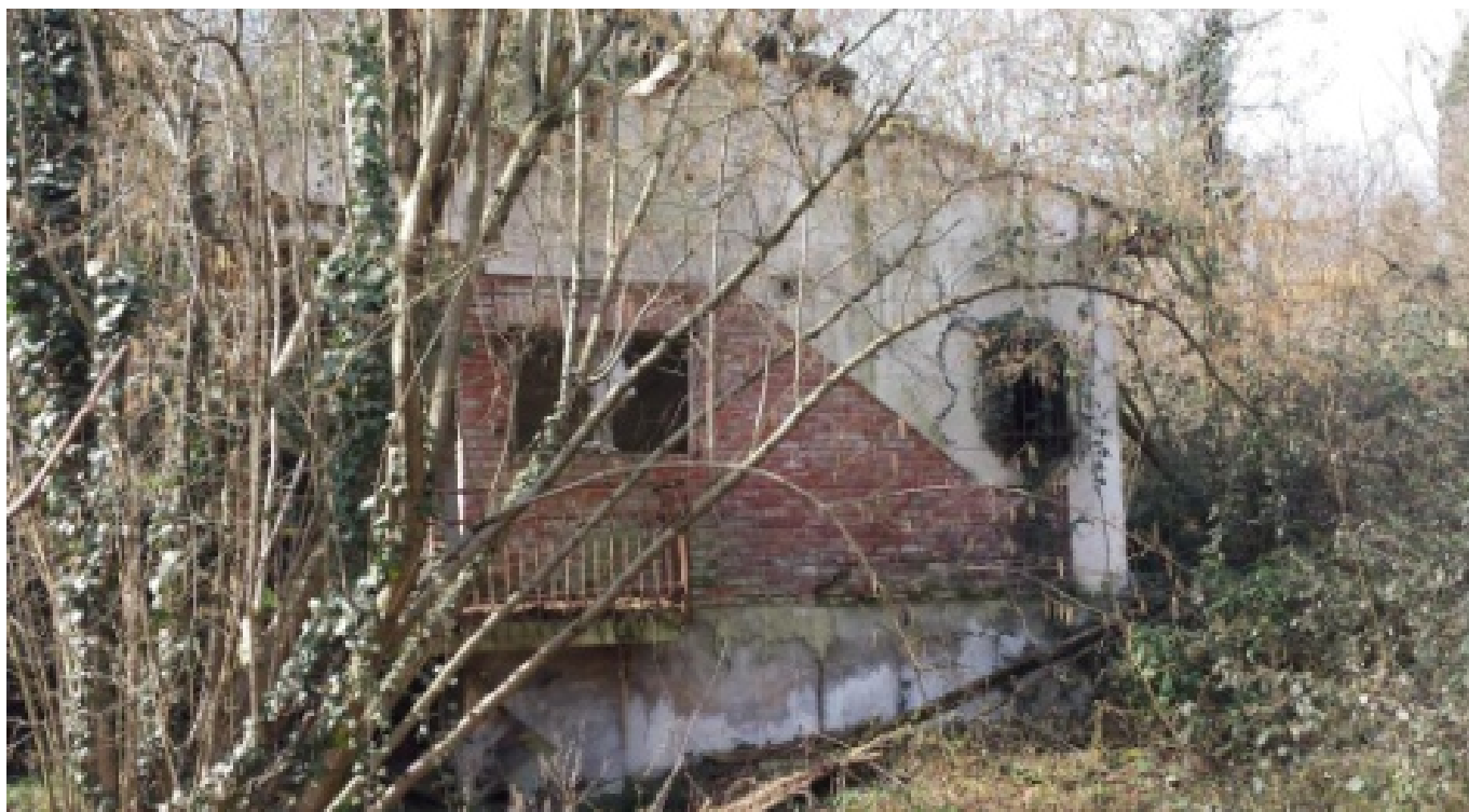
dettaglio 05 fabbricato civile diroccato in via Bagno
