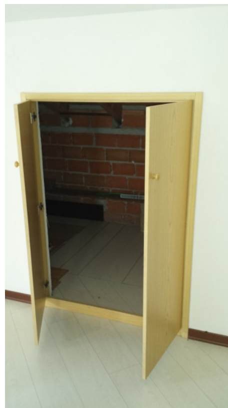
Locali abitabili dell'alloggio del custode: ripostiglio nel sottotetto
