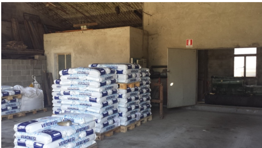
Locali di deposito all'interno della tettoia accessoria
