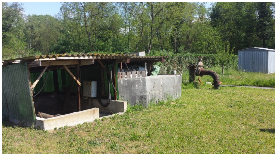
Tettoie pertinenziali sparse, in prossimità della tettoia accessoria all'allevamento
