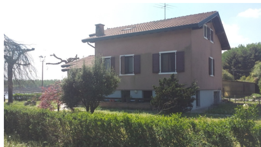
Alloggio del custode, visto dal piazzale d'ingresso
