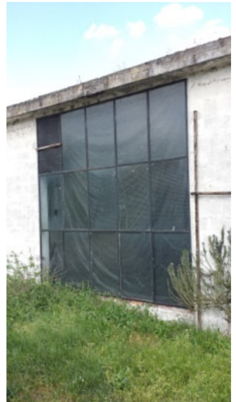
Serramenti esterni della tettoia accessoria all'allevamento
