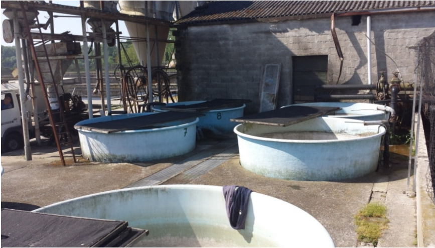
Vaschette di 2° fase e tettoia accessoria all'allevamento
