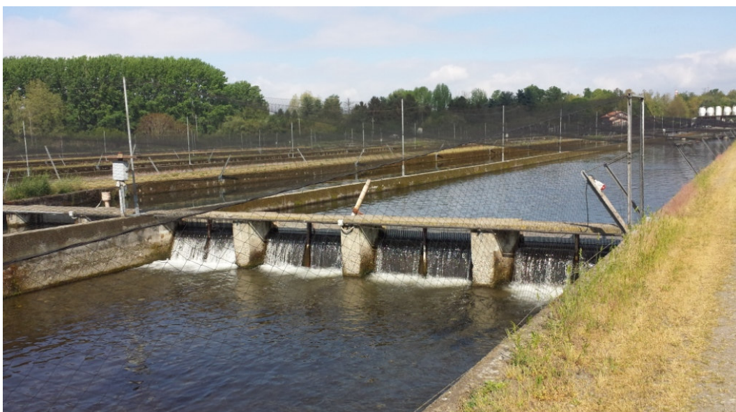
Vasconi allevamento ittico con rete di protezione dai volatili e strade di servizio
