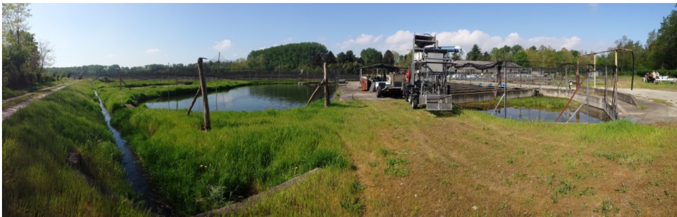
Sulla Dx vaschette di 4° fase, al centro primo bacino in terra battuta, e strada di servizio
