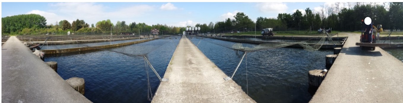
Vasconi allevamento ittico con rete di protezione dai volatili e strade di servizio
