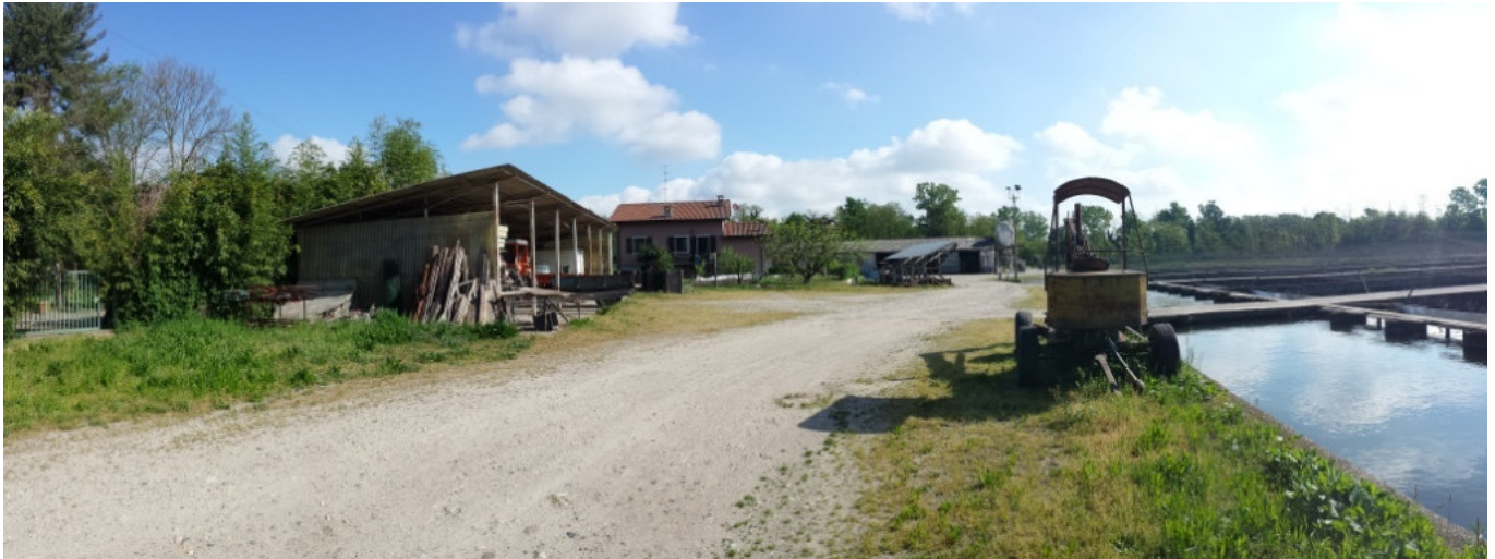
Tettoia pertinenziale di recente costruzione, alloggio del custode, tettoia accessoria all'allevamento e vasconi (5° fase)
