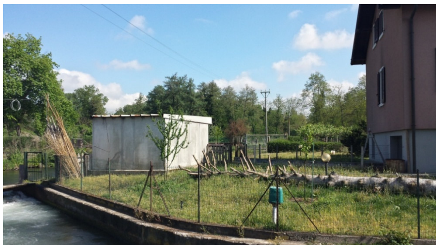
Prefabbricato non autorizzato ad uso autorimessa
