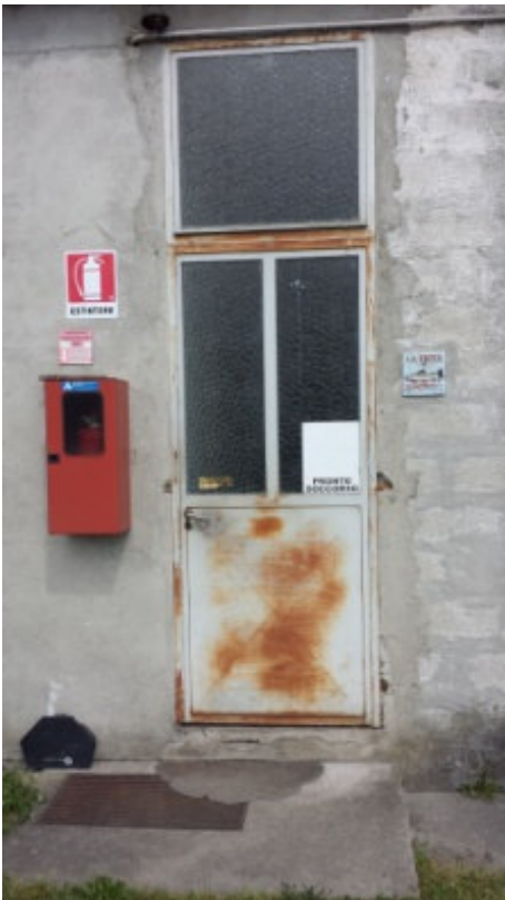
Serramenti esterni della tettoia accessoria all'allevamento
