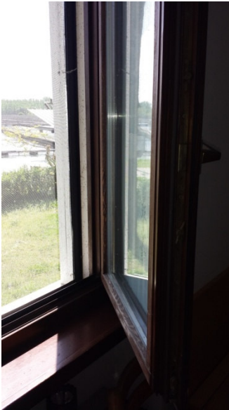
Particolare dei serramenti esterni alloggio del custode
