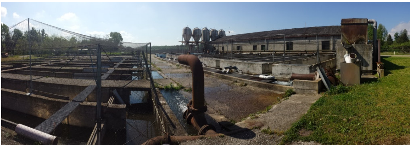
Sulla Sx vaschette di 3° fase, sulla Dx vaschette di 2° fase e tettoia accessoria all'allevamento
