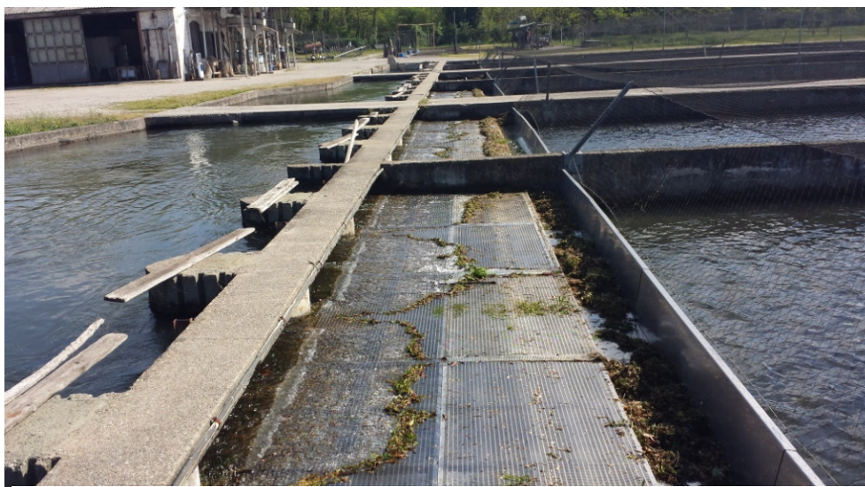
Dettaglio delle opere d'arte per sistema di immissione acque a monte dei vasconi (5° fase)
