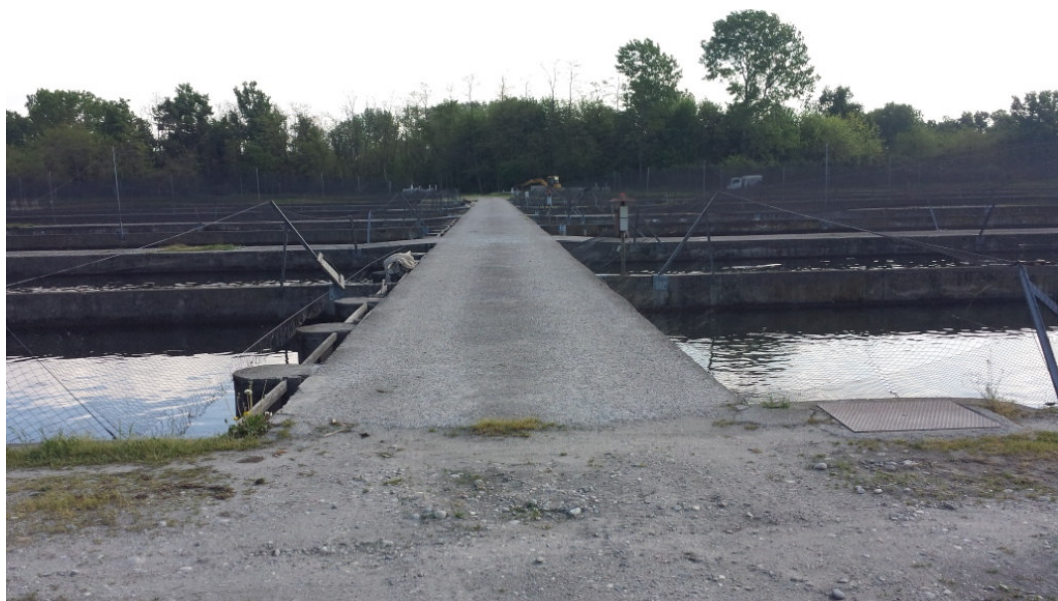
Vasconi allevamento ittico con rete di protezione dai volatili e strade di servizio
