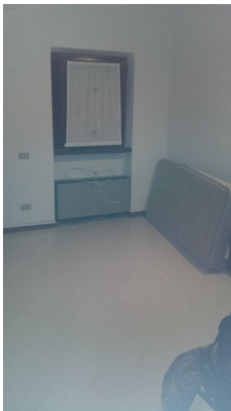
Locali abitabili dell'alloggio del custode: cameretta 2 nel sottotetto
