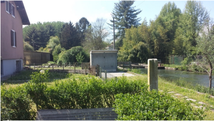
Autorimessa in corpo staccato, realizzato con elemento prefabbricato (non autorizzato)
