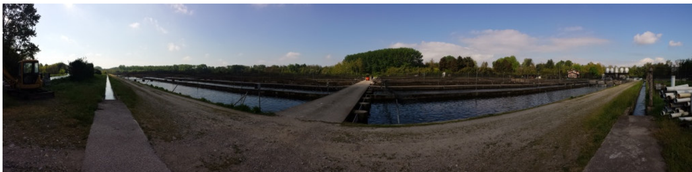
Vasconi allevamento ittico con rete di protezione dai volatili e strade di servizio
