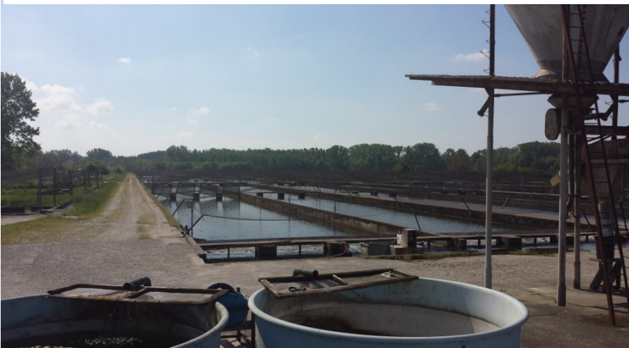
Strada di servizio a lato dei vasconi di 5° fase e dei bacini in terra battuta
