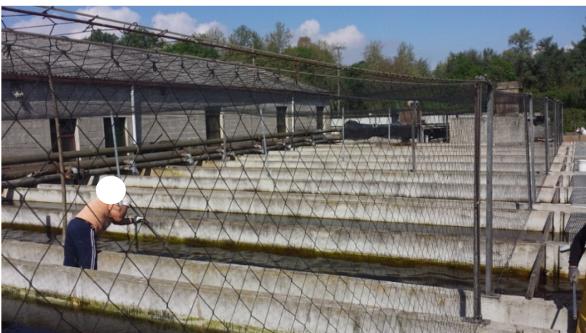
vaschette di 2° fase e tettoia accessoria all'allevamento
