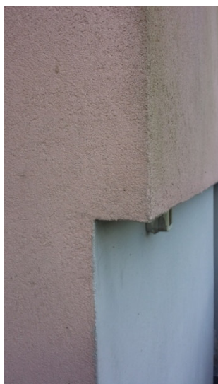
Alloggio del custode, dettaglio sistema cappotto
