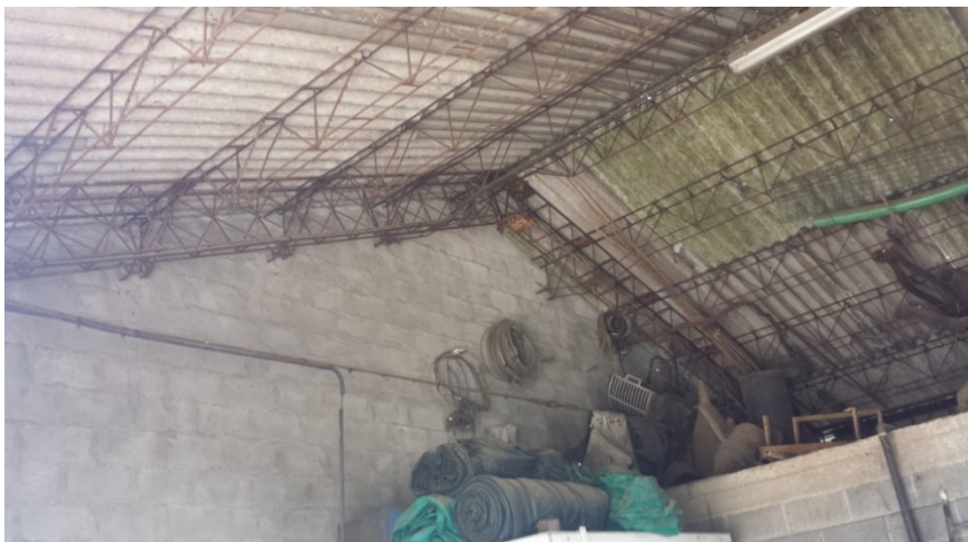
Locali di deposito all'interno della tettoia accessoria (struttura del tetto di copertura)
