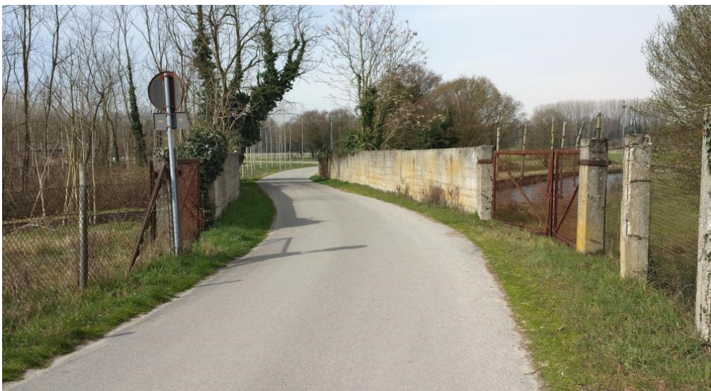
Attraversamento della strada comunale Bagno
