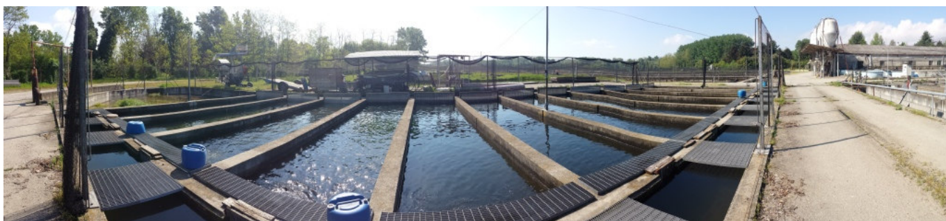
Vaschette di 4° fase; sulla Dx della strada di servizio vaschette di 3° fase, poi vaschette di 2° fase e tettoia accessoria all'allevamento
