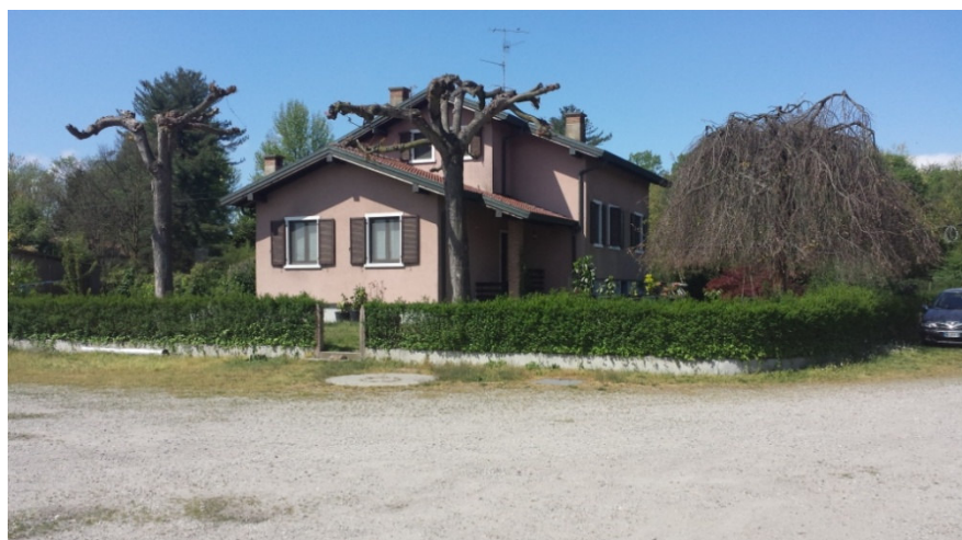
Alloggio del custode visto dal piazzale interno
