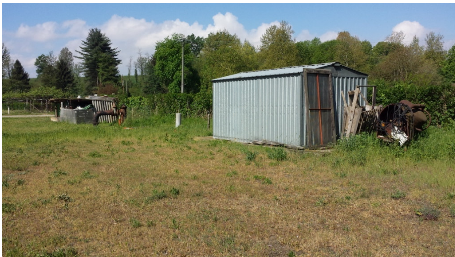
Tettoie pertinenziali sparse, in prossimità della tettoia accessoria all'allevamento
