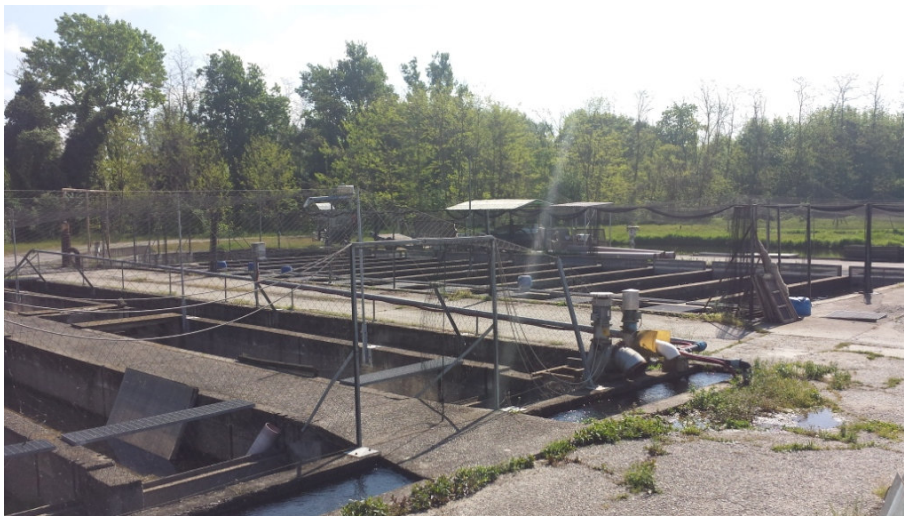
Sulla Sx vaschette di 3° fase, poi strada di servizio e vaschette di 4° fase
