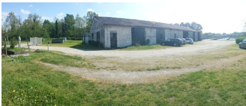
Tettoia accessoria all'allevamento, con piazzale d'ingresso e vasconi 5° fase
