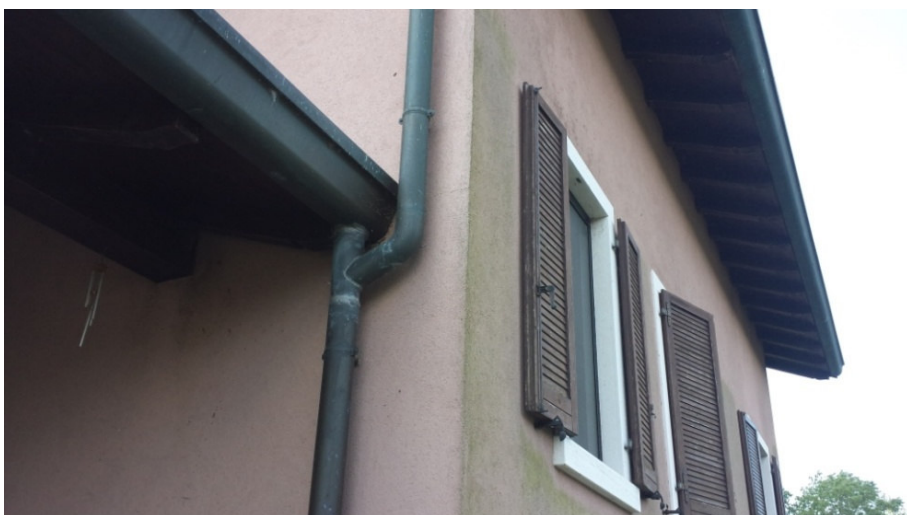
Alloggio del custode, dettaglio canali, persiane e gronda tetto
