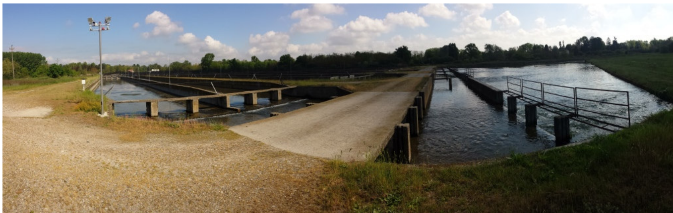
Vasconi allevamento ittico, bacino di decantazione e strade di servizio
