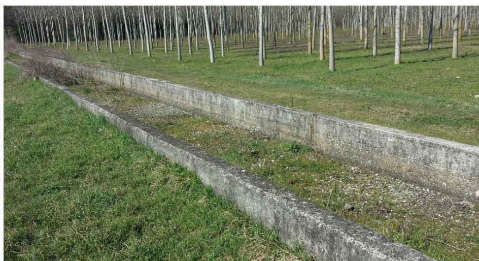
dettaglio 19 canale irriguo d'epoca a monte del lotto 4a
