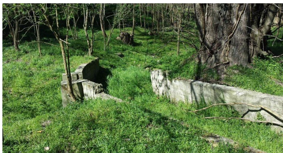
dettaglio 21 canale irriguo d'epoca a monte del lotto 4a, derivazione da roggia in terra battuta
