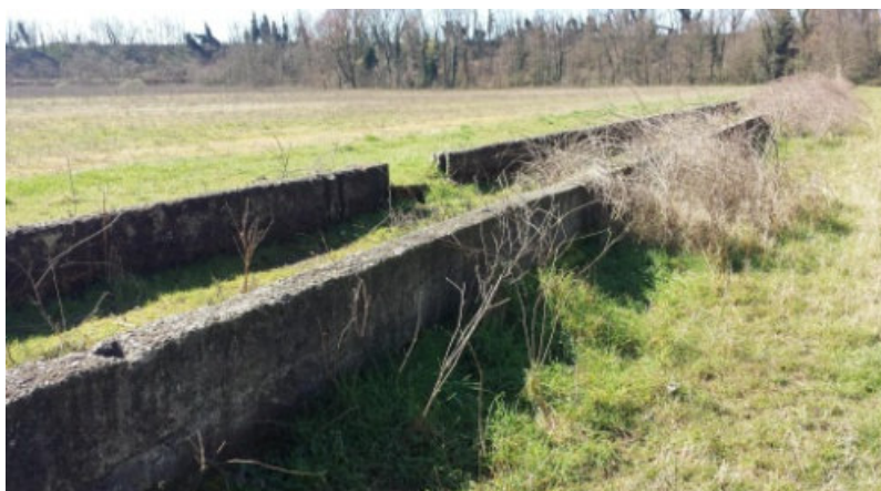
dettaglio 18 canale irriguo d'epoca a monte del lotto 4a
