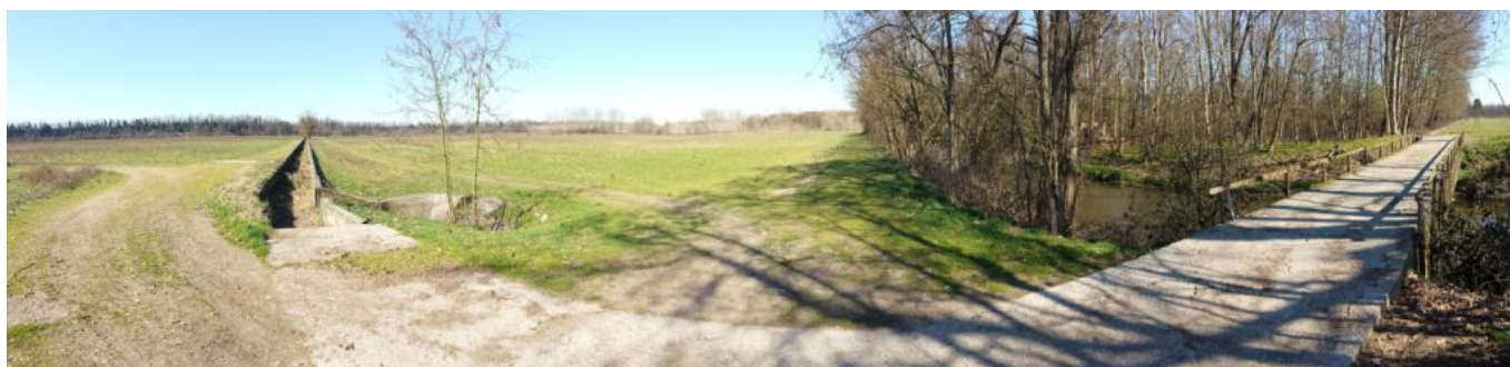
Vista generale del campo, sulla Sx strada di servizio e canale irriguo in calcestruzzo, sulla Dx ponte sulla Roggia Scaricatore
