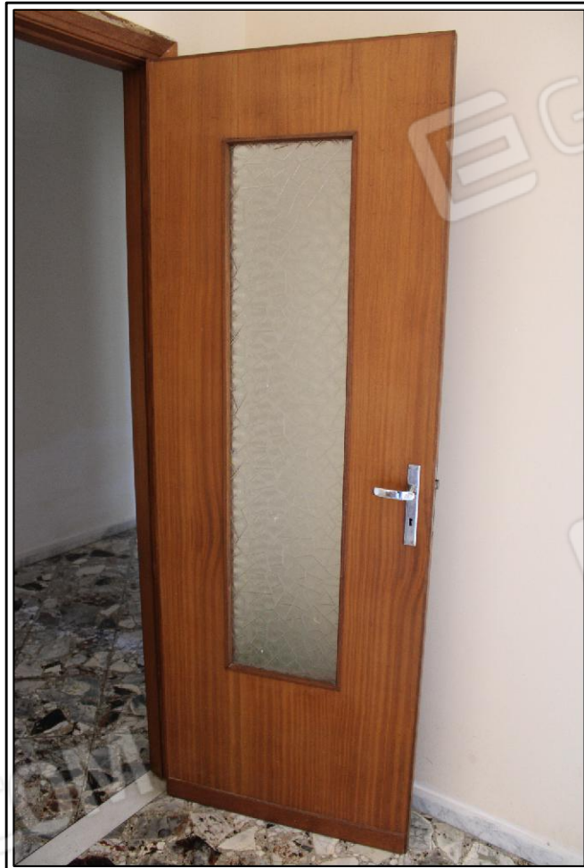
FOTO N° 44 - PARTICOLARE PORTA INTERNA
