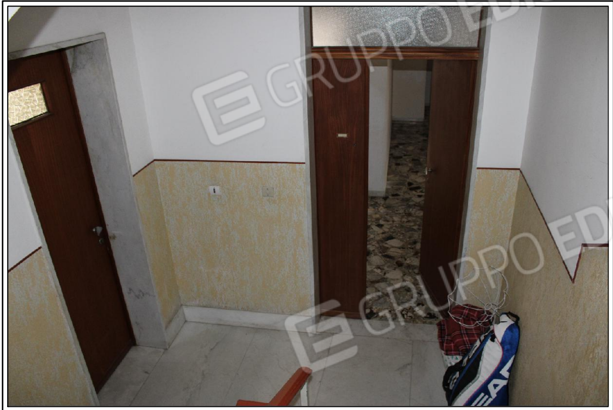
FOTO N° 7 - VANO SCALA, INGRESSI ABITAZIONE
