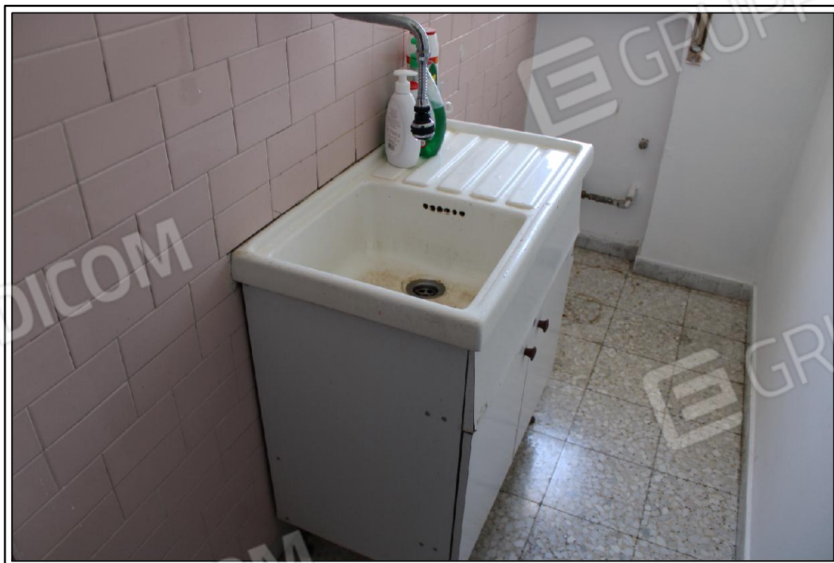
FOTO N° 32 - PARTICOLARE LAVABO LAVATOIO
