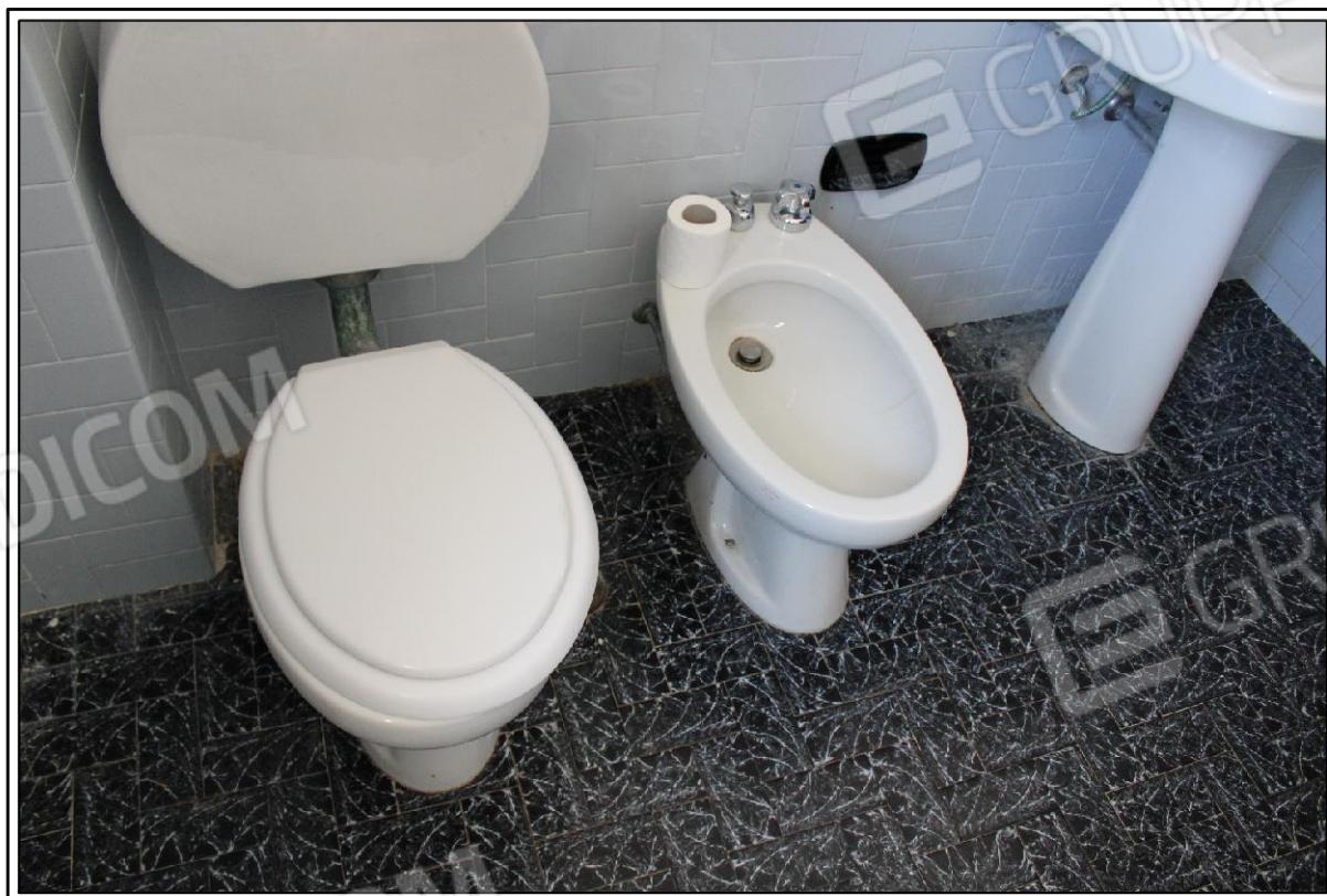
FOTO N° 30 - PARTICOLARE SANITARI BAGNO
