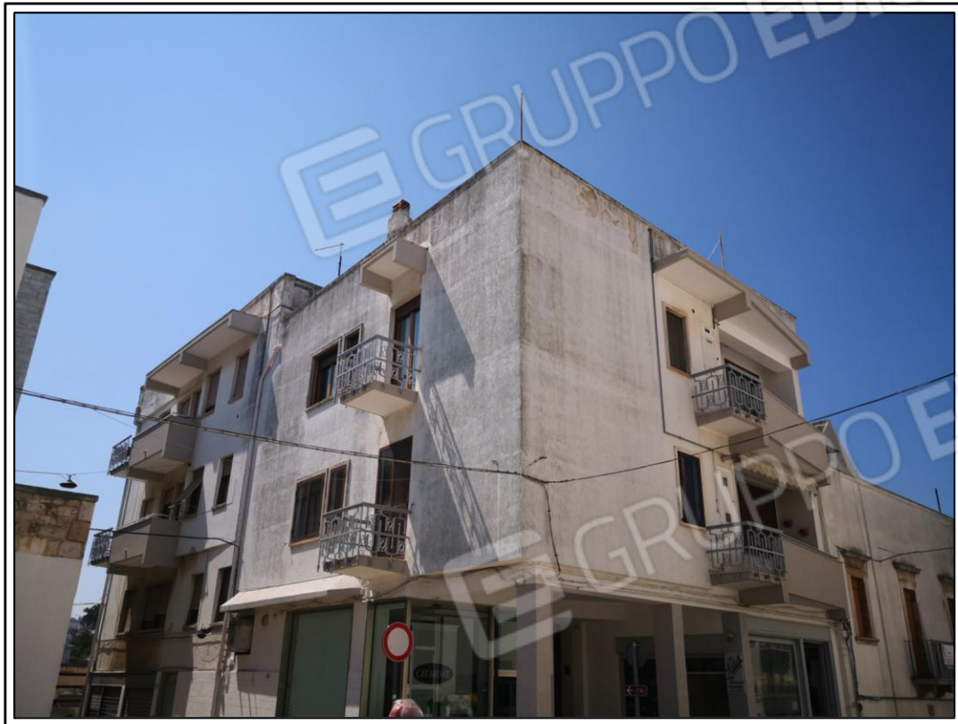
FOTO N° 1 - PROSPETTO FABBRICATO VIA BISSOLATI
