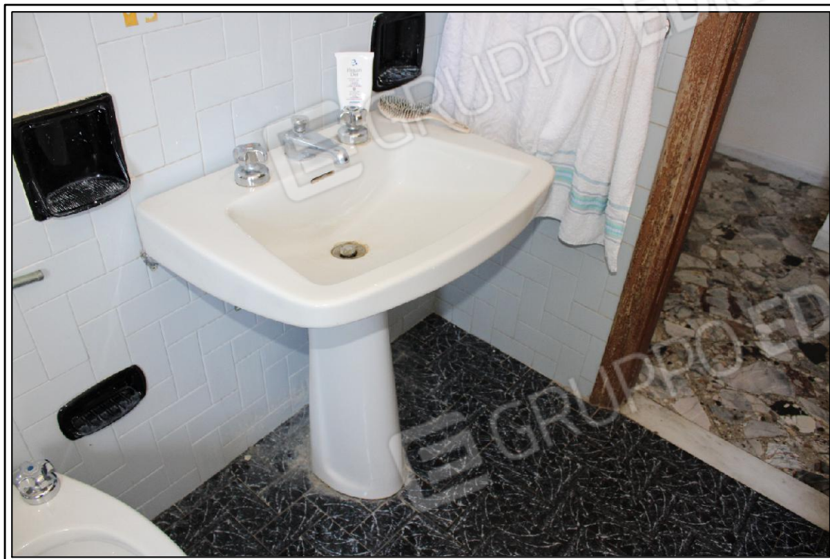
FOTO N° 29 - PARTICOLARE SANITARI BAGNO
