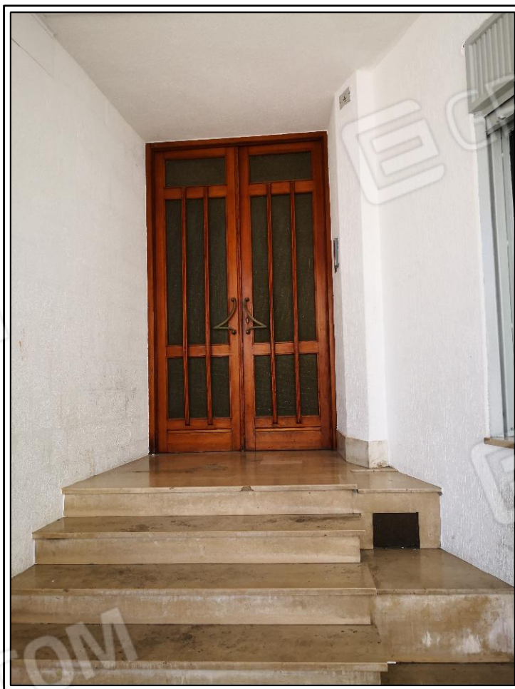
FOTO N° 4 - PORTONE INGRESSO VANO SCALA
