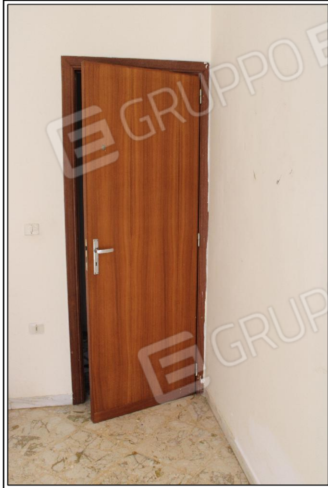
FOTO N° 43 - PARTICOLARE PORTA INTERNA
