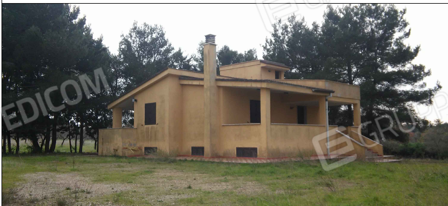
Esterno edificio "Abitazione A"
