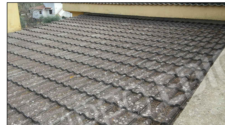
"Abitazione A" - Particolare copertura
