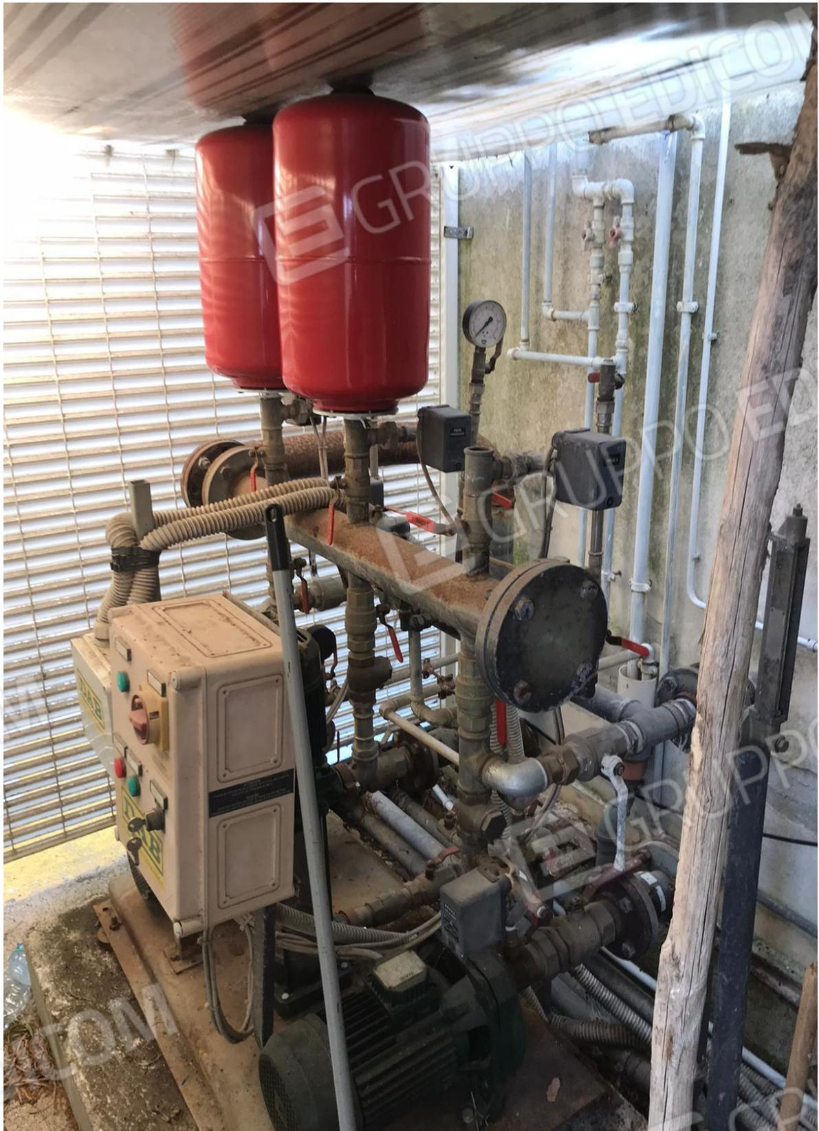
**FOTO Imp.1: in evidenza, nel vano contiguo la Centrale Termica parte degli impianti di autoclave/antincendio.**
