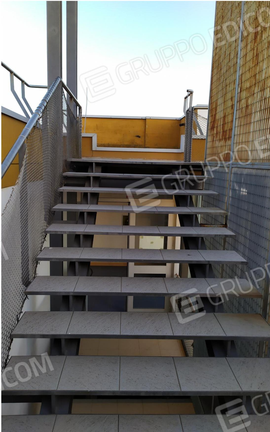
**FOTO Imp.19: in evidenza, la scala metallica prefabbricata che consente l'accesso esternamente sulle coperture piane per la manutenzione delle stesse e degli impianti tecnologici ivi installati.**
