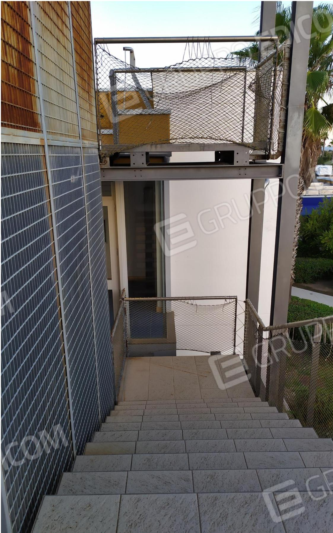
**FOTO Imp.20: in evidenza, la scala metallica prefabbricata che consente l'accesso esternamente sulle coperture piane per la manutenzione delle stesse e degli impianti tecnologici ivi installati.**
