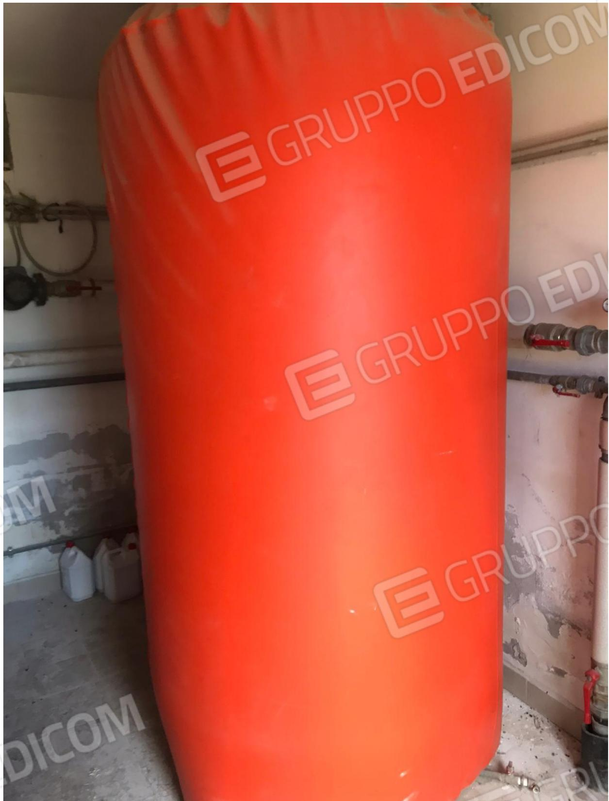
**FOTO Imp.6: in evidenza, nel vano Centrale Termica parte degli impianti di riscaldamento ed acqua calda sanitaria ed il serbatoio di accumulo della stessa.**
