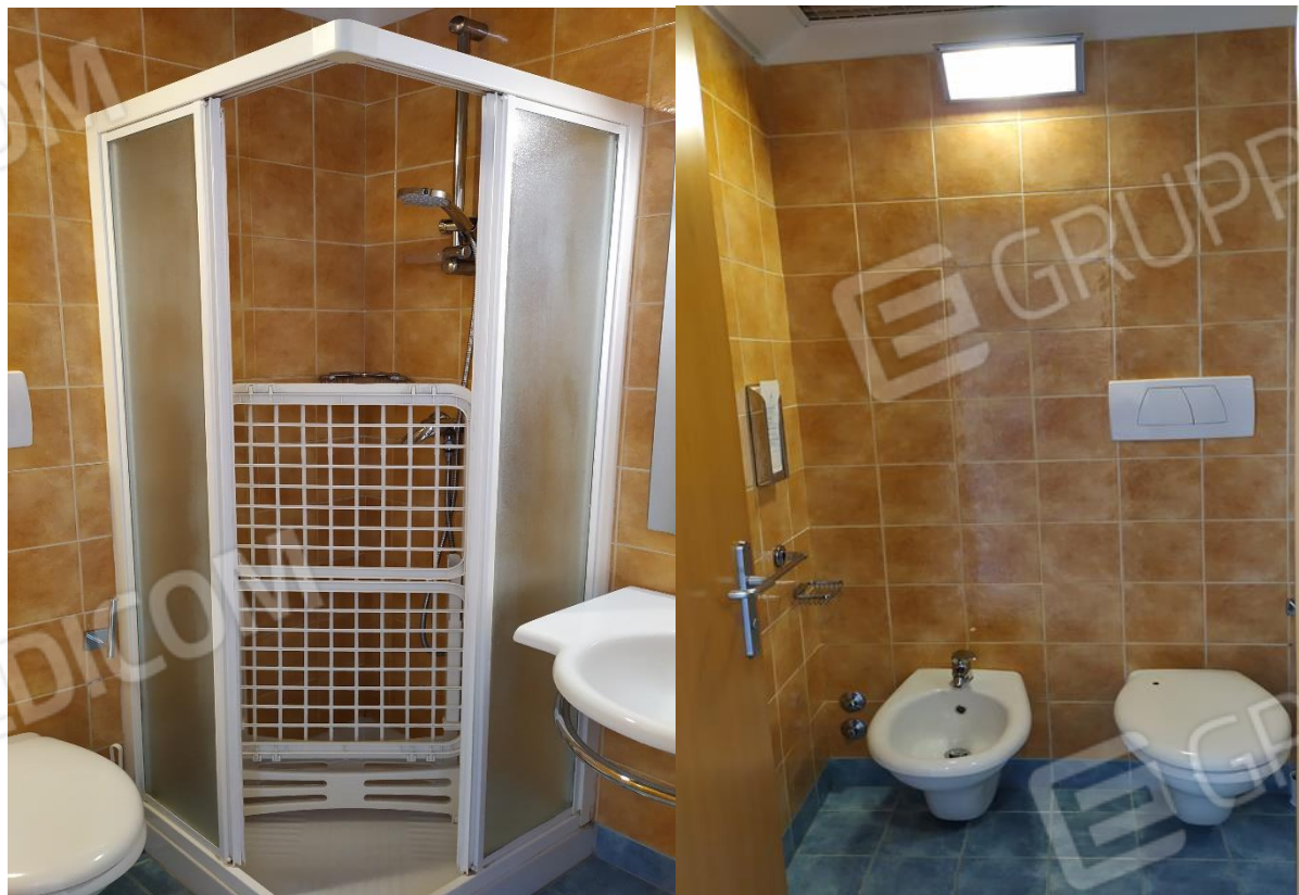
FOTO I.82-83: in evidenza, il bagno della camera 27, pressoché identica alle altre camere dell'Hotel.
