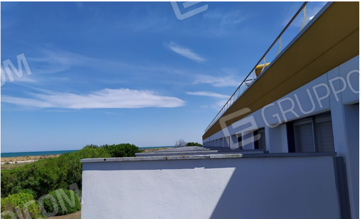
FOTO I.129: in evidenza, i setti divisori delle verande.
