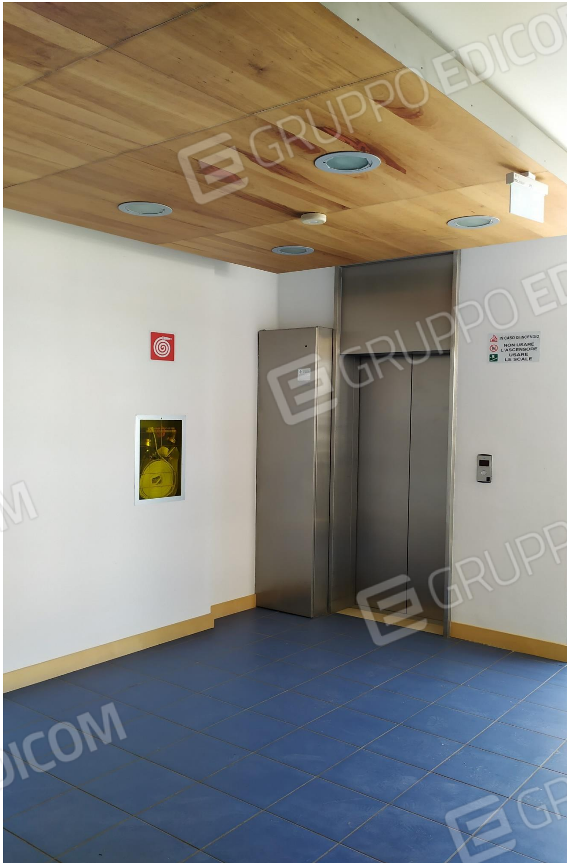
FOTO I.98: in evidenza, il pianerottolo di disimpegno e l'ascensore.
