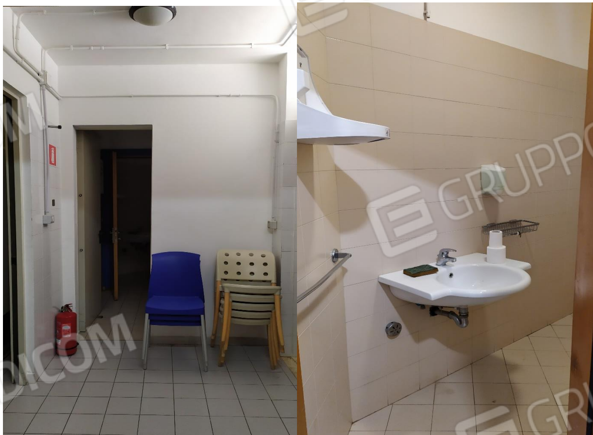
FOTO I.32-33: in evidenza, sul retro cucina l'ingresso di servizio a sx ed il w.c. del personale a dx.
