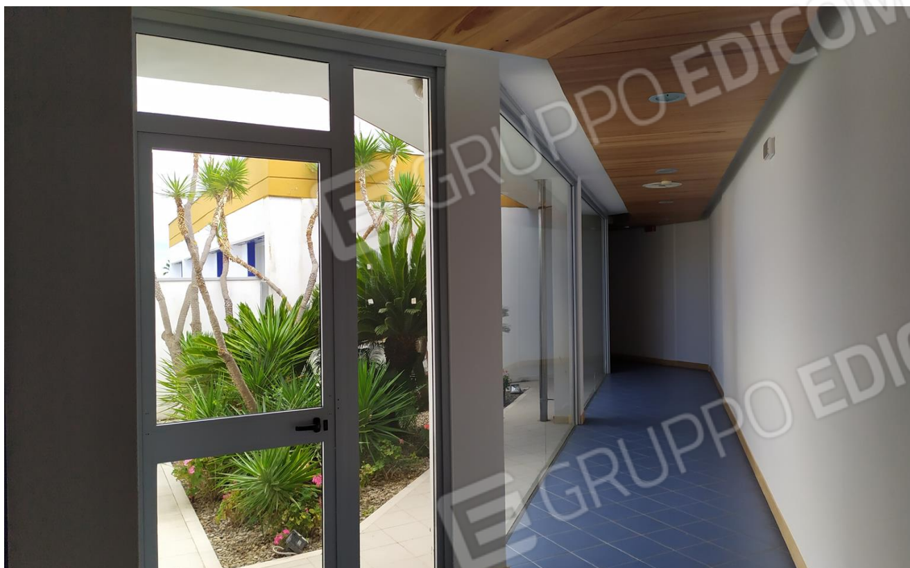
FOTO I.40: in evidenza, il corridoio ed il contiguo patio interno a sx.
