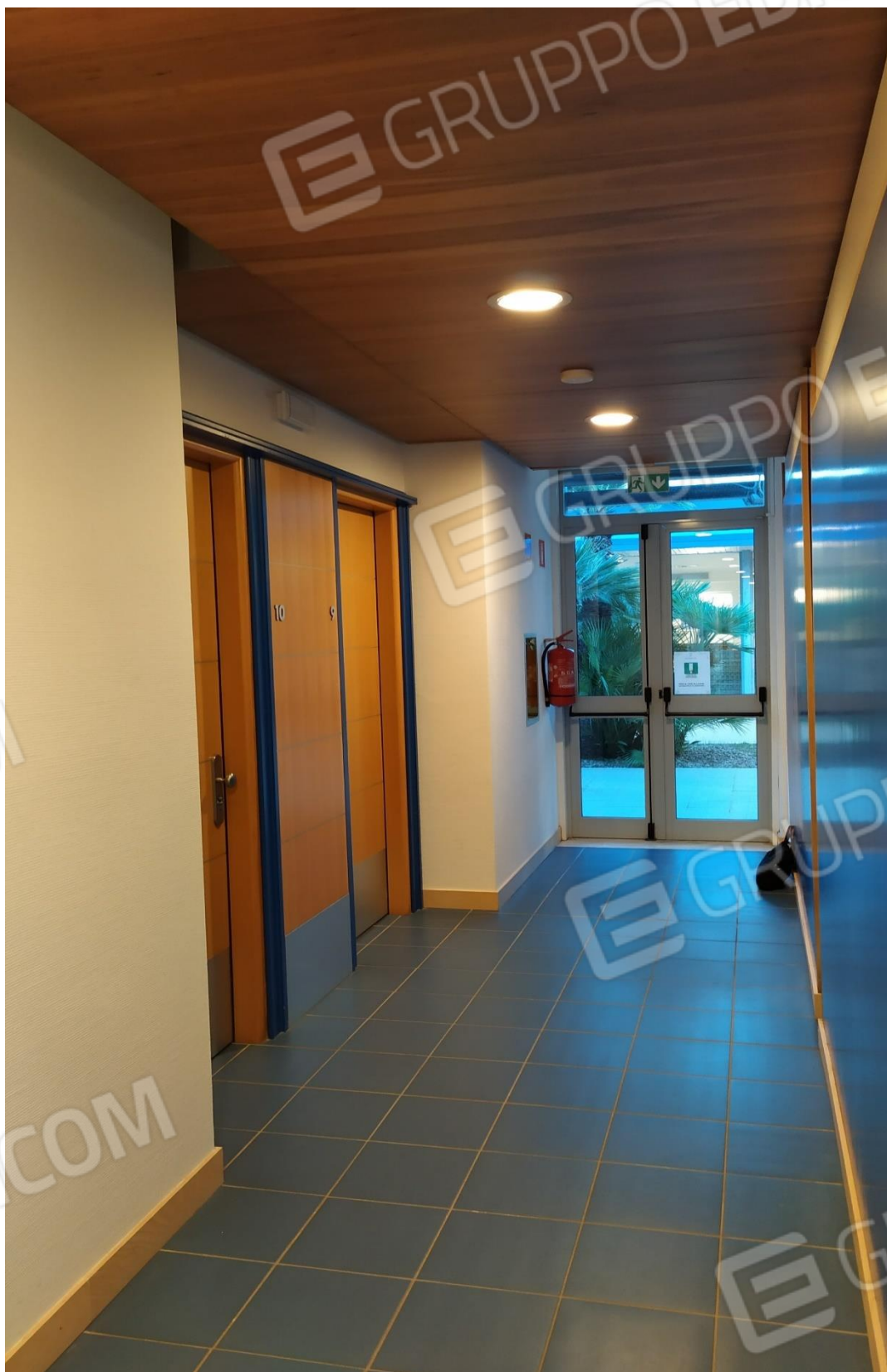
FOTO I.54: in evidenza, il corridoio di disimpegno in prossimità delle camere 9-10.
