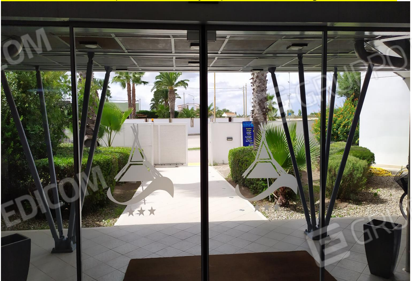
FOTO I.4: in evidenza, l'ingresso all'Hotel con le sue porte in cristallo scorrevoli ed il patio.
