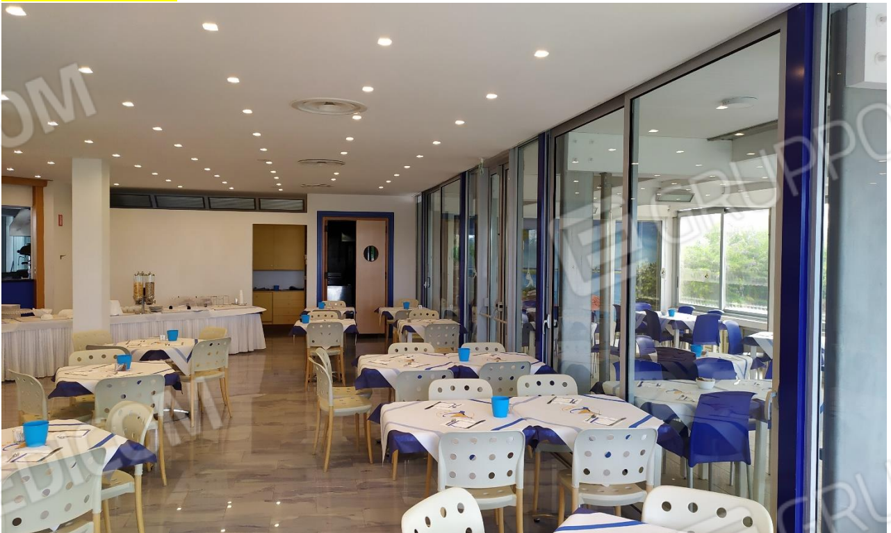
FOTO I.24: in evidenza, la sala ristoro e sullo sfondo la porta della cucina, a dx l'ampliamento della sala realizzato senza titolo edilizio, insanabile, da rimuovere/demolire.
