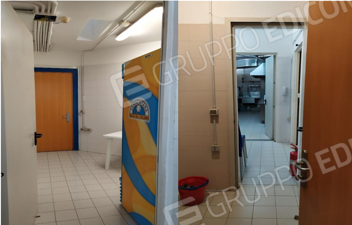
FOTO I.34-35: in evidenza, sul retro cucina il deposito a sx e lo spogliatoio del personale a dx.
