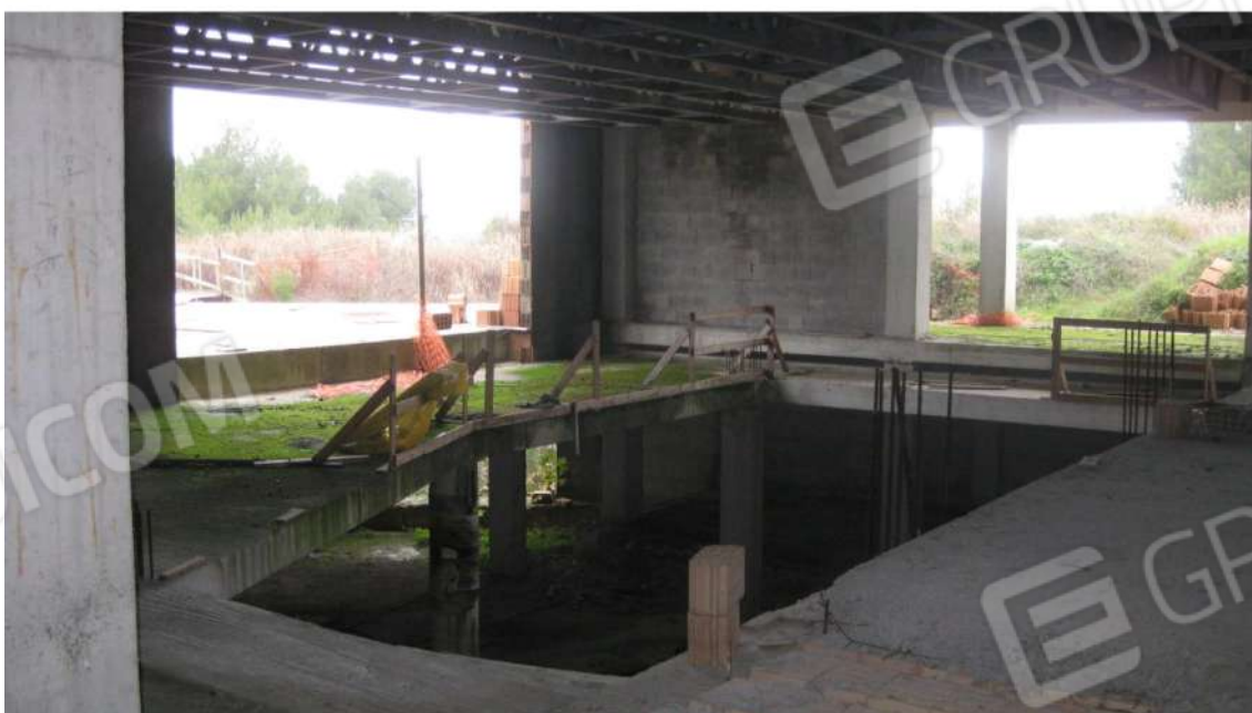
Foto n.43: vista interna dell'immobile D al livello superiore
