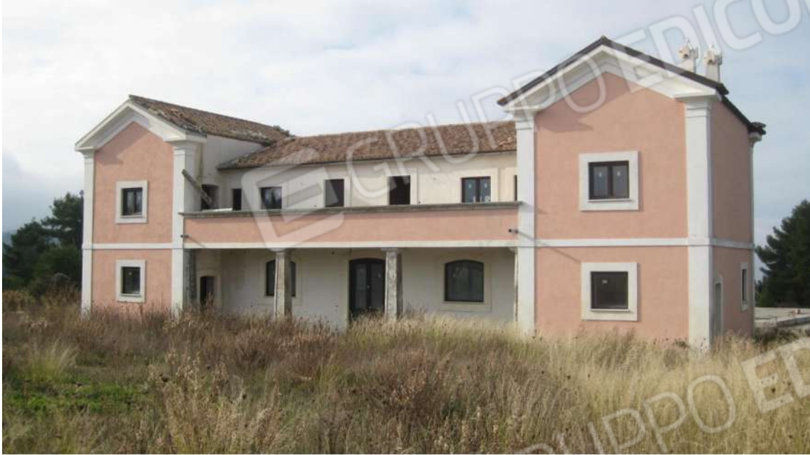
Foto n.13: immobile A, prospetto lato Sud-Est. Le facciate Sud-Est e Nord-Est sono al finito, mentre quelle a Nord-Ovest e a Sud-Ovest sono attualmente al rustico.
