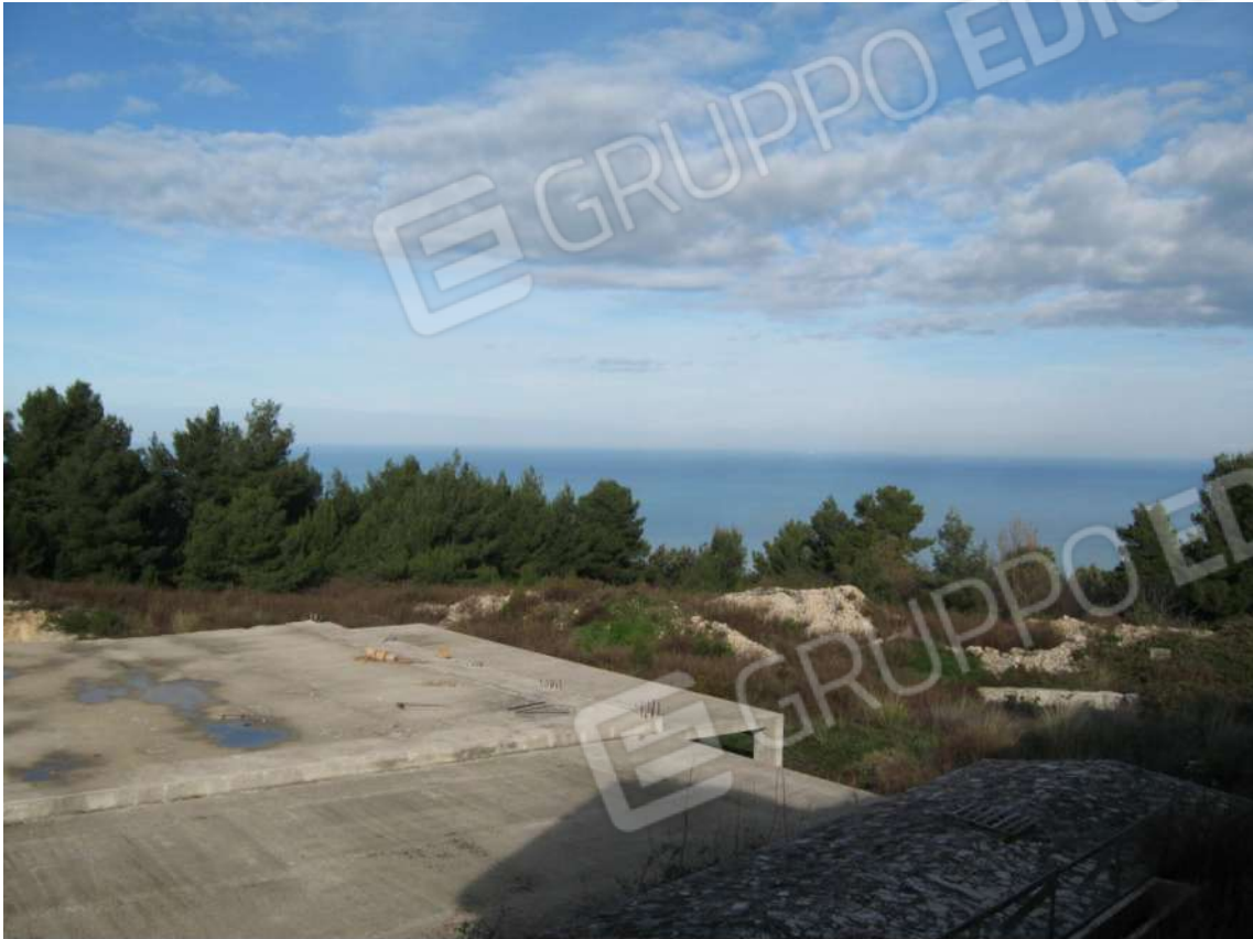
Foto n.40: copertura dell'immobile B a bassissimo impatto sul contesto e vista panoramica.
