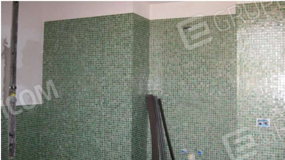
Foto n.21:bagno immobile B. Rivestimento in tasselli di mosaico pregiato. Sono utilizzate differenti colorazioni nei diversi bagni asserviti alle singole suite.
