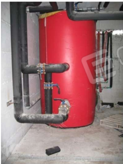
Foto n.33: vano tecnico immobile C.
