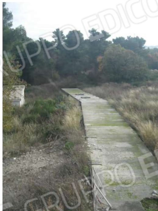
Foto n.34: tunnel di collegamento all'imm. C.
