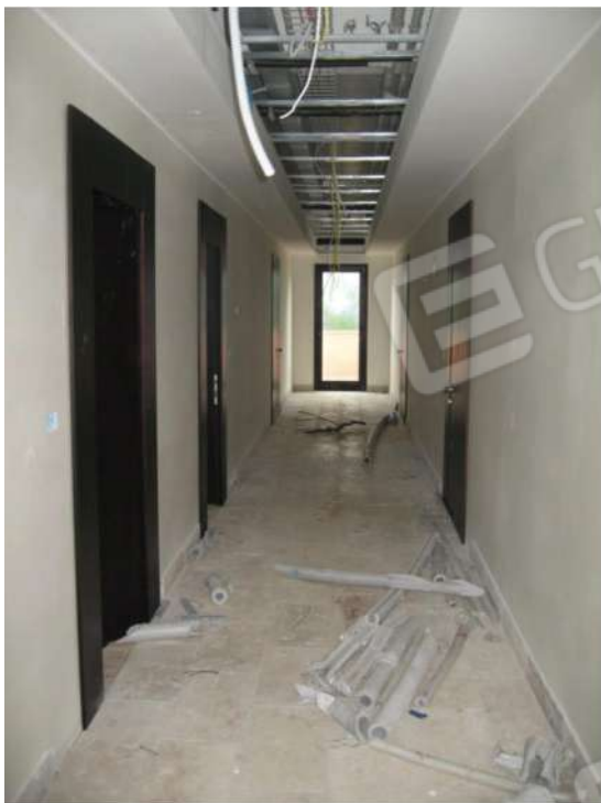
Foto n.28: immobile C, corridoio camere al piano terra.
