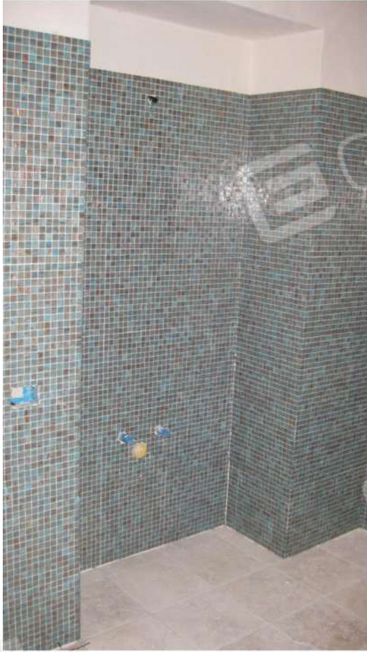
Foto n.19:bagno immobile B
