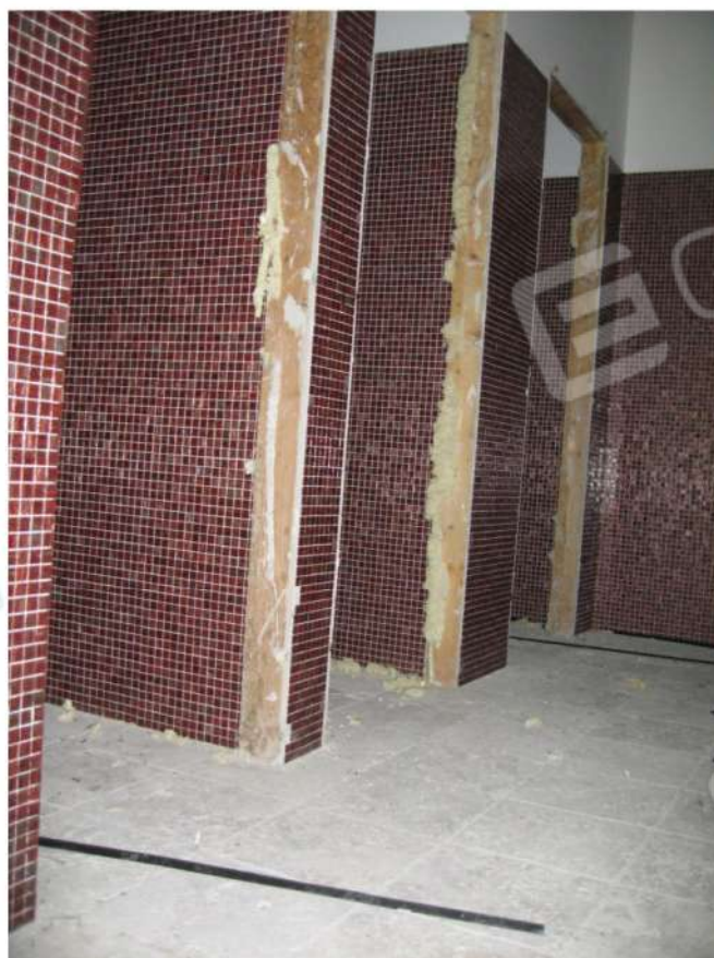
Foto n.30: immobile C, bagni asserviti all'area ristorante.
