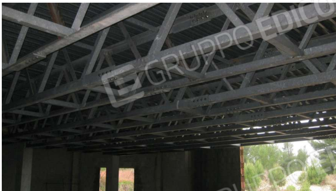
Foto n.44: vista copertura a campata unica con utilizzo di travi reticolari in acciaio al livello superiore
