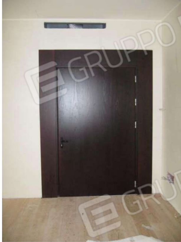
Foto n.26: immobile C. Vista porte interne. I compartimenti antincendio dell'immobile C sono ben definiti e le porte REI di separazione sono finemente rivestite in legno, come da foto.
