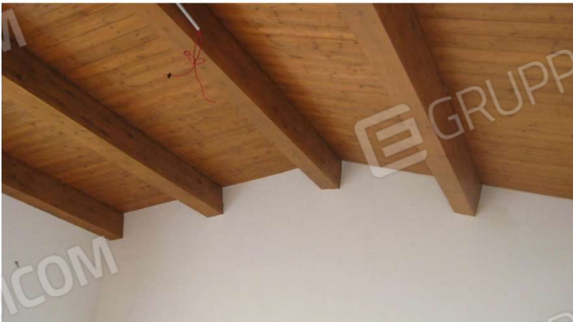
Foto n.23: copertura in legno lamellare, immobile B. Tutte le suite dell'immobile B sono dotate di copertura in legno a vista. Tre delle cinque suite sono dotate di canna fumaria e predisposizione camino.
