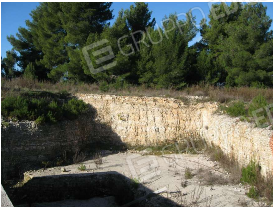
Foto n.42: scavo antistante l'immobile D, ove da progetto è prevista piscina all'aperto
