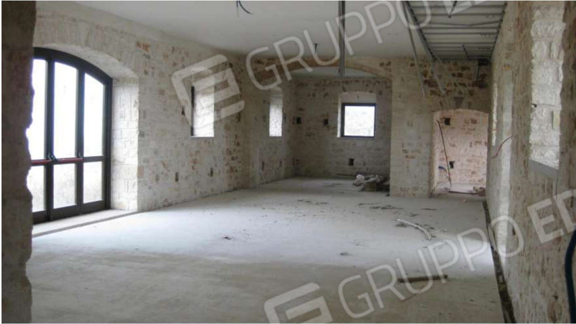
Foto n.15: interno al piano terra, immobile A. Si nota la lavorazione delle pareti interne, con pietra irregolare della muratura portante, lavorata, rifinita e lasciata a vista. La pavimentazione interna è al rustico, sono presenti tutte le predisposizioni impiantistiche e le apposite canaline dell'impianto elettrico. Causa furti, reiterati nel tempo, i fili elettrici in rame sono da ricollocare.
