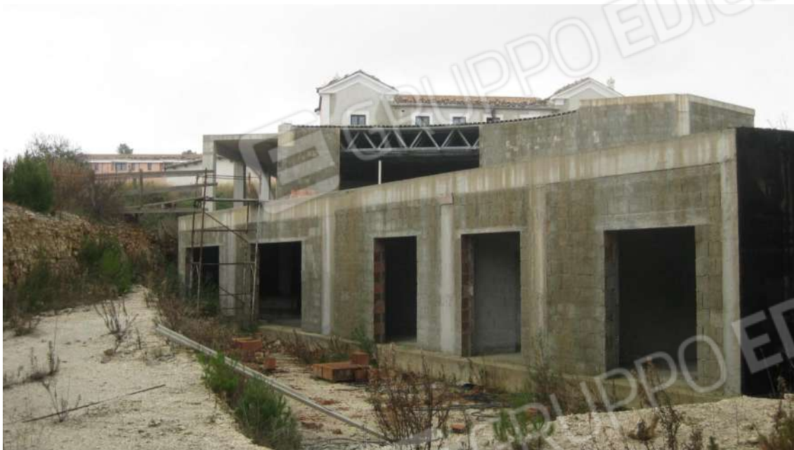
Foto n.38: immobile D, al rustico, vista complessiva dei due livelli, entrambi parzialmente interrati.
