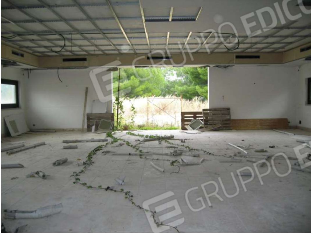
Foto n.31: Piano seminterrato . Sala ristorante dell'immobile C, con vista sul bosco circostante in direzione Nord-Est. La sala è ubicata nella parte di piano completamente fuori terra su tre lati. Mentre le cucine e i locali di servizio risultano totalmente interrati.
