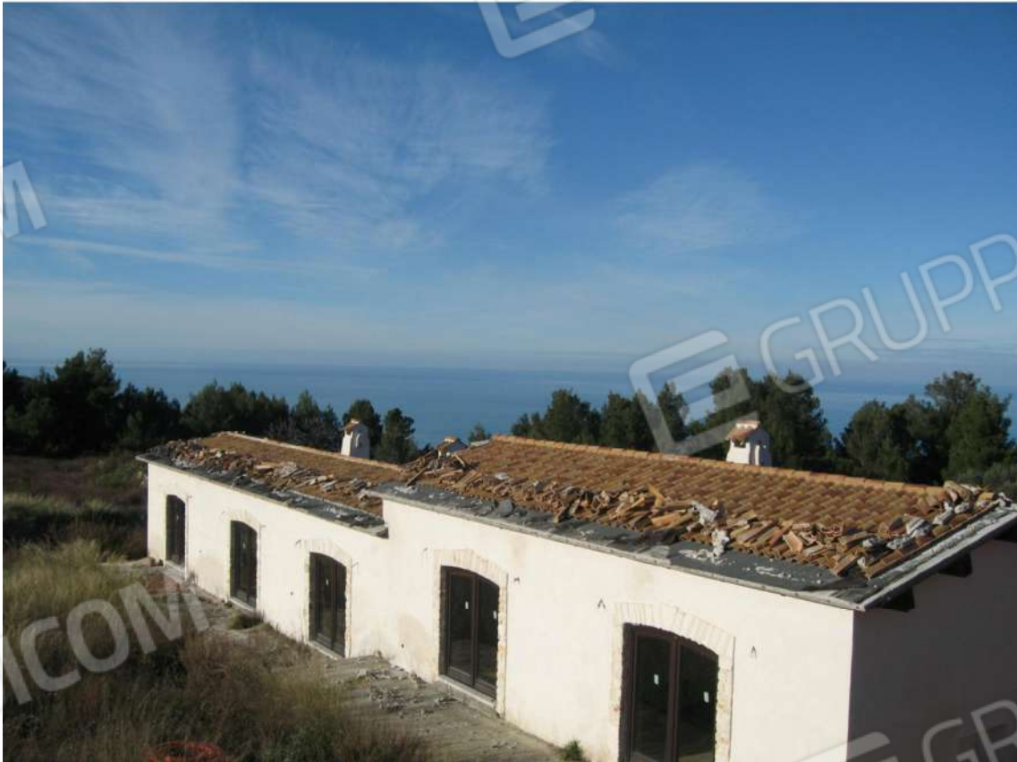
Foto n.18: vista d'insieme dell'immobile B. La foto scattata da una delle camere dell'immobile C, permette di cogliere la grande panoramicità di cui gode l'area, con la vista della macchia mediterranea, di aree a bosco e del mare sullo sfondo. Anche la copertura dell'immobile B è stata oggetto di furto delle scossaline e delle gronde in rame.
