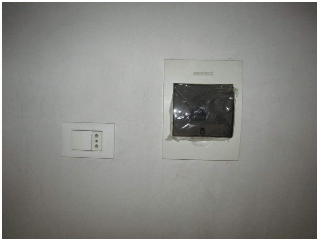
FOTO 15.7 - LOTTO 15 – BOX AUTO IN FOGGIA – PRIMO PIANO INTERRATO – INTERNO
