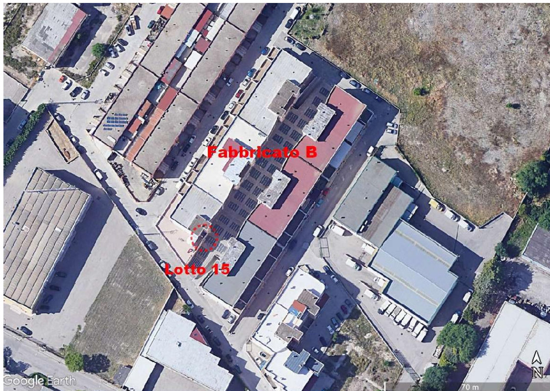
Fig. 1 – LOTTO 15 - Localizzazione dell'immobile all'interno del Fabbricato B sito in Foggia alla via Manfredonia angolo Via delle Casermette - Ortofoto
