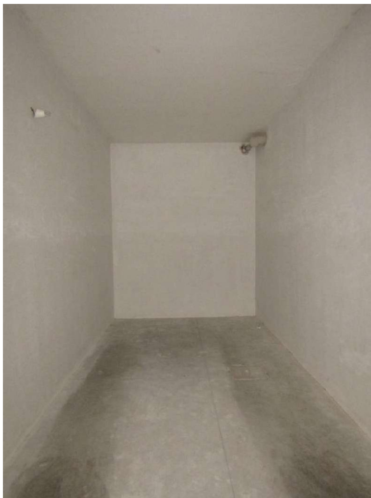
FOTO 15.5 - LOTTO 15 – BOX AUTO IN FOGGIA – PRIMO PIANO INTERRATO – INTERNO
