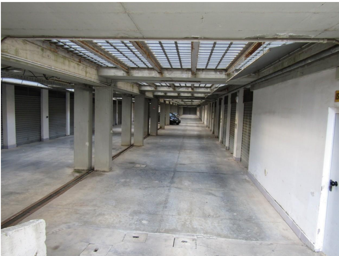
FOTO 16.3 - LOTTO 16 – BOX AUTO IN FOGGIA – PRIMO PIANO INTERRATO
