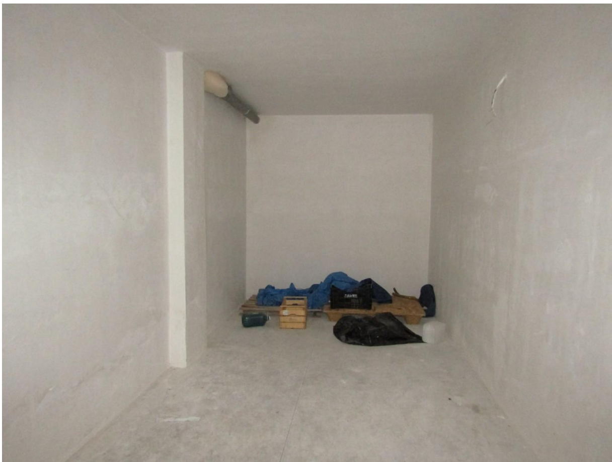
FOTO 16.7 - LOTTO 16 – BOX AUTO IN FOGGIA – PRIMO PIANO INTERRATO – INTERNO
