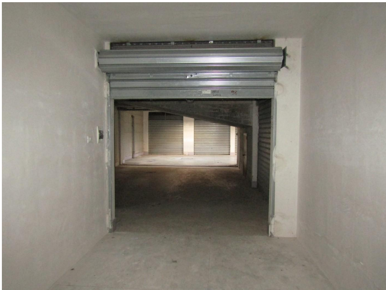
FOTO 16.8 - LOTTO 16 – BOX AUTO IN FOGGIA – PRIMO PIANO INTERRATO – INTERNO
