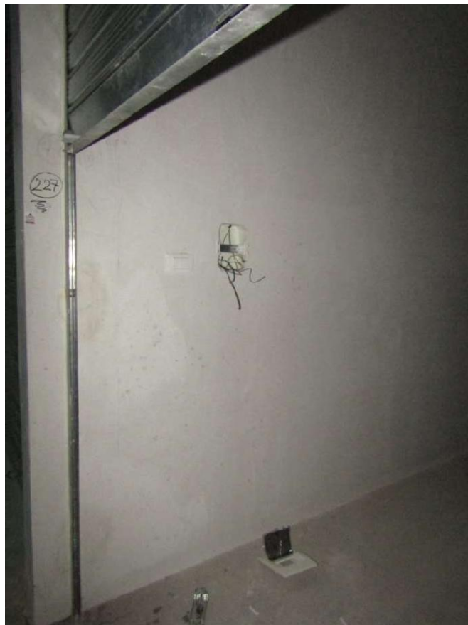
FOTO 28.8 - LOTTO 28 – BOX AUTO IN FOGGIA – PRIMO PIANO INTERRATO – INTERNO
