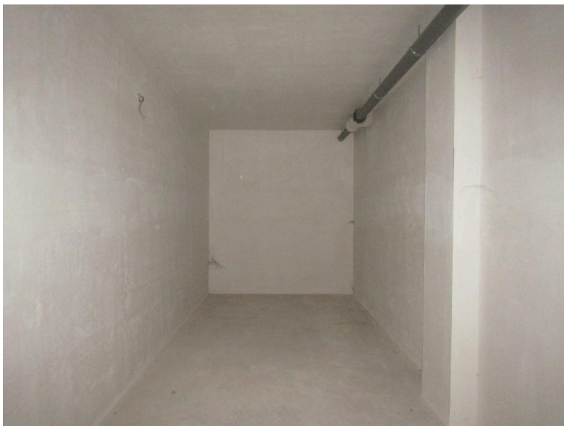
FOTO 28.6 - LOTTO 28 – BOX AUTO IN FOGGIA – PRIMO PIANO INTERRATO – INTERNO
