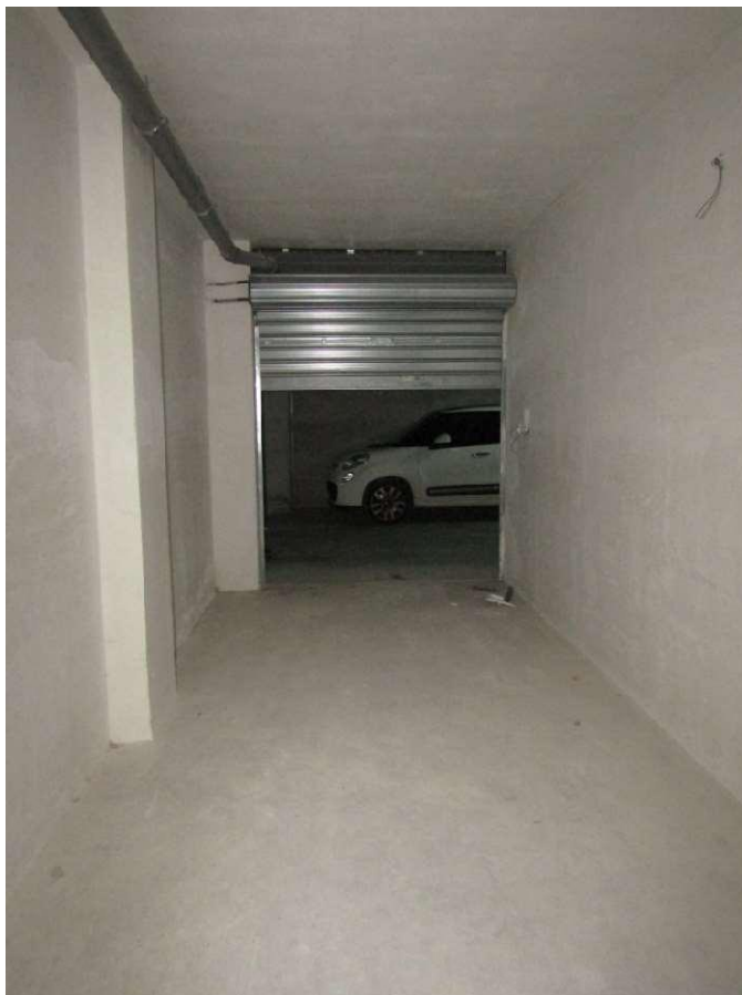
FOTO 28.7 - LOTTO 28 – BOX AUTO IN FOGGIA – PRIMO PIANO INTERRATO – INTERNO
