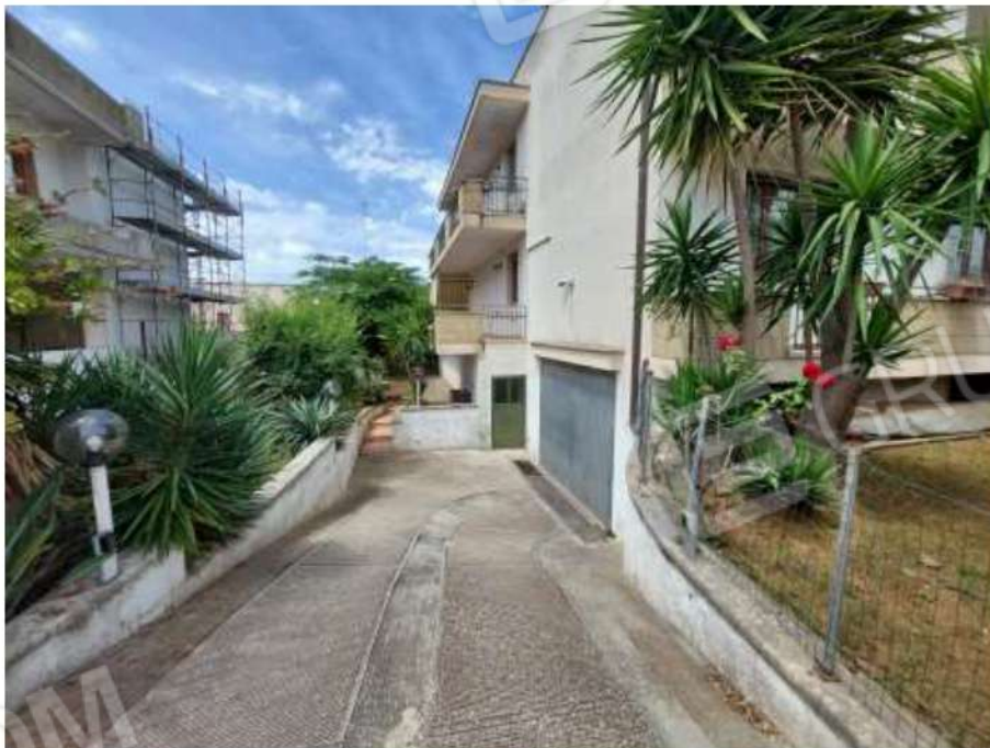
Foto 15 – rampa e prospetto garage di copertura.
