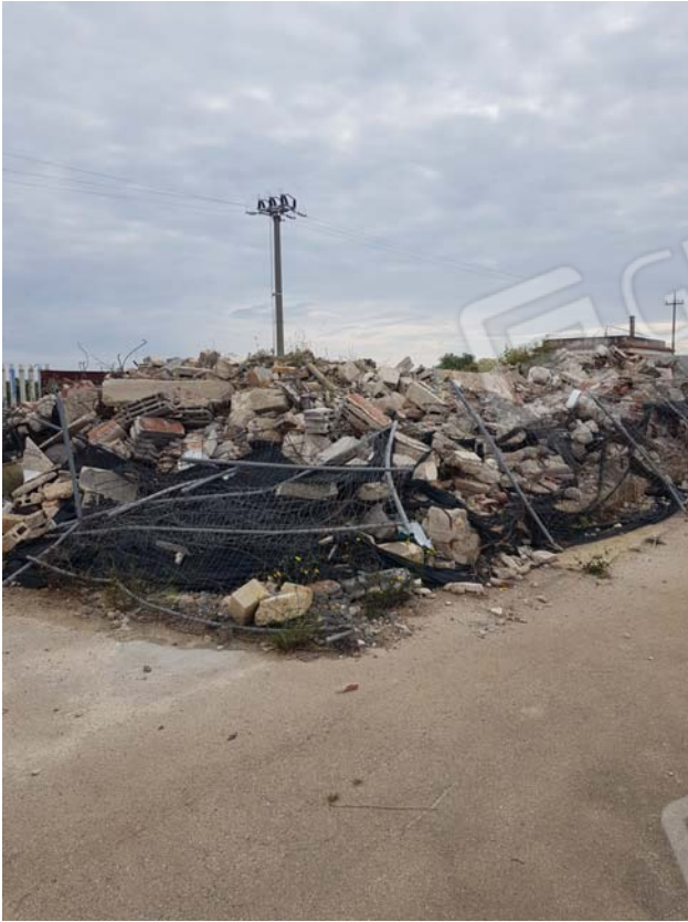
macerie della villa crollata
