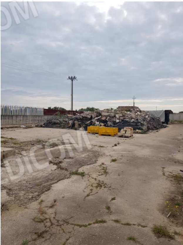
macerie della villa crollata
