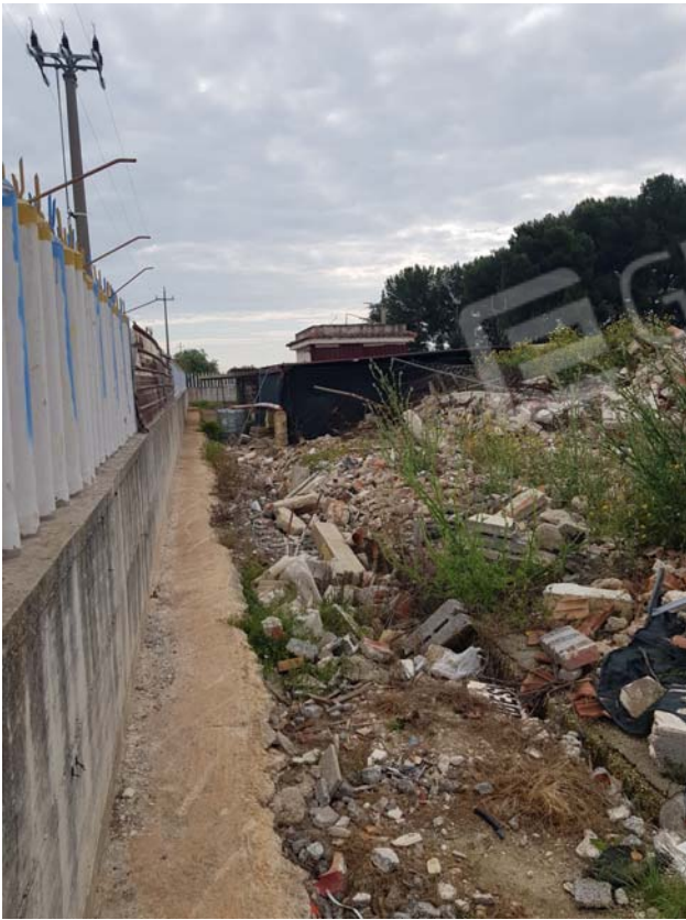
macerie della villa crollata
