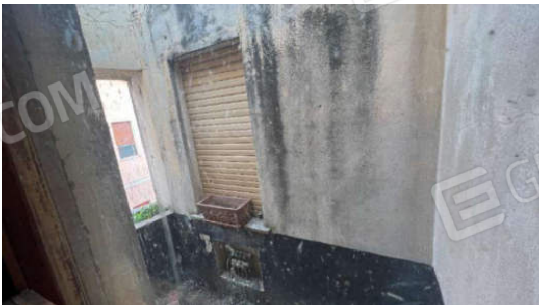
Figura 19 – Viste del piano terzo del fabbricato – subalterno 6 – su “Balcone”
