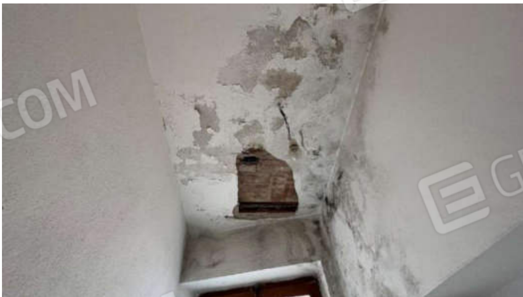
Figura 8 – Viste del piano secondo del fabbricato – subalterno 6 – su “Bagno”
