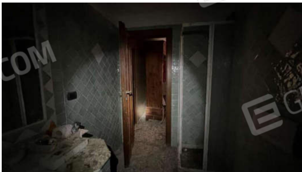
Figura 13 – Viste del piano terzo del fabbricato – subalterno 6 – su “Bagno 1”
