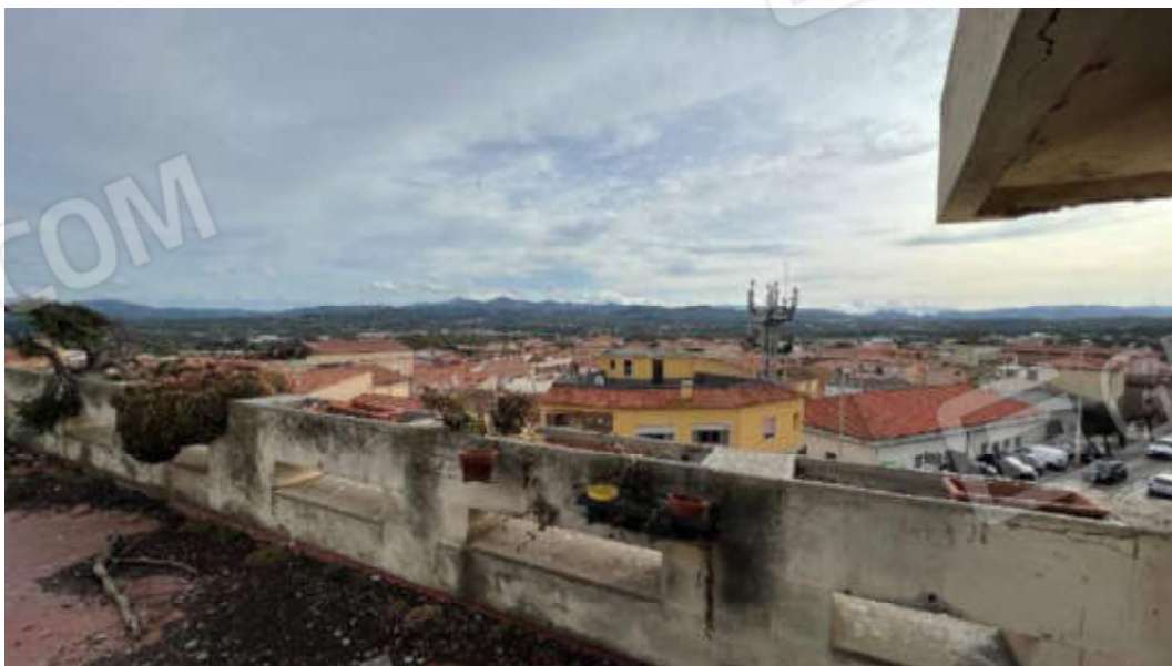
Figura 21 – Viste del piano terzo del fabbricato – subalterno 6 – su “Terrazza”
