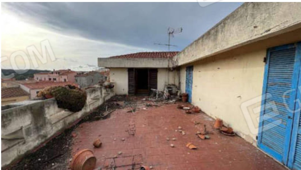
Figura 20 – Viste del piano terzo del fabbricato – subalterno 6 – su “Terrazza”
