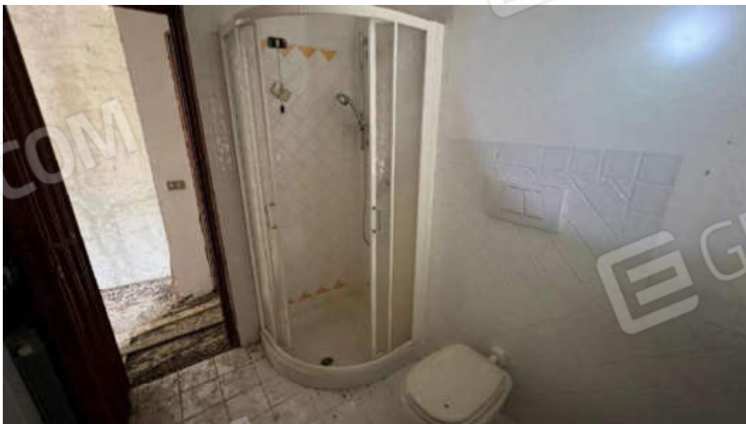
Figura 17 – Viste del piano terzo del fabbricato – subalterno 6 – su “Bagno 3”
