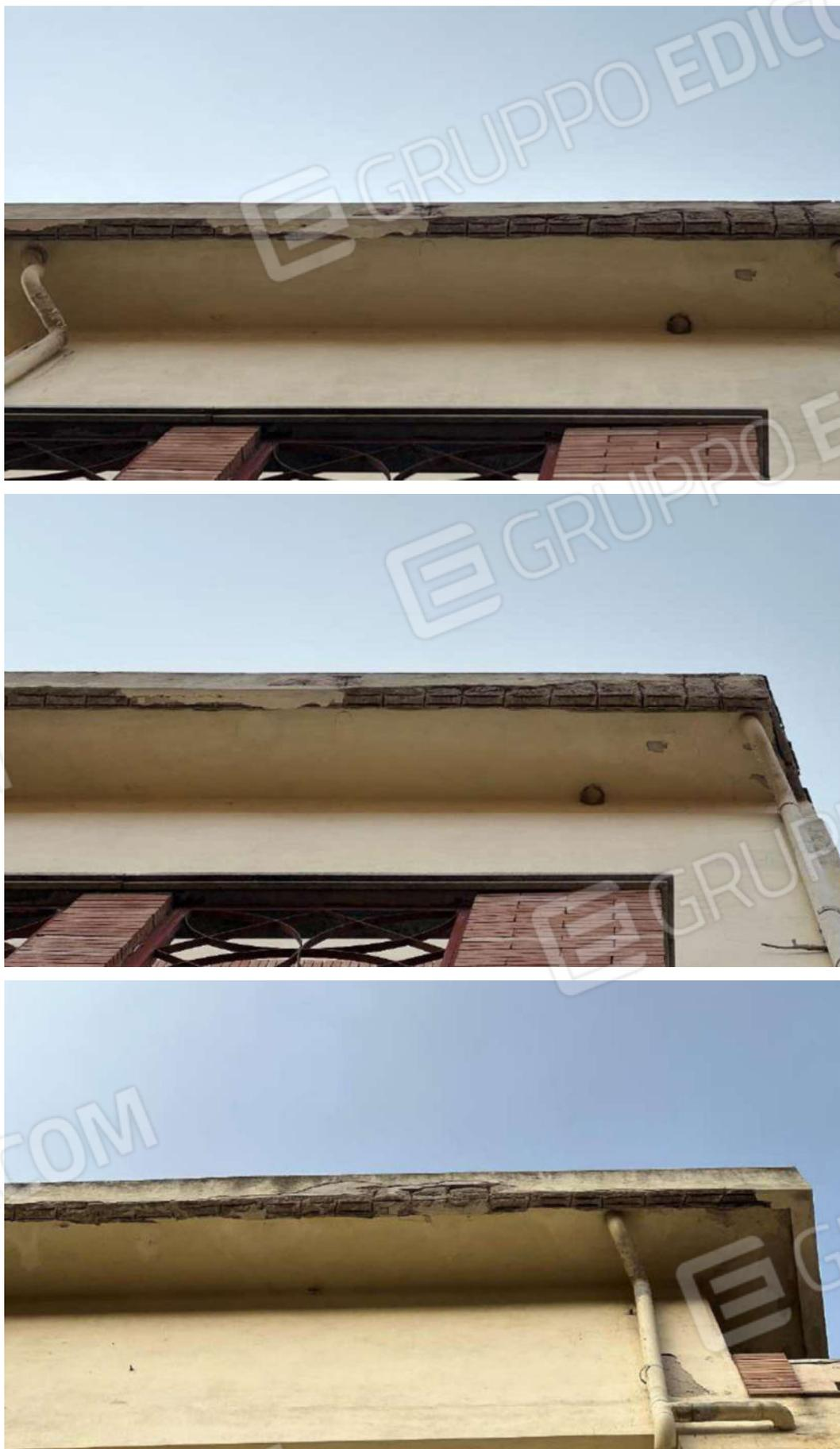
*Figura 4 – Dettagli dello stato di conservazione dei cornicioni in copertura*
