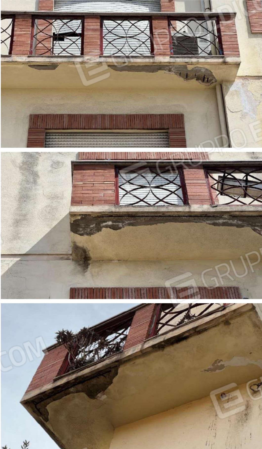
*Figura 3 – Dettagli delle condizioni di conservazione degli intradossi dei balconi*
