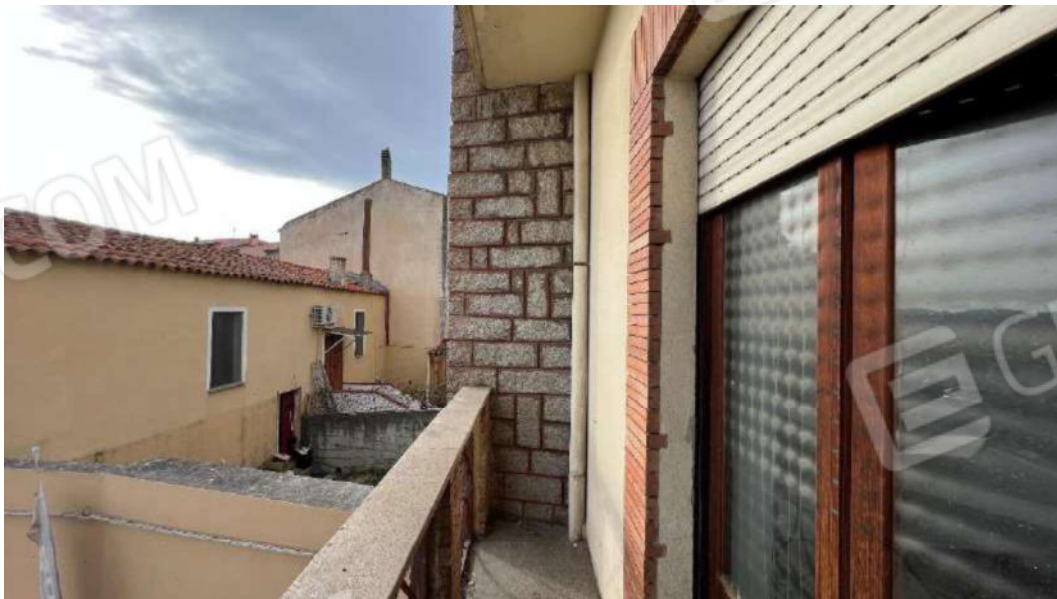
Figura 15 – Viste del piano primo del fabbricato – subalterno 9 – su “Balcone 3”
