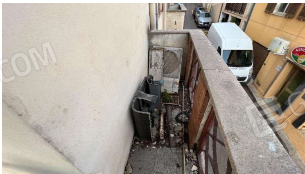
Figura 14 – Viste del piano primo del fabbricato – subalterno 9 – su “Balcone 2”
