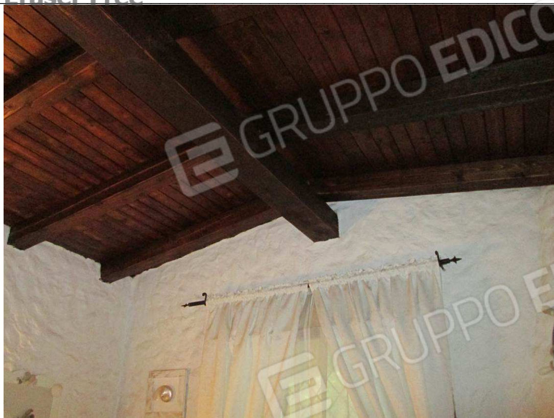
Foto n° 5 – Vista sulla copertura –
