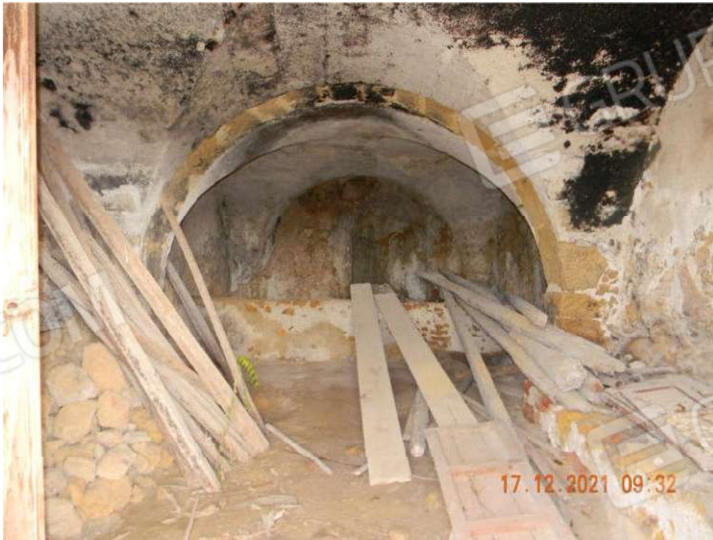
FOTO 18 - Vano al piano seminterrato (piano terra a valle).
