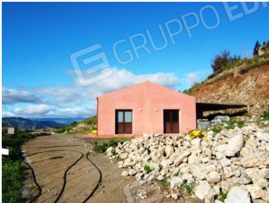
Foto n. 13: Lotto 2 – Spazi esterni circostanti il fabbricato
