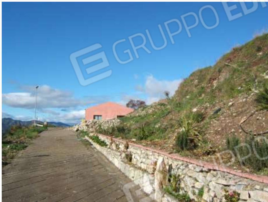
Foto n. 11: Lotto 2 – Percorso carrabile interno
