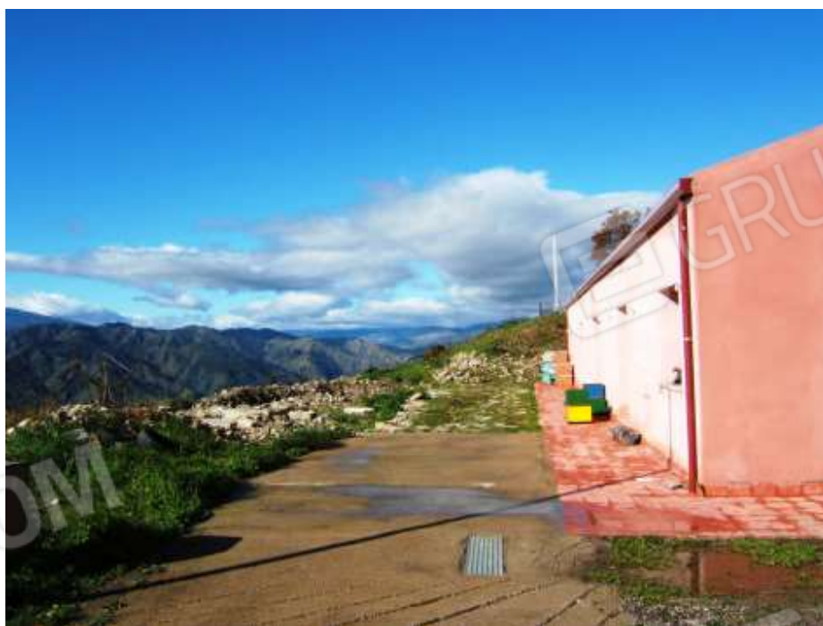
Foto n. 16: Lotto 2 – Spazi esterni circostanti il fabbricato
