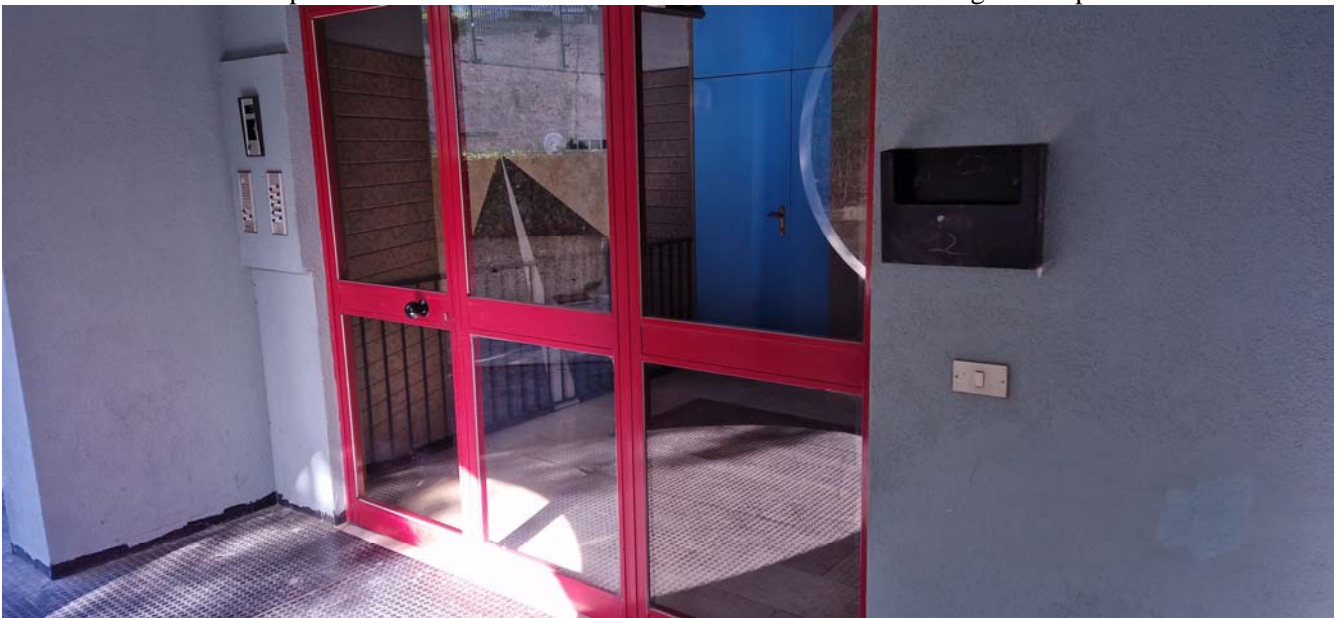
Foto 4: Portone di ingresso alla scala G ove è ubicata la cantina censita al foglio 100 part 1681 sub 44
