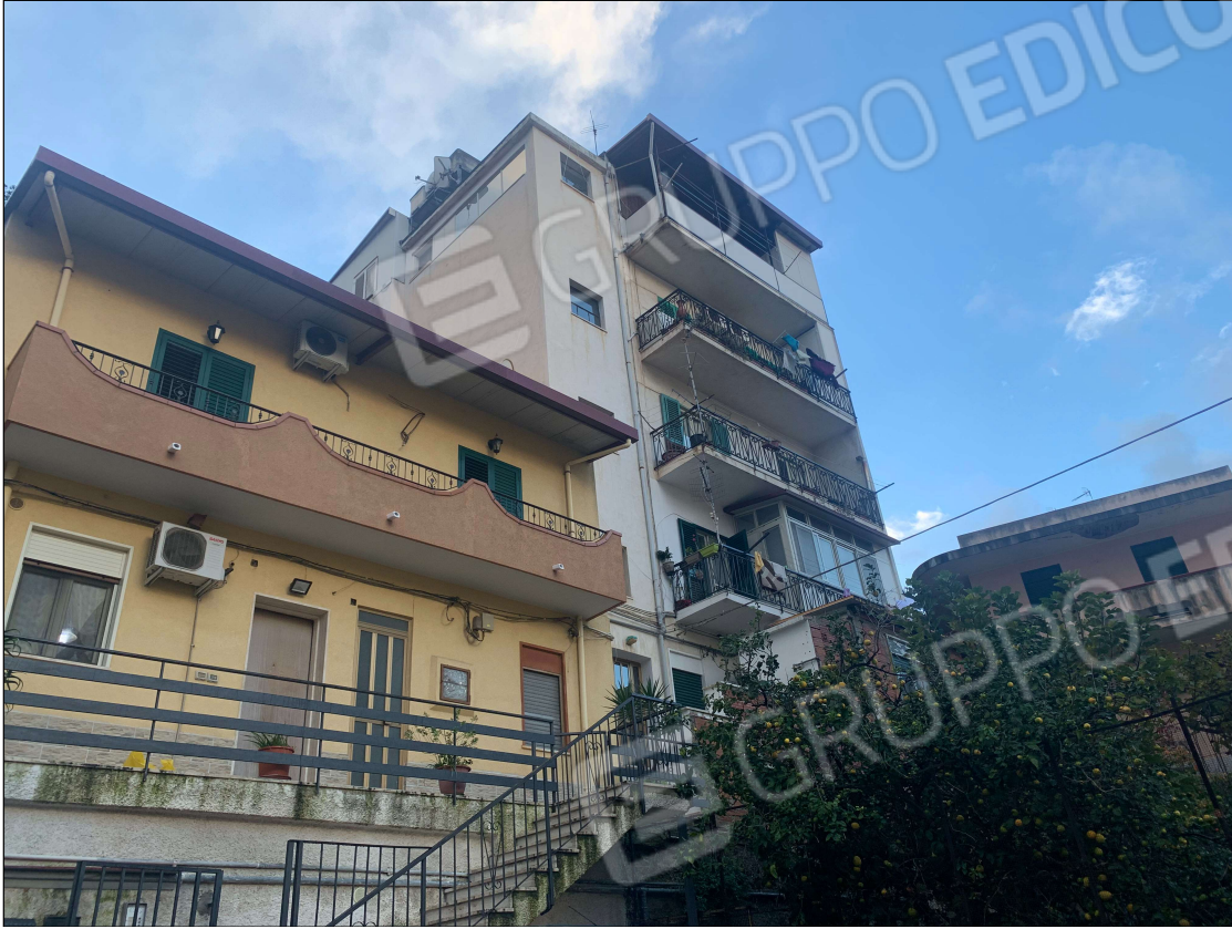
Foto n° 01 – fabbricato in cui, al secondo piano, ricade l'immobile
