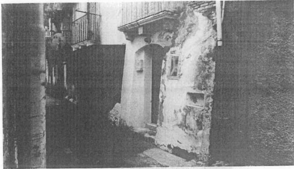
Foto n°5 (10.05.2011) Accesso dalla via San Giovannello al piano primo.
