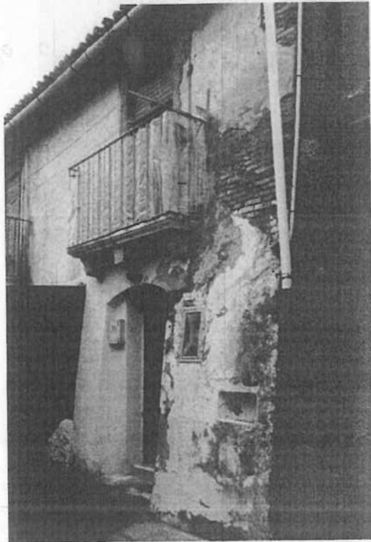
Foto n°6 (10.05.2011) Particolare dell'accesso al piano primo.
