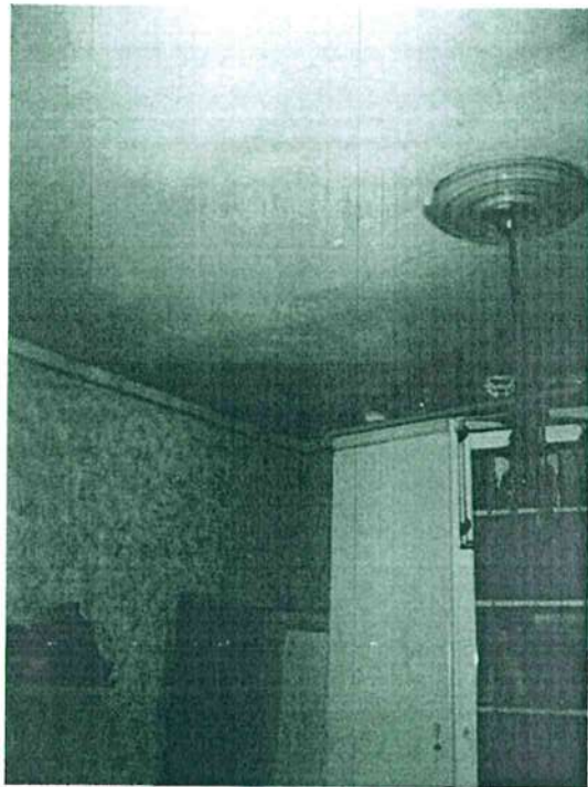
Foto n°20 (05.03.2008) Particolare soffitto camera.
