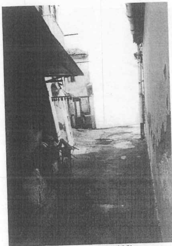
Foto n°2 (05.03.2008) Particolare via San Giovannello.
