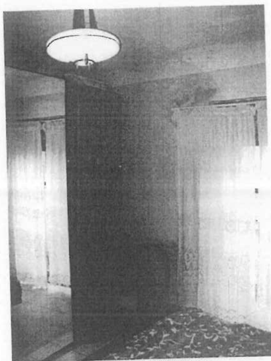
Foto n°18 (05.03.2008) Particolare soffitto camera matrimoniale.
