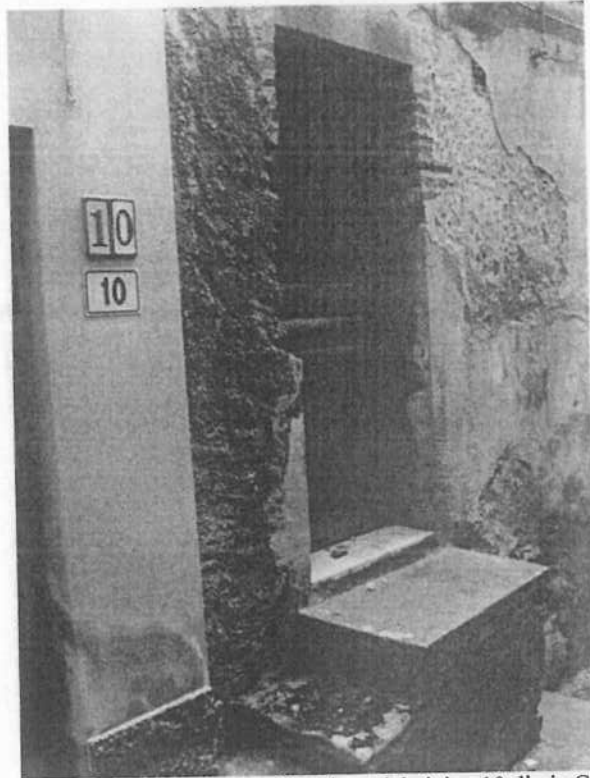
Foto n° 3 – Portone d'ingresso al primo piano dal civico 10 di via Costa Gullo.
