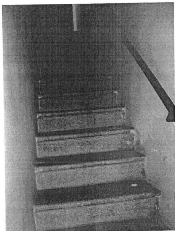
Foto n° 15 - Scala che porta dal piano terra al piano primo.
