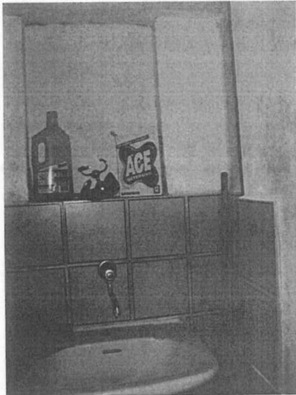
Foto n° 9 – Wc a piano terra.
