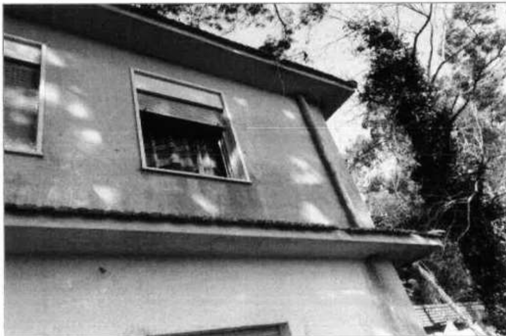
FOTO 6 Prospetto Est piano primo
