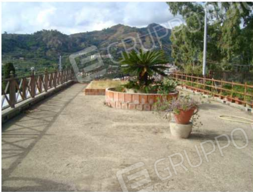
Lastrico solare a copertura di una porzione di capannone
