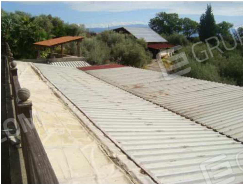
Copertura di una parte del capannone
