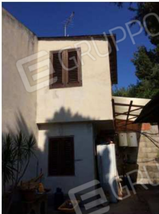
Foto n. 3 Prospetto lato est
