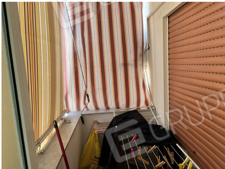
Foto 8 - porzione di balcone lato cucina - non chiuso a veranda -
