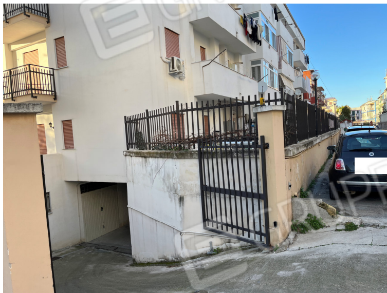
Foto 18 Ingresso carrabile scantinato
