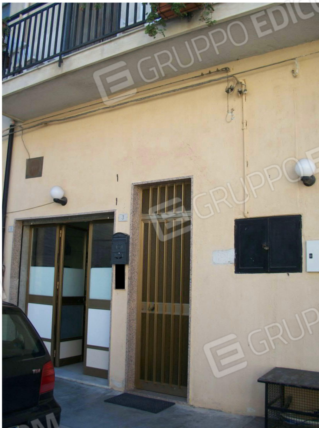
Foto N° 2: Ingresso secondario (dalla cucina) al civ.1
