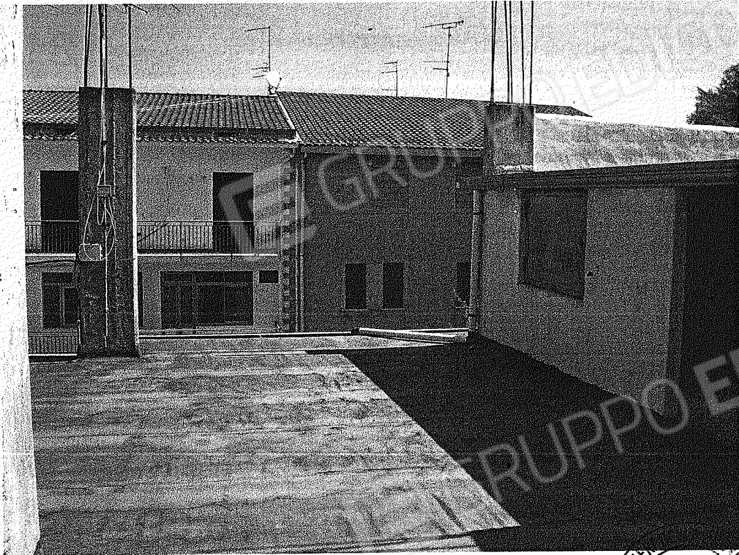
Foto N° 3/4/5/6: Vedute del piano di copertura
