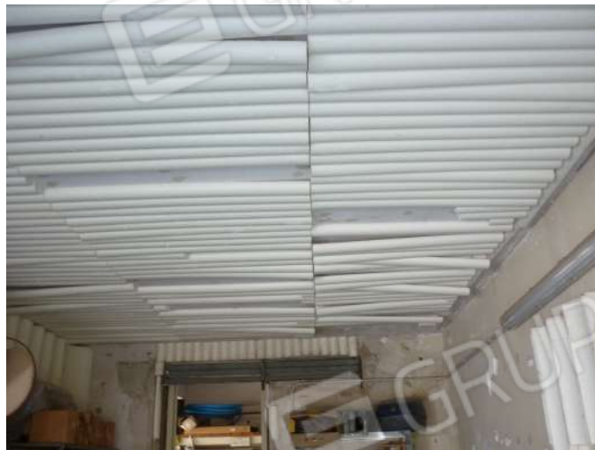
Foto n. 5 – Vista interna del locale box
