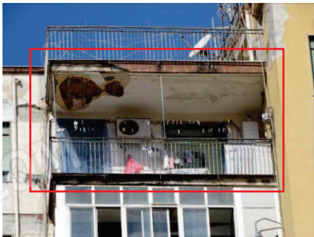
Retroprospetto. Particolare del balcone dell'immobile con accesso dalla cucina.
