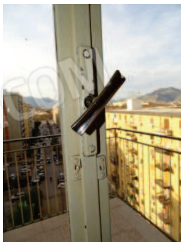
Camera da letto matrimoniale. Particolare dell'infisso esterno in metallo
