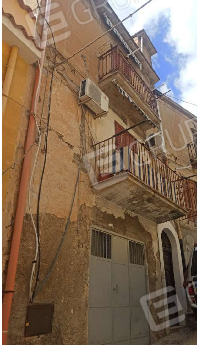
Prospetto da Via Cordicella 51
