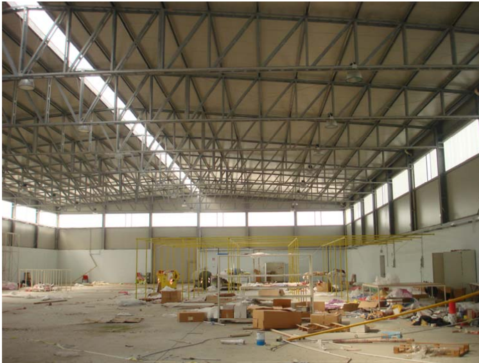
Fotografia n. 23 – Vista interno capannone.
