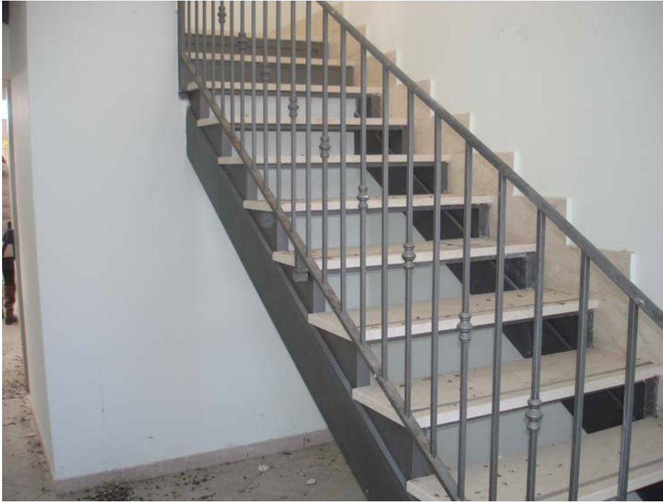
Fotografia n. 31 – Palazzina Uffici – Piano terra - Scala di accesso al primo piano.
