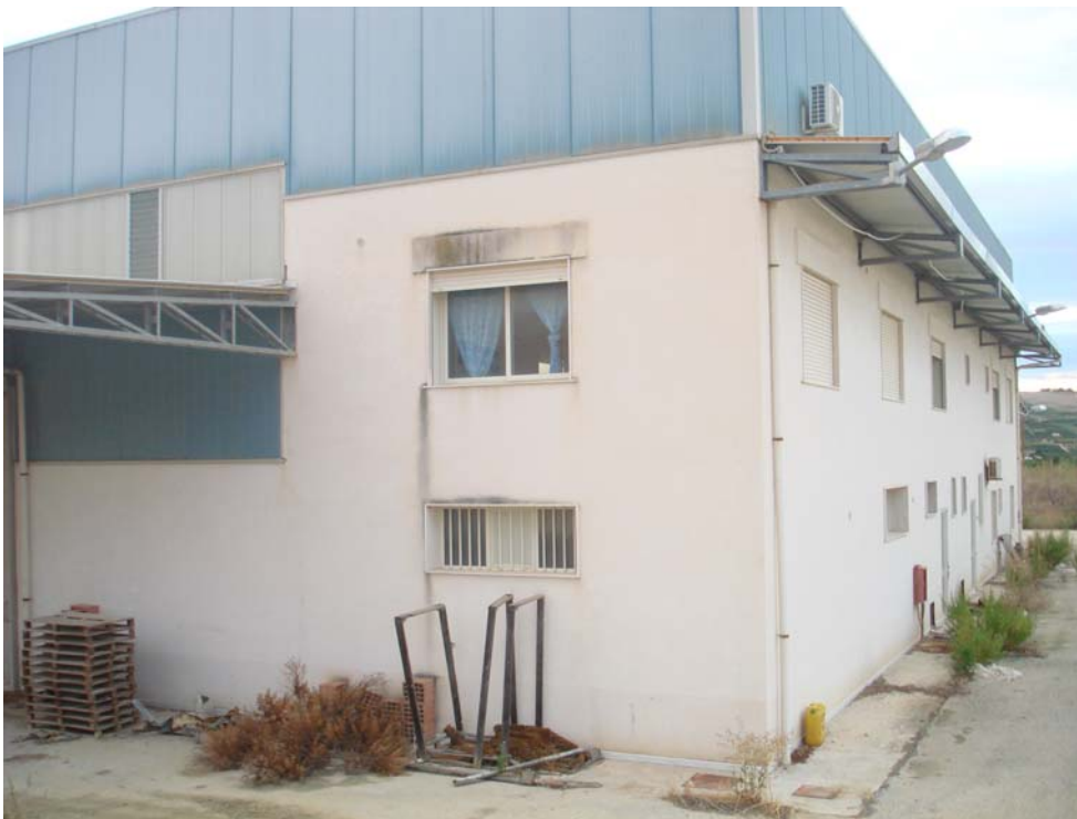
Fotografia n. 12 – Particolare pensilina lato Nord.
