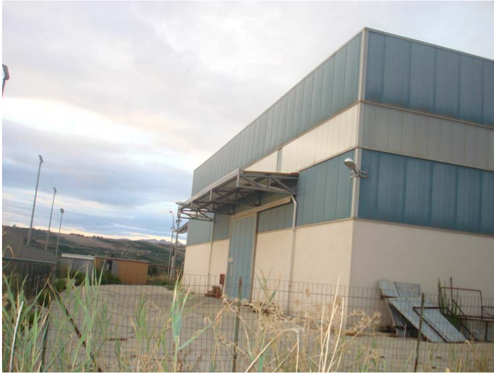
Fotografia n. 19 – Vista prospetto lato Sud.
