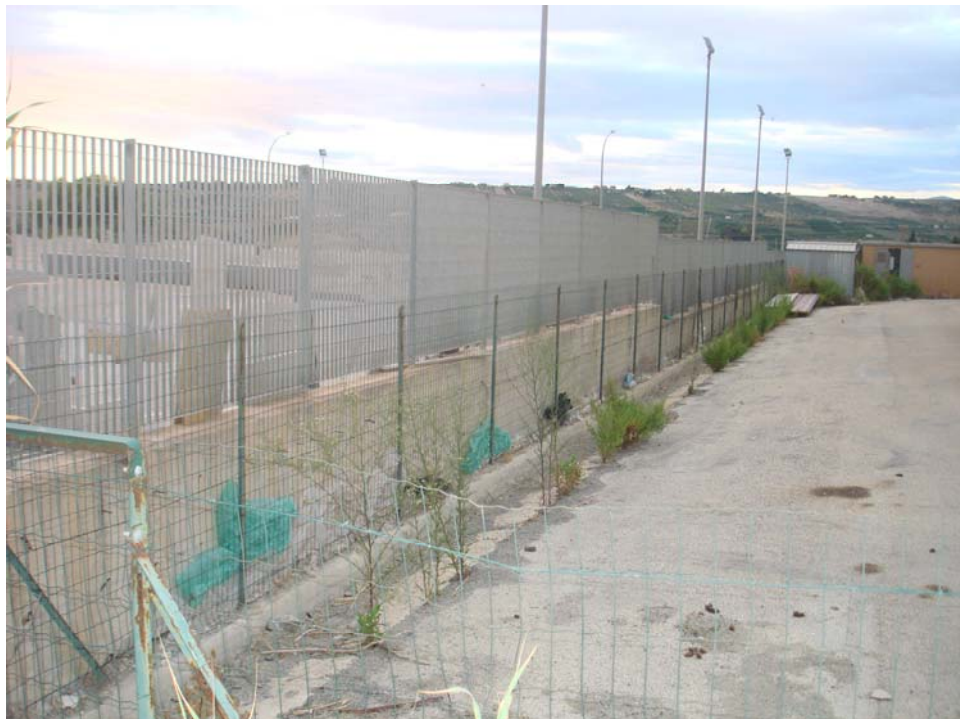
Fotografia n. 22 – Particolare recinzione lato Sud.
