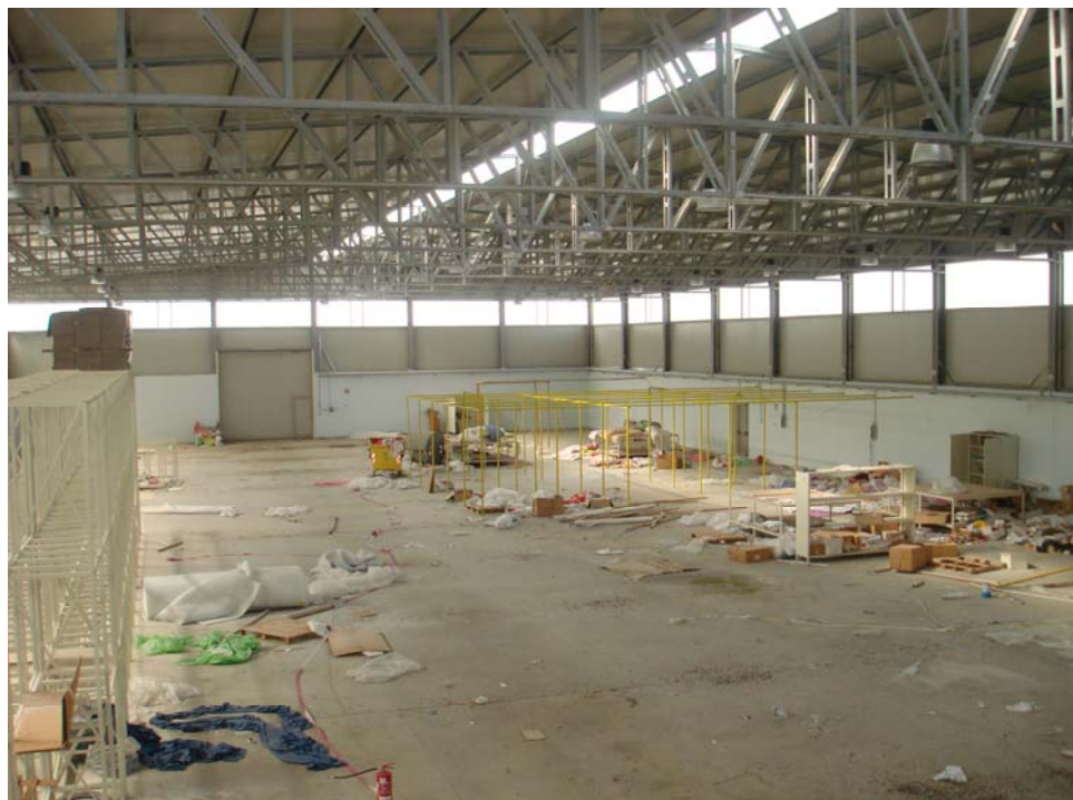
Fotografia n. 24 – Vista interno capannone..
