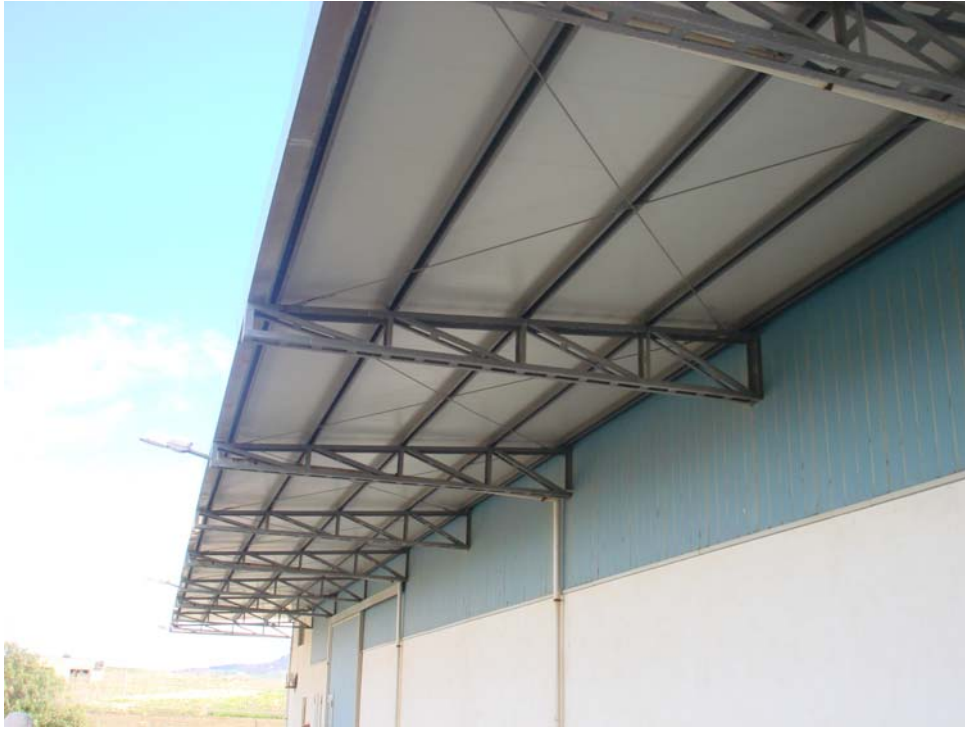
Fotografia n. 9 – Particolare pensilina prospetto Est.
