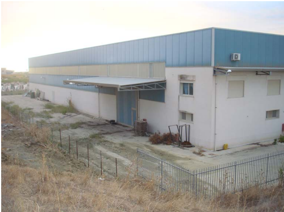
Fotografia n. 16 – Particolare pensilina lato Ovest.
