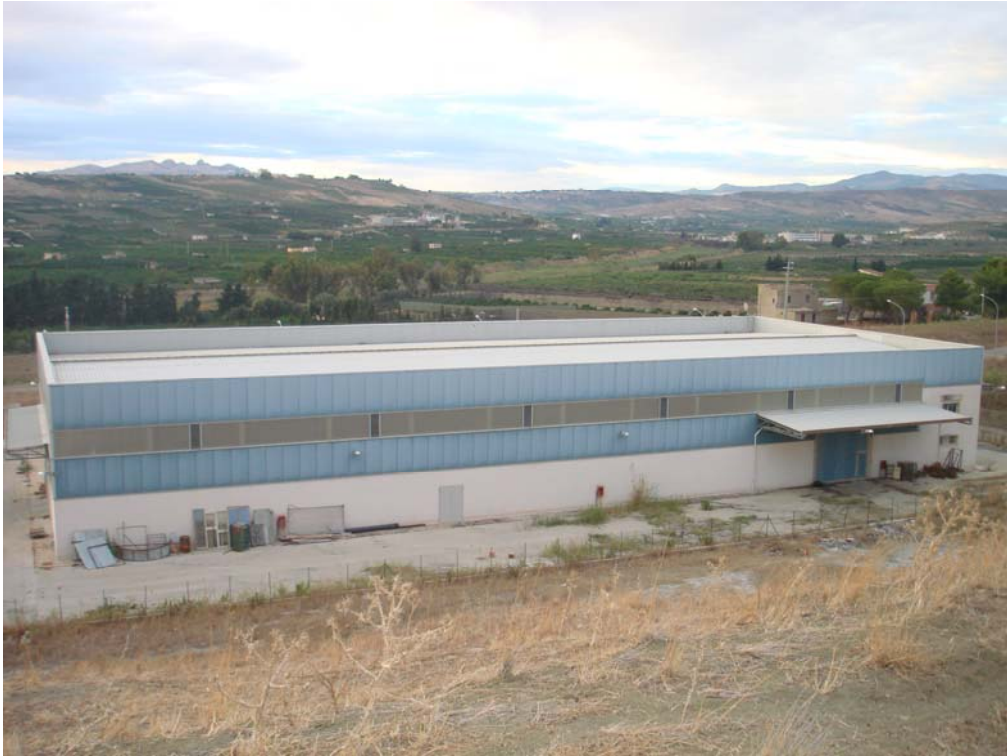
Fotografia n. 15 – Prospetto retrostante (lato Ovest)
