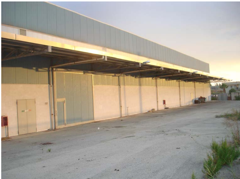
Fotografia n. 8 – Prospetto principale (lato Est), parte destra.
