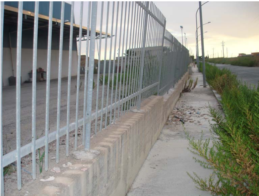
Fotografia nn. 3 e 4 – Vista della recinzione sul fronte principale (lato Est).
