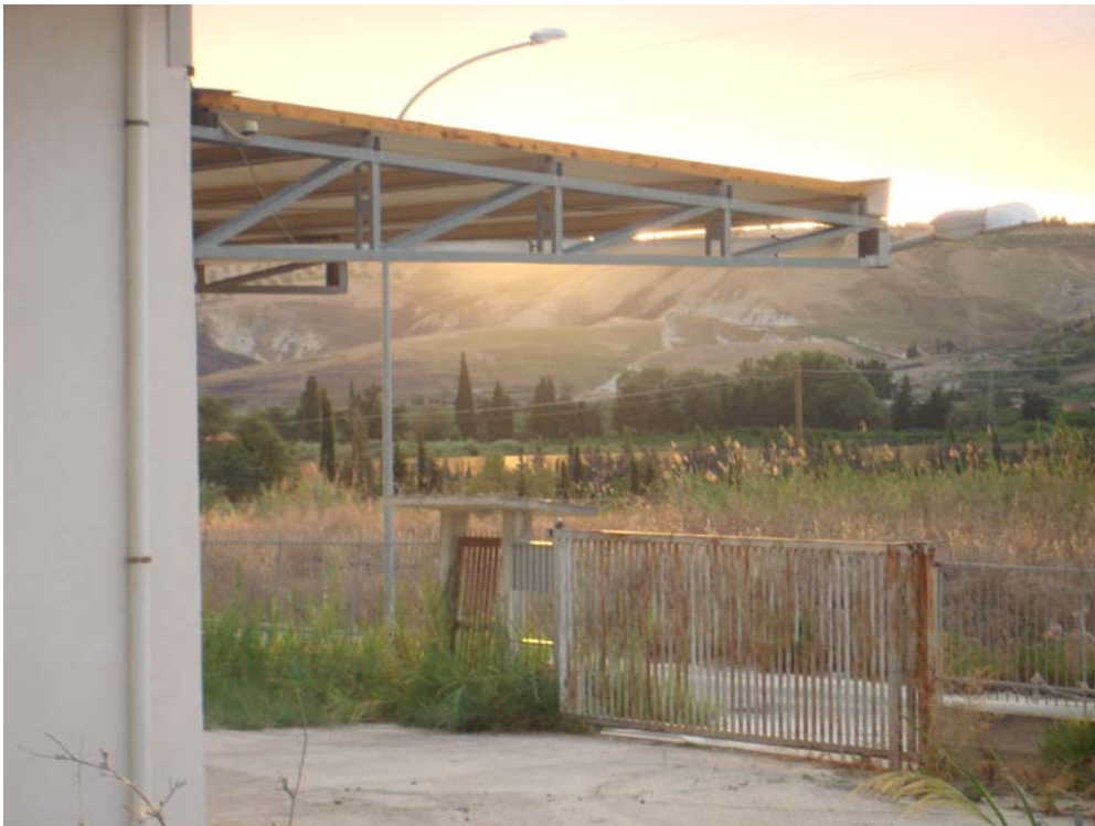
Fotografia n. 10 – Particolare pensilina prospetto Est.
