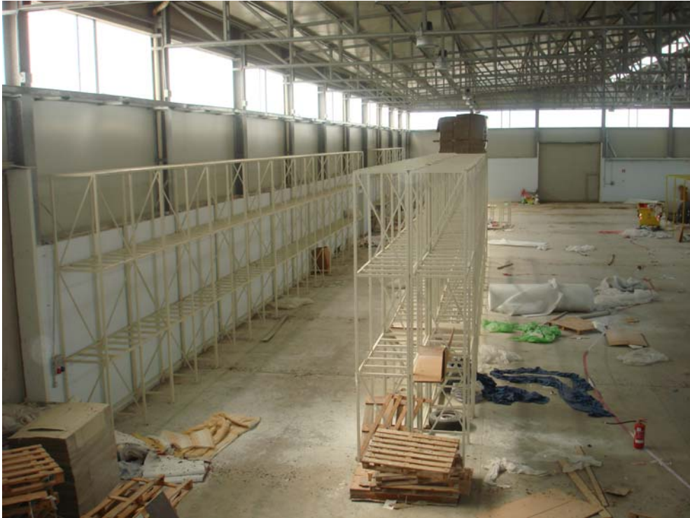
Fotografia n. 25 – Vista interno del capannone. in direzione Ovest.
