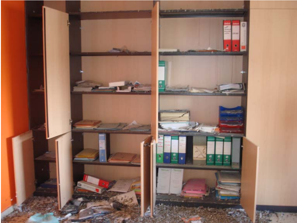
Fotografia n. 33 – Palazzina Uffici – 1° piano.
