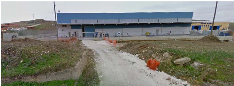
Fotografia n. 6 – Vista prospetto principale (lato Est).
