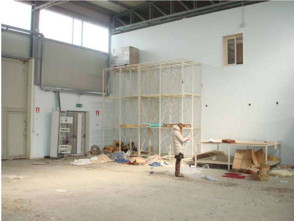
Fotografia n. 27 – Interno del capannone con vista verso la palazzina Uffici.
