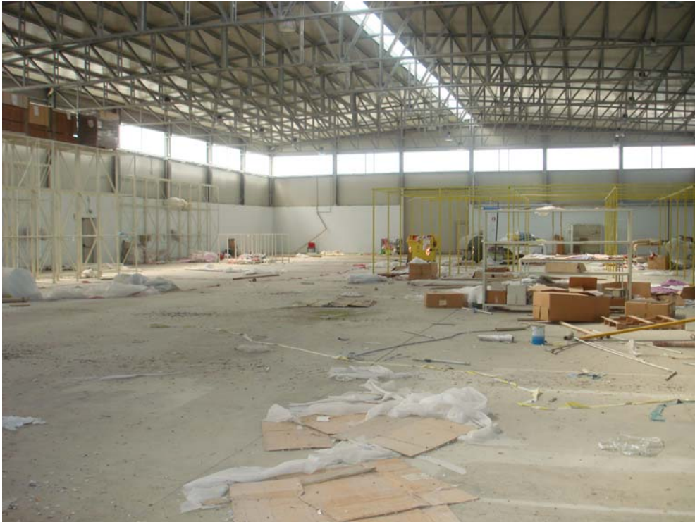
Fotografia n. 26 – Vista interno del capannone, in direzione Ovest.
