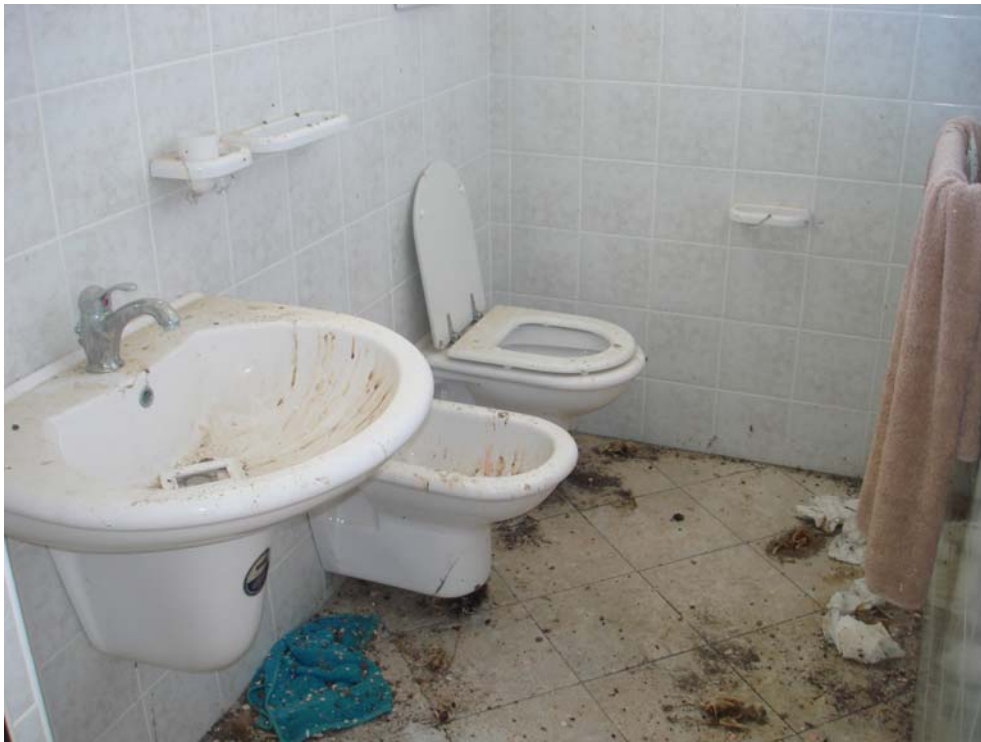
Fotografia n. 34 – Palazzina Uffici – 1° piano. - Wc.
