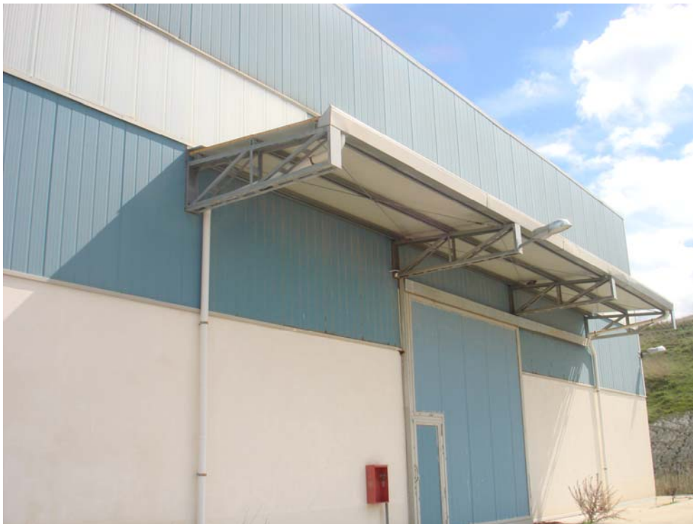
Fotografia n. 20 – Particolare tettoia lato Sud.
