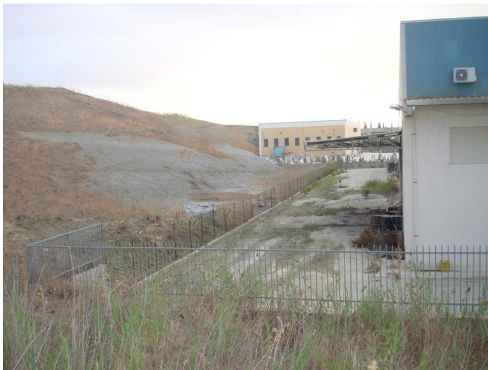
Fotografia n. 17 – Vista piazzali della parte retrostante. - Prospetto Ovest.
