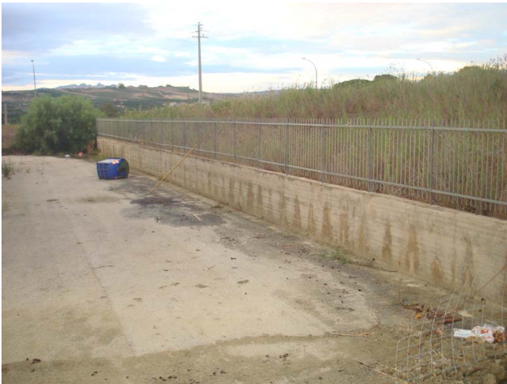
Fotografia n. 14 – Vista recinzione sul lato Nord.
