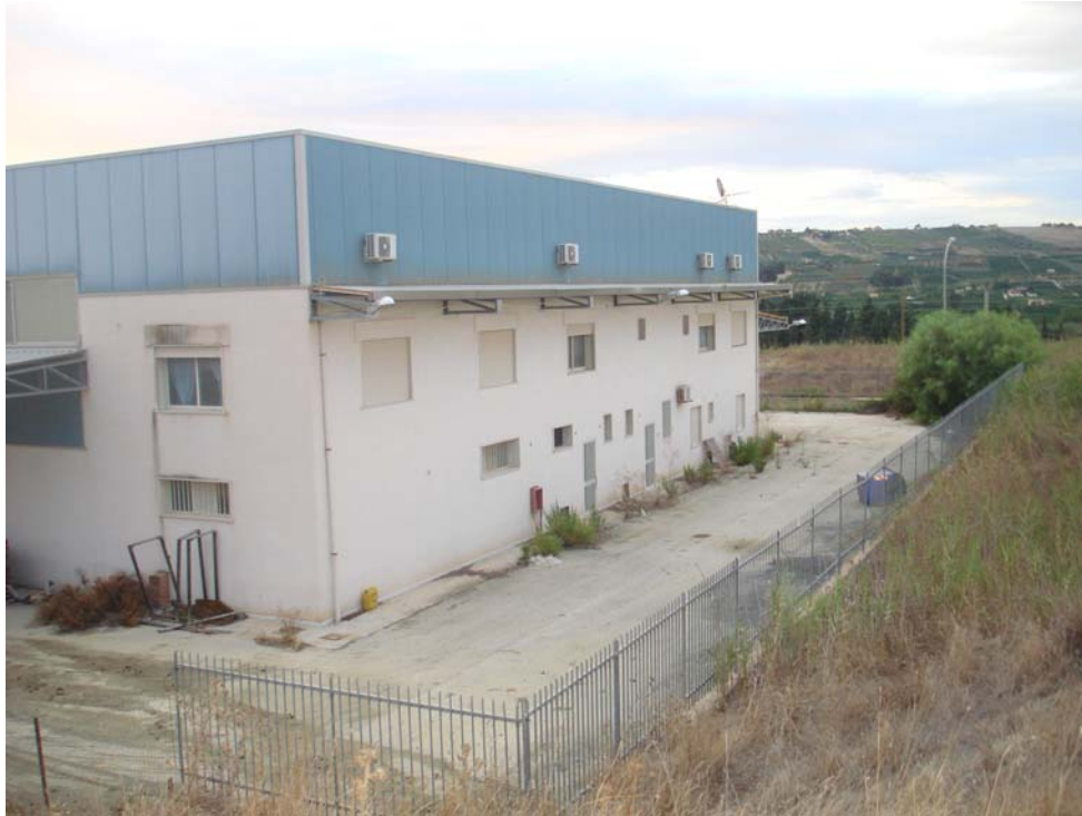
Fotografia n. 11 – Vista piazzali e prospetto dal lato Nord (palazzina Uffici).
