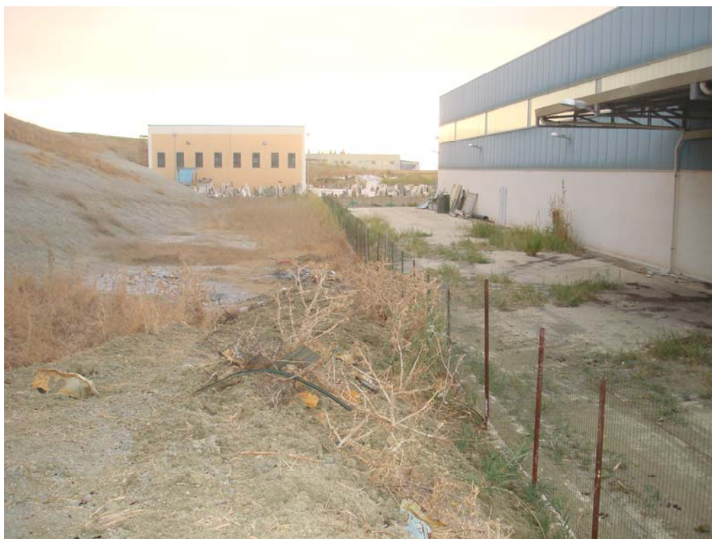
Fotografia n. 18 – Vista recinzione lato Ovest.
