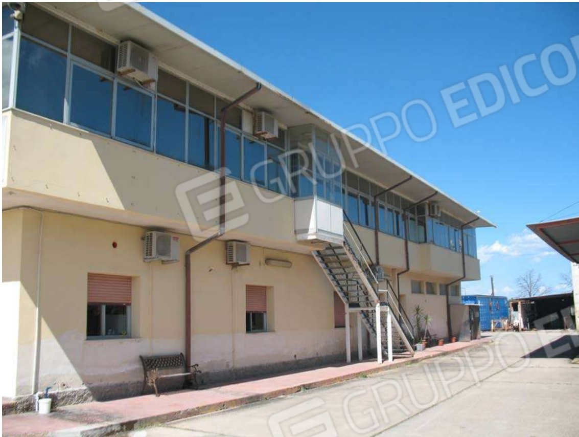
Foto 7 - Prospetto Est: Corpo uffici e servizi (B)
