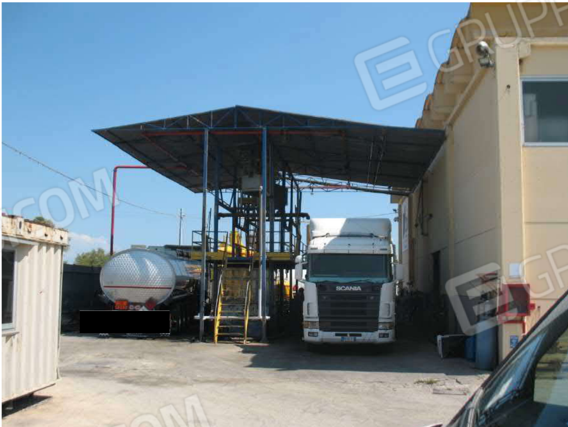
Foto 26 - Stazione metrologica (C) (Lato Sud)
