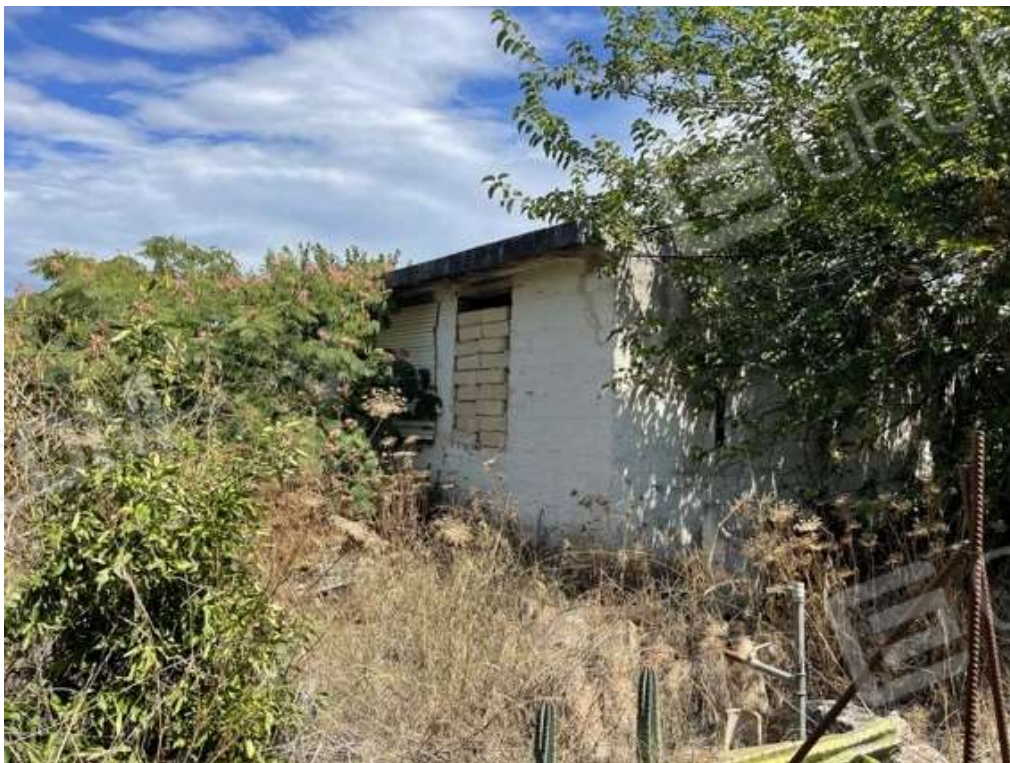
Fotografia D.66 - Magazzino: prospetto sud
