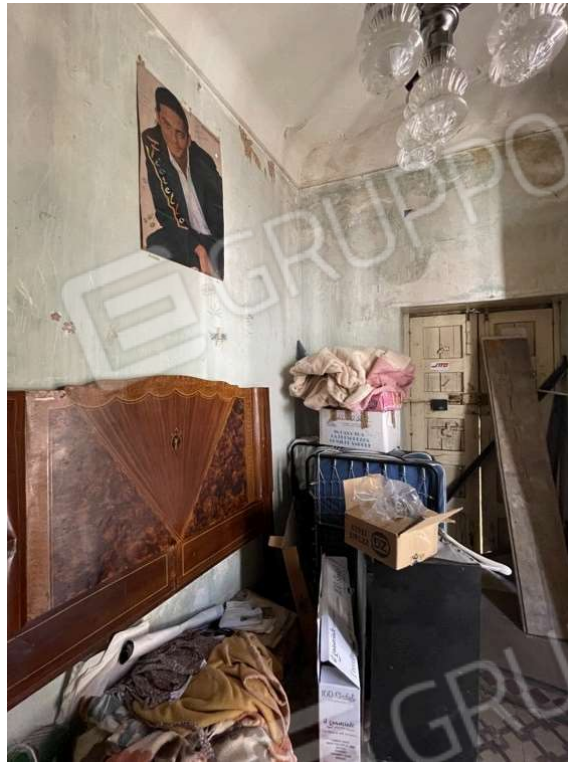
Fotografia D.15 - Piano primo: lato ovest
