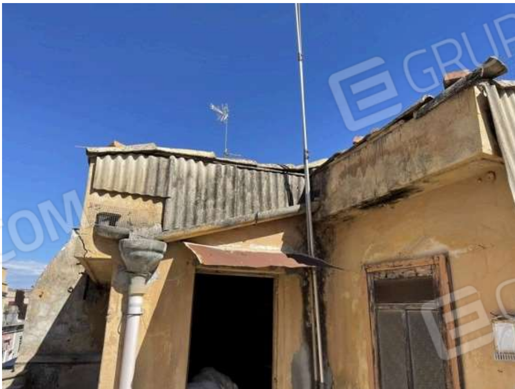
Fotografia D.26 - Copertura
