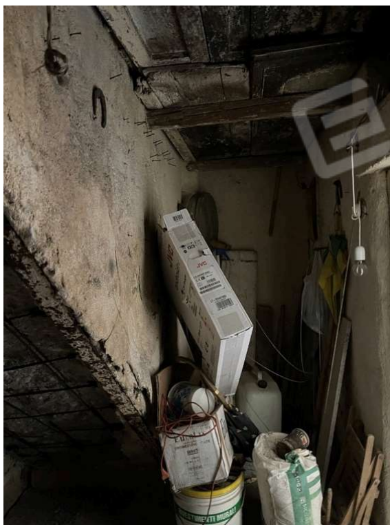
Fotografia D.8 - Scala e locale sotto-scala
