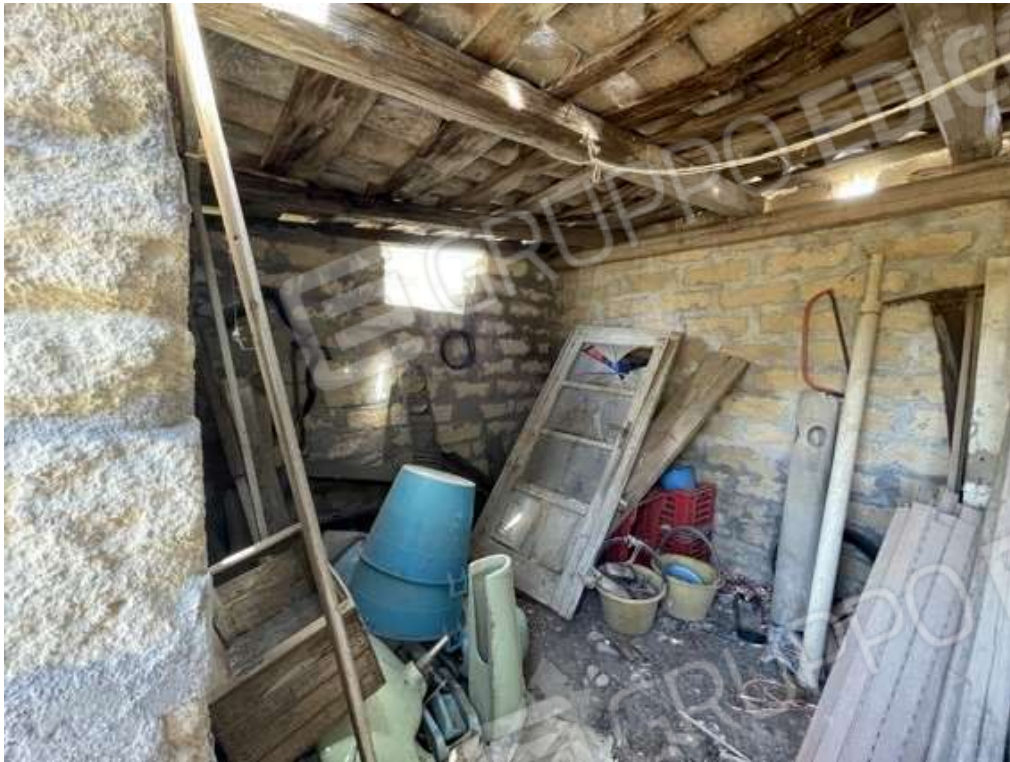
Fotografia D.57 - Copertura
