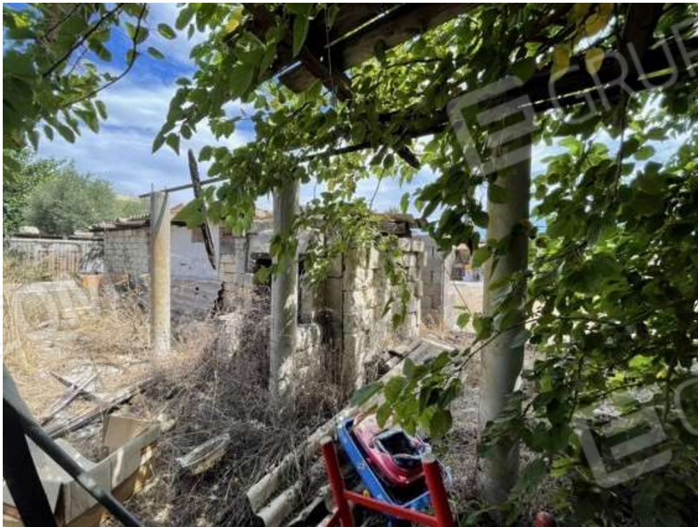
Fotografia D.60 - Veranda esterna al magazzino con pilastri in cemento armato
