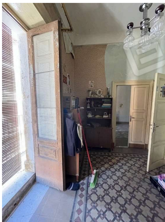
Fotografia D.14 - Piano primo: balcone che si affaccia sulla via Gioachino Rossini- lato ovest
