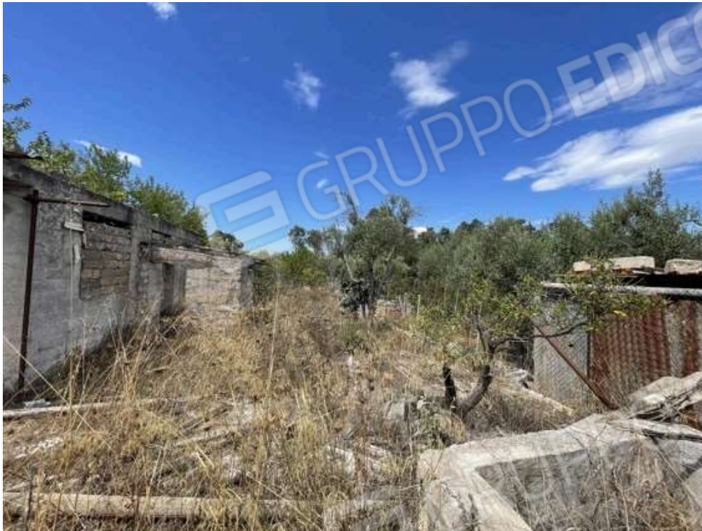
Fotografia D.53 - Esterno: lato nord del magazzino
