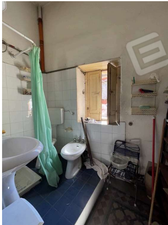
Fotografia D.20 - Piano primo: bagno
