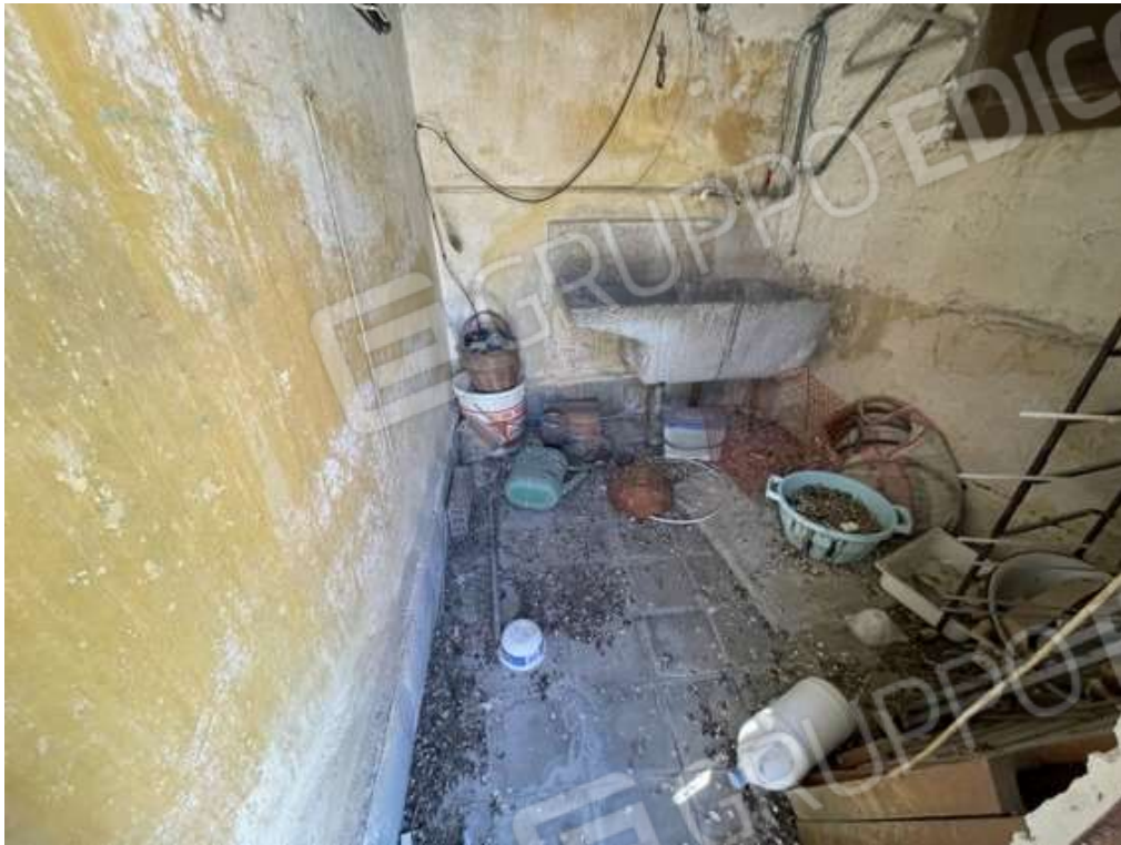
Fotografia D.29 - Piano secondo: interni del manufatto
