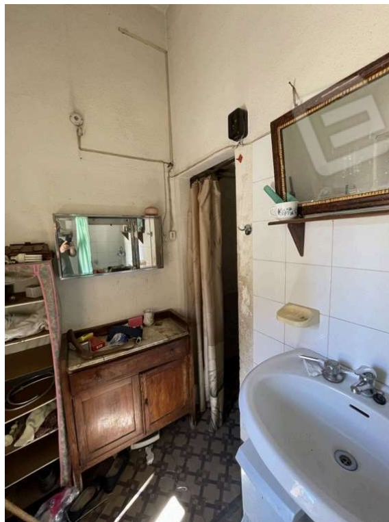
Fotografia D.18 - Piano primo: bagno
