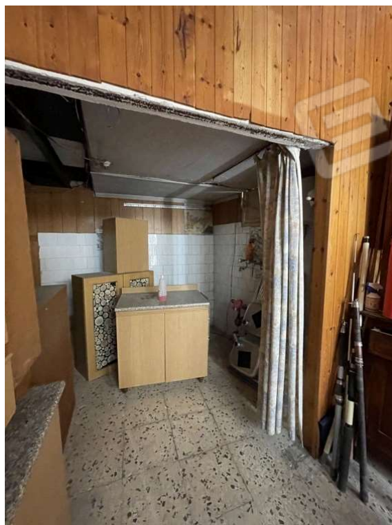
Fotografia D.6 - Piano terra: lato prospiciente via E. Marchiafava
