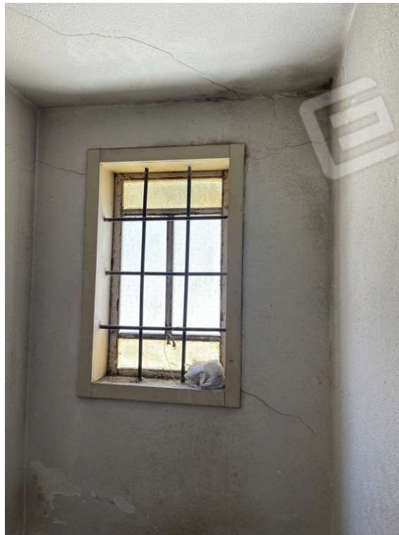
Fotografia D.36 - Scala che collega il piano primo e il piano secondo
