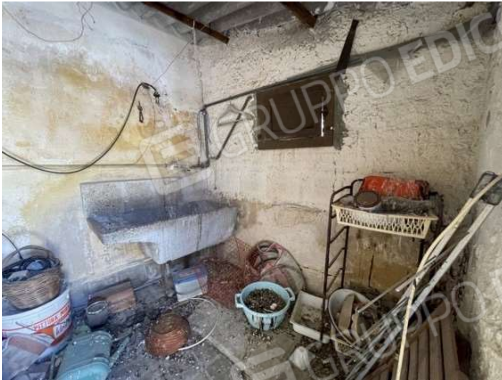
Fotografia D.31 - Piano secondo: interni del manufatto
