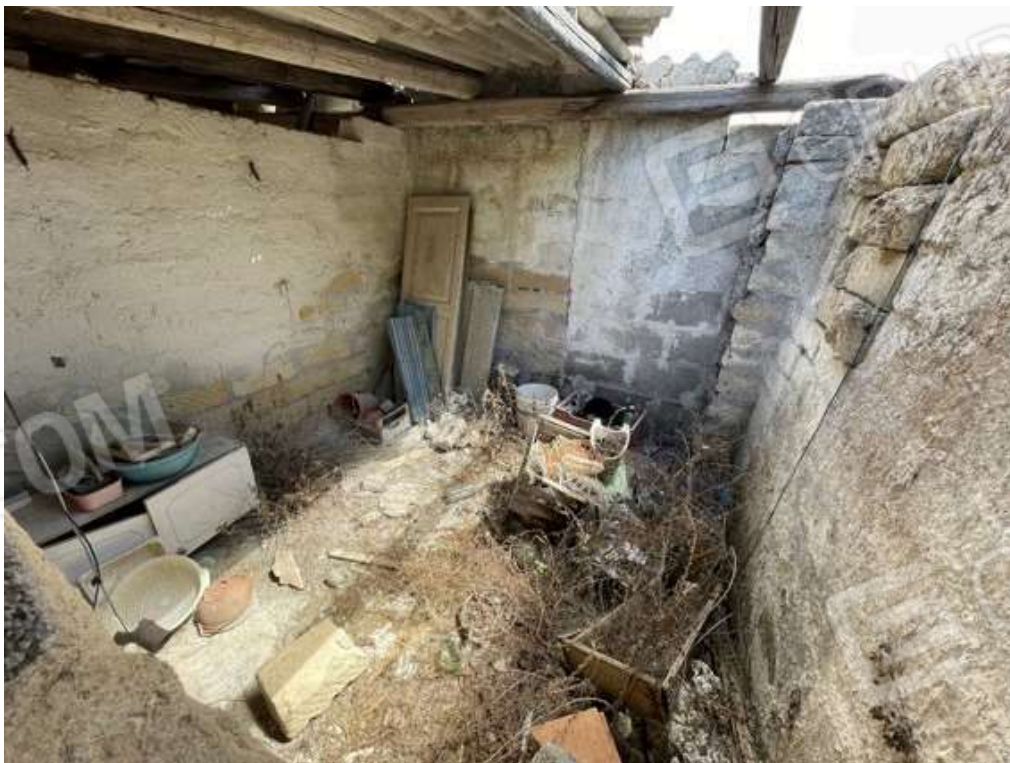
Fotografia D.58 - Manufatto: Interno pareti e copertura
