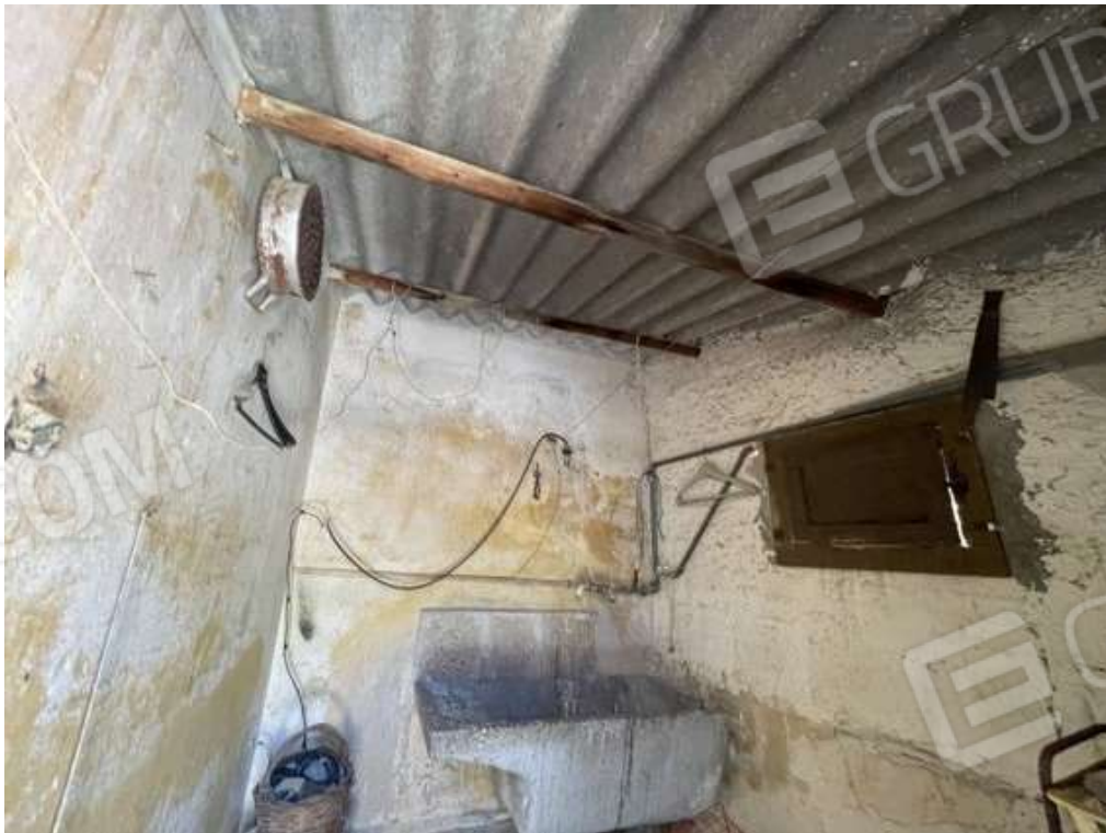
Fotografia D.30 - Piano secondo: interni del manufatto
