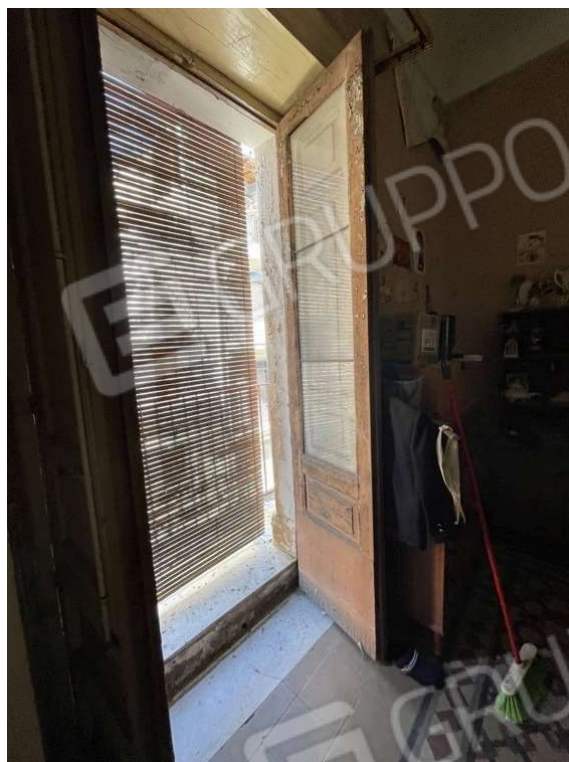
Fotografia D.13 - Piano primo: balcone che si affaccia sulla via Gioachino Rossini
