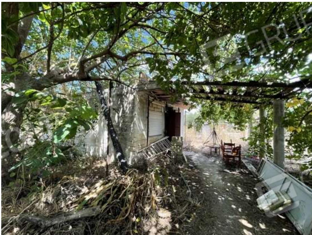
Fotografia D.64 - Magazzino: prospetto est
