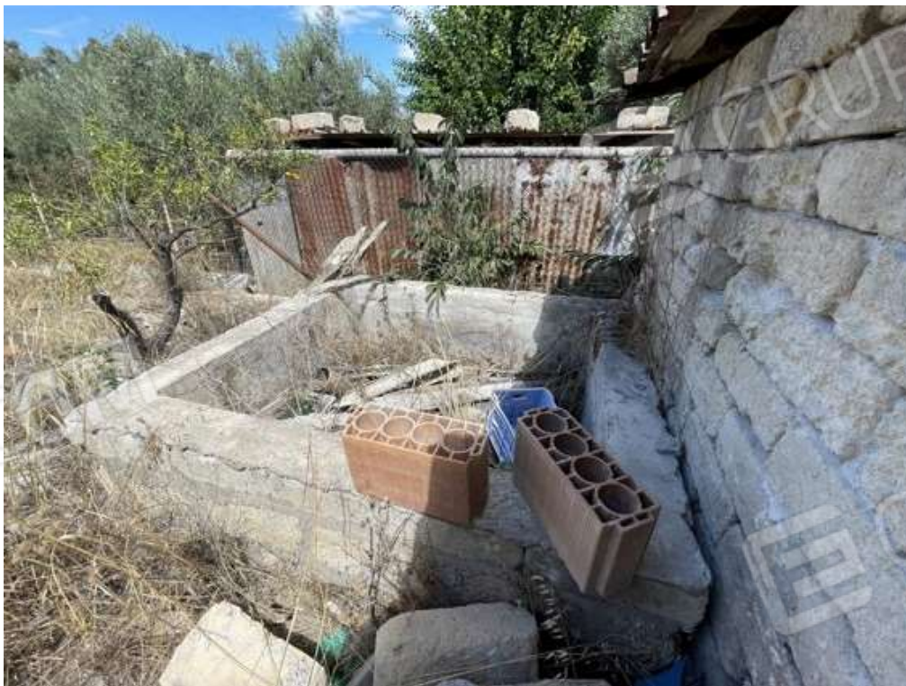
Fotografia D.54 - Vasca e confine nord
