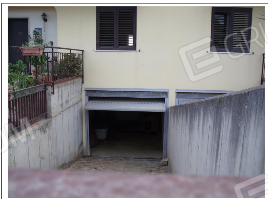
29. Esterno dell'unità immobiliare con vista verso prospetto principale. Esposizione lato nord-est, in foto ingresso al garage posto al piano primo sottostrada S1.
