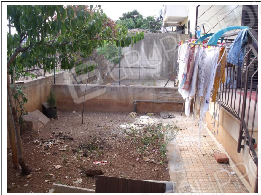
12. Esterno dell'unità immobiliare con vista lato nord-ovest verso area cortiliva restrostante, presenza di piccolo giardino.
