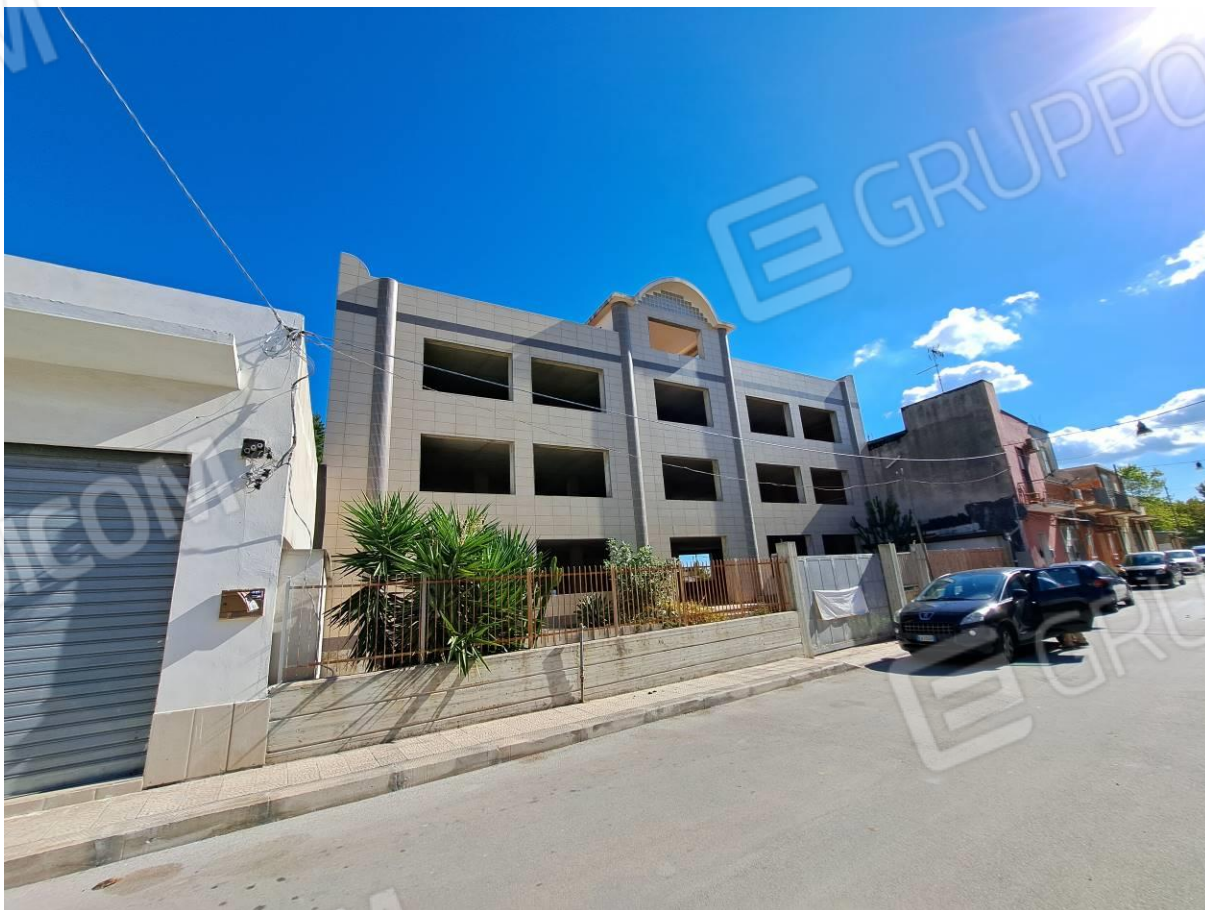
foto 36 – Edificio in corso di costruzione in Priolo Gargallo, via Boscarino
