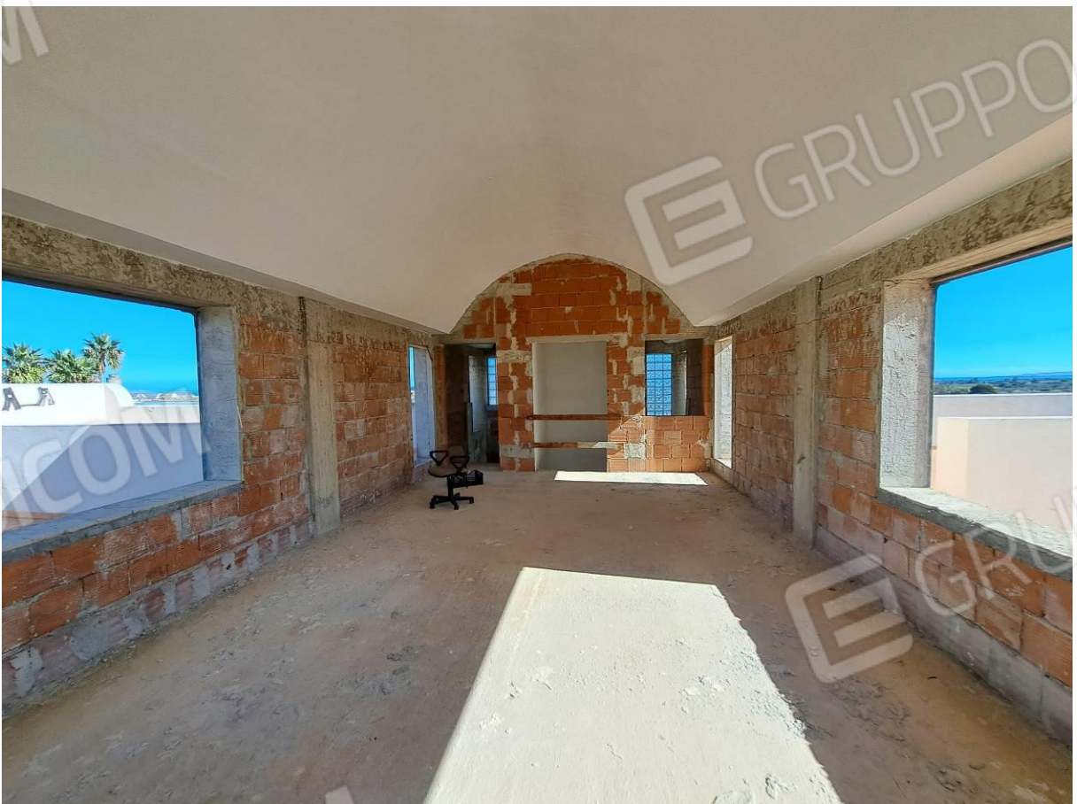
foto 44 – Edificio in corso di costruzione in Priolo Gargallo, via Boscarino (piano terzo)
