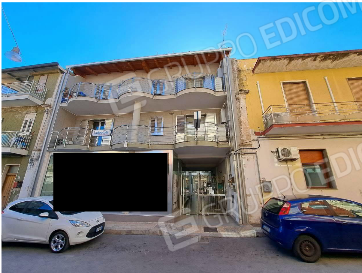
foto 1 - Edificio in Priolo Gargallo via Palestro 121 (prospetto su via Palestro)
