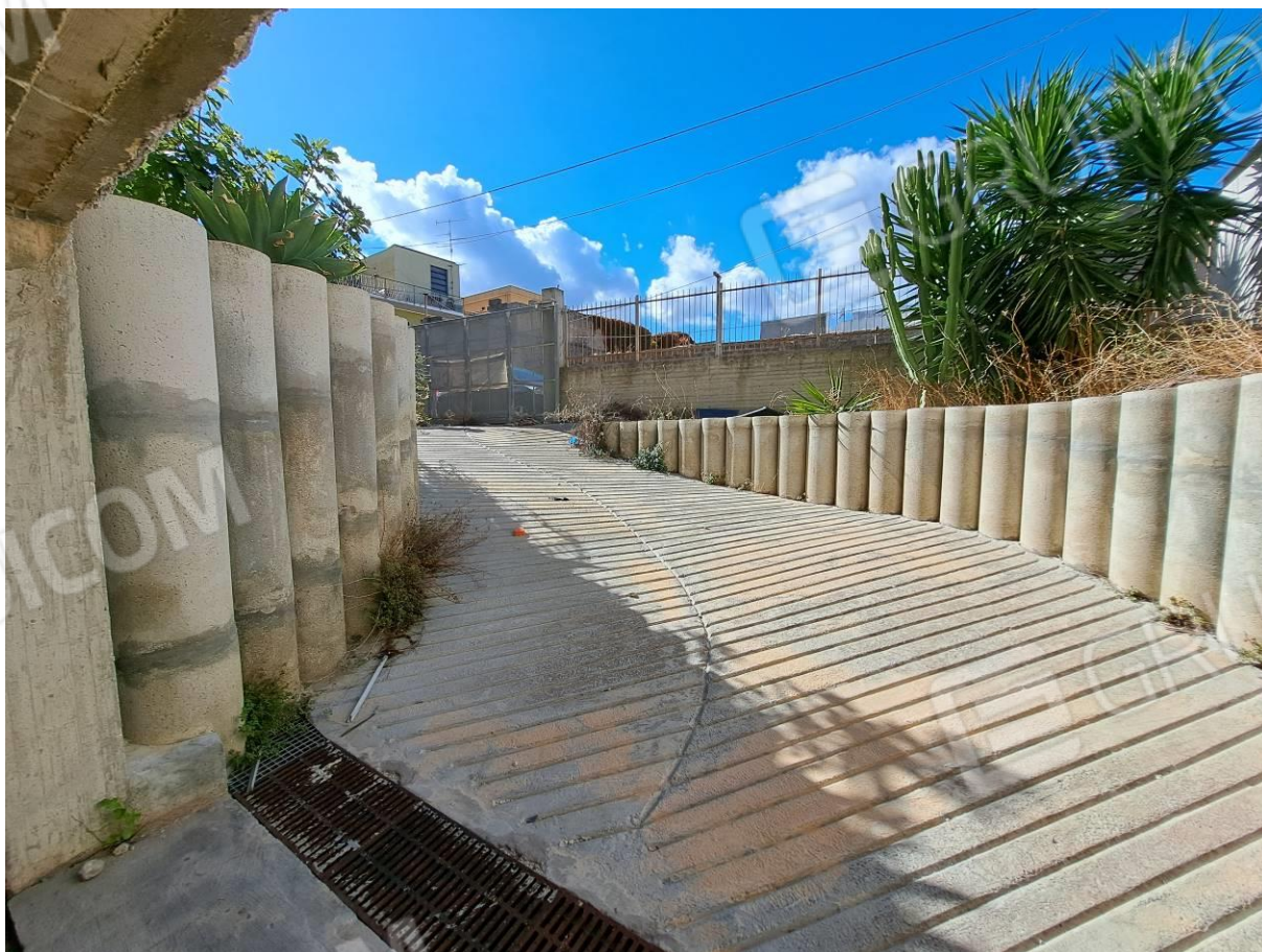
foto 38 – Edificio in corso di costruzione in Priolo Gargallo, via Boscarino (rampa di accesso al piano ammezzato)
