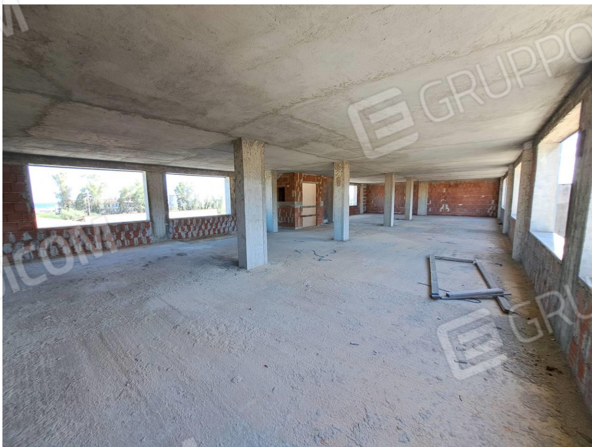
foto 42 – Edificio in corso di costruzione in Priolo Gargallo, via Boscarino (piano secondo)
