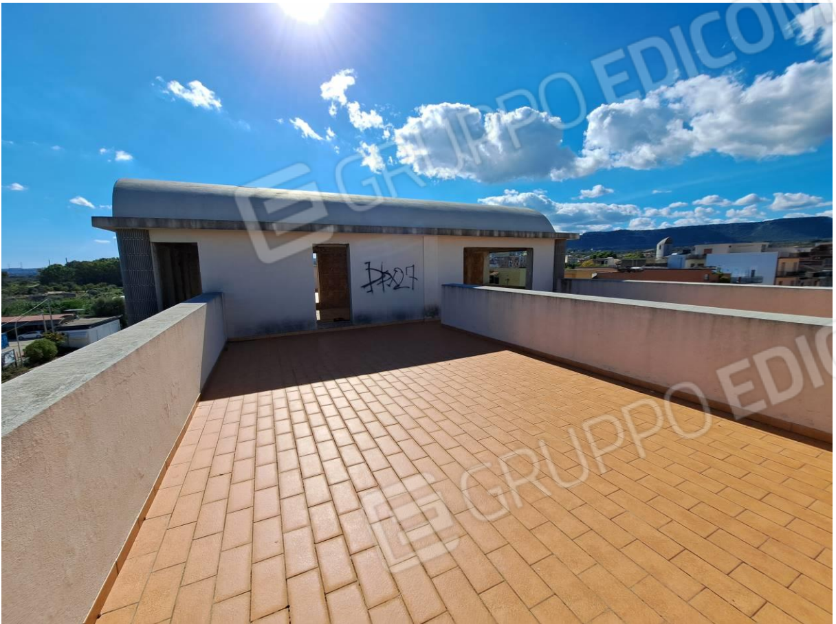
foto 43 – Edificio in corso di costruzione in Priolo Gargallo, via Boscarino (piano terzo)
