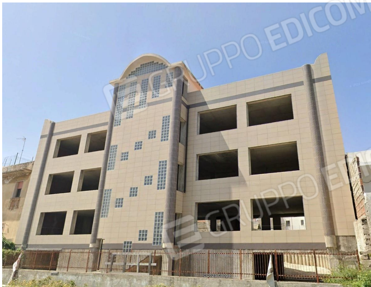
foto 37 – Edificio in corso di costruzione in Priolo Gargallo, via Boscarino
