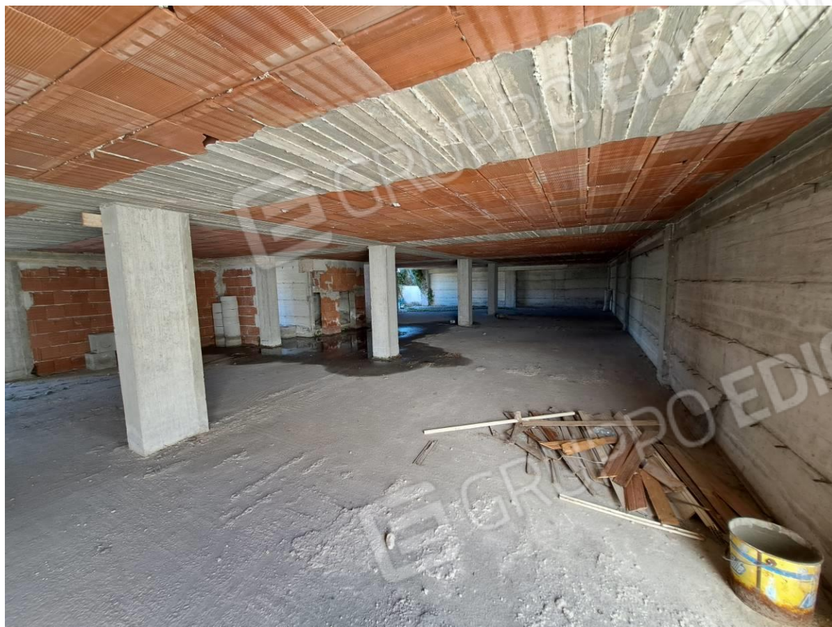
foto 39 – Edificio in corso di costruzione in Priolo Gargallo, via Boscarino (piano ammezzato)
