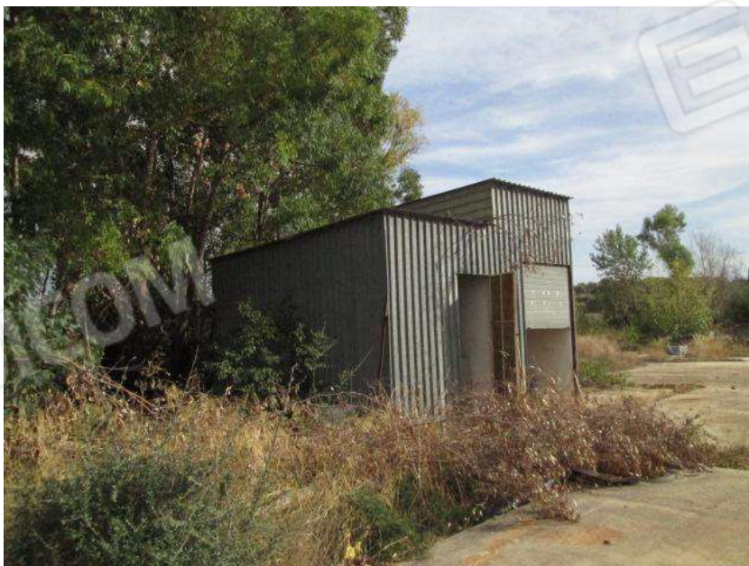
Foto 62. Vista esterna del Corpo F.3 - Deposito.
