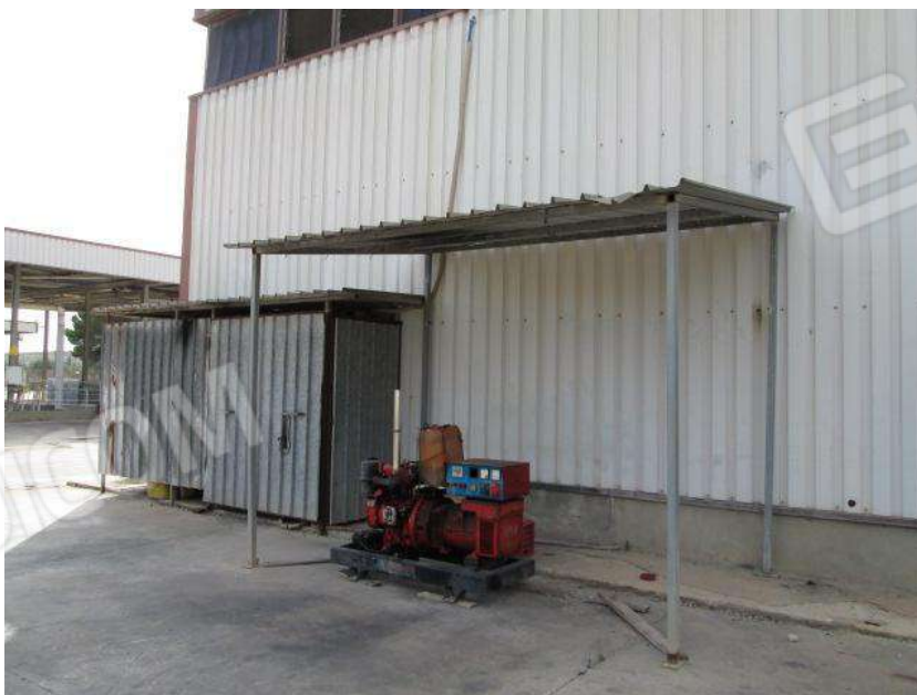
Foto 50. Vista esterna del Corpo B - tettoie.
