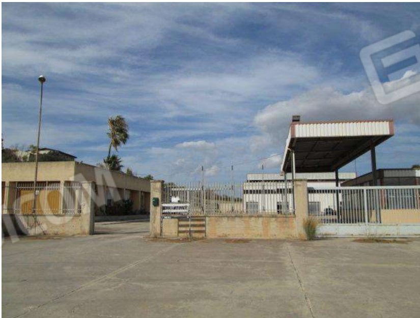
Foto 6. Ingresso al complesso immobiliare dal piazzale adiacente la SP 26.
