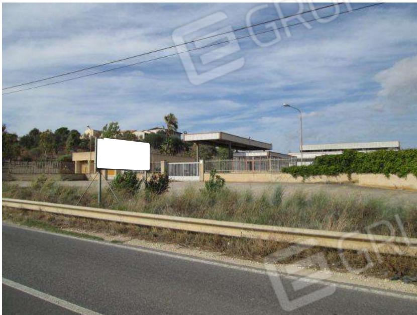
Foto 3. Vista esterna del complesso immobiliare dalla SP 26.
