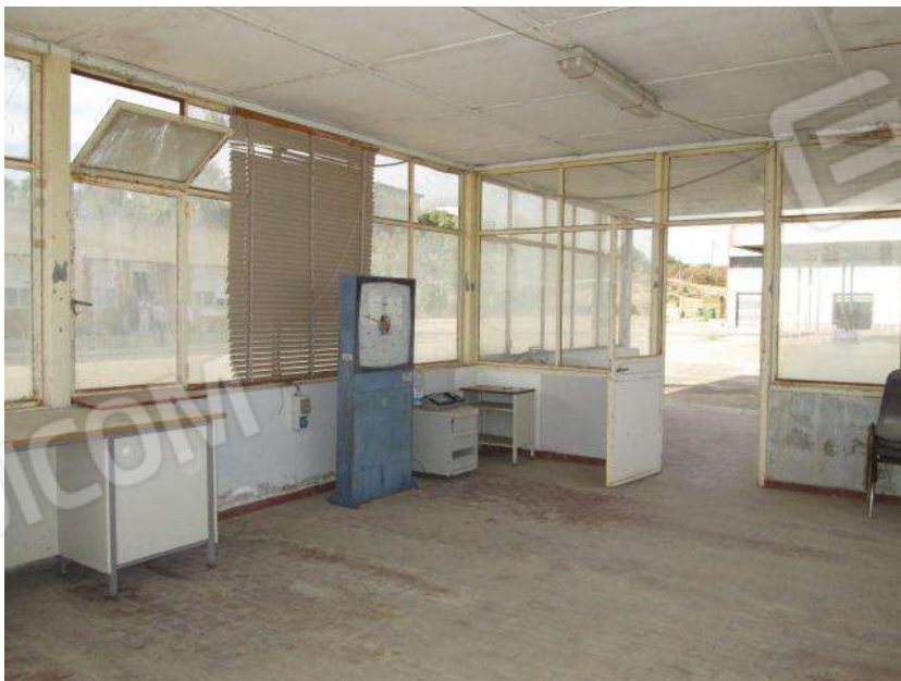
Foto 60. Locale Ingresso e pesatura.
