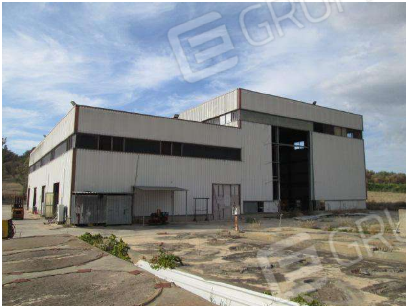
Foto 39. Vista esterna del Corpo B.
