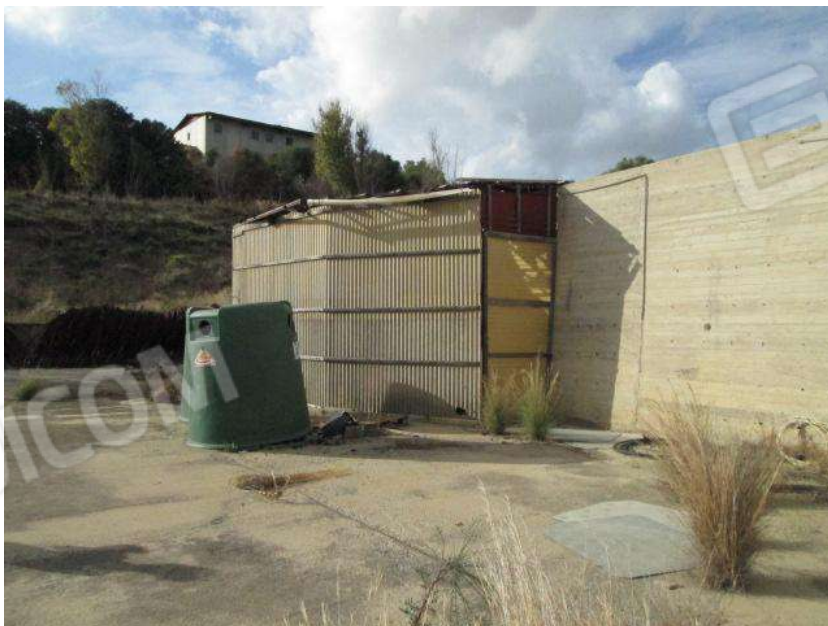
Foto 66. - Deposito adiacente il Corpo F.5.
