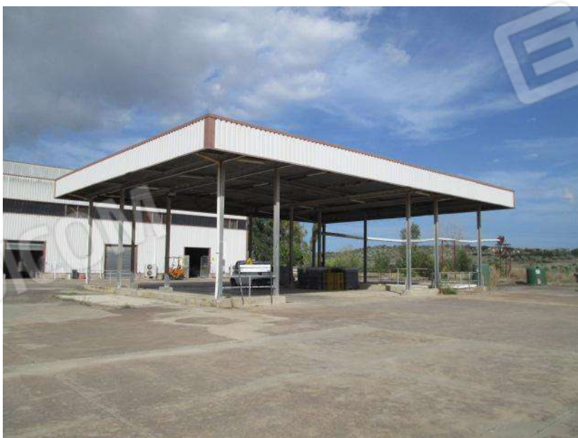
Foto 72. Vista esterna del Corpo G.
