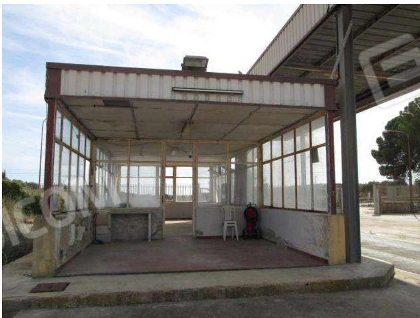
Foto 58. Vista esterna del Corpo E - Locale ingresso e pesatura.
