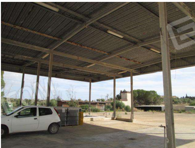
Foto 74. Vista esterna del Corpo G.
