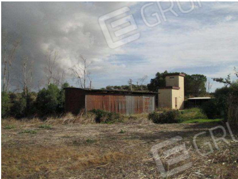
Foto 67. Vista esterna del Corpo D e dei depositi Corpi F.1 e F.2.
