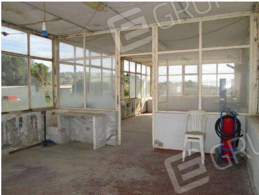
Foto 59. Locale Ingresso e pesatura.
