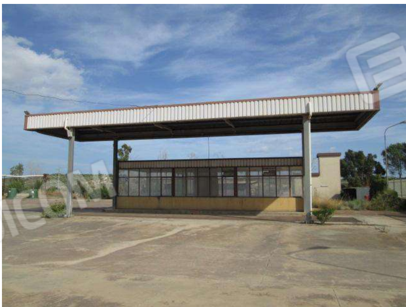
Foto 56. Vista esterna del Corpo E.
