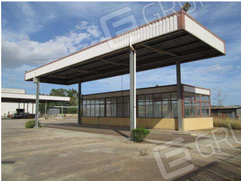
Foto 55. Vista esterna del Corpo E.
