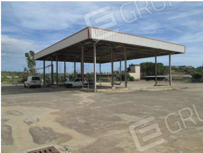
Foto 73. Vista esterna del Corpo G.
