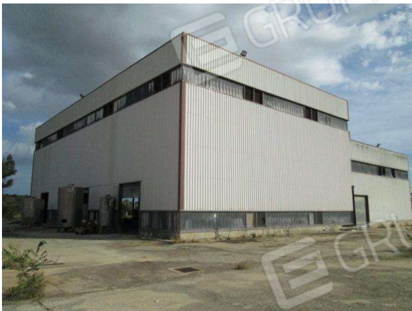
Foto 41. Vista esterna del Corpo B.
