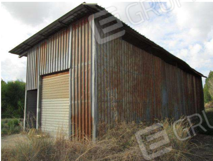
Foto 69. Vista esterna del Corpo F.2 - Deposito.
