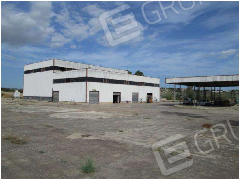
Foto 37. Vista esterna del Corpo B.
