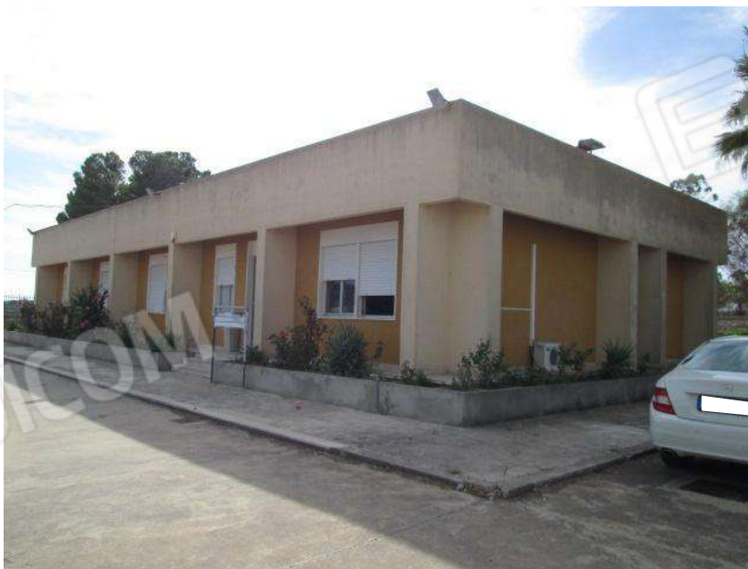
Foto 18. Vista esterna del Corpo A.
