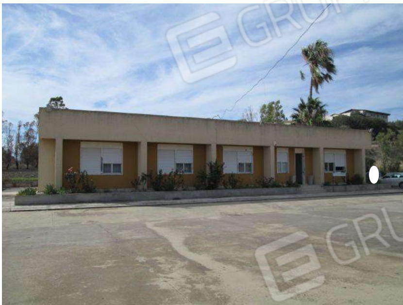
Foto 17. Vista esterna del Corpo A.
