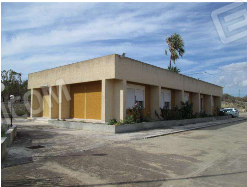
Foto 16. Vista esterna del Corpo A.
