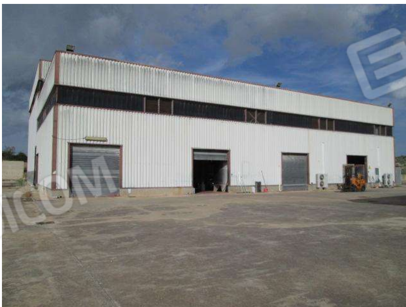
Foto 38. Vista esterna del Corpo B.
