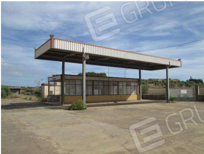
Foto 57. Vista esterna del Corpo E.
