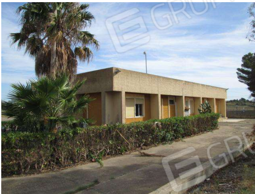
Foto 19. Vista esterna del Corpo A.
