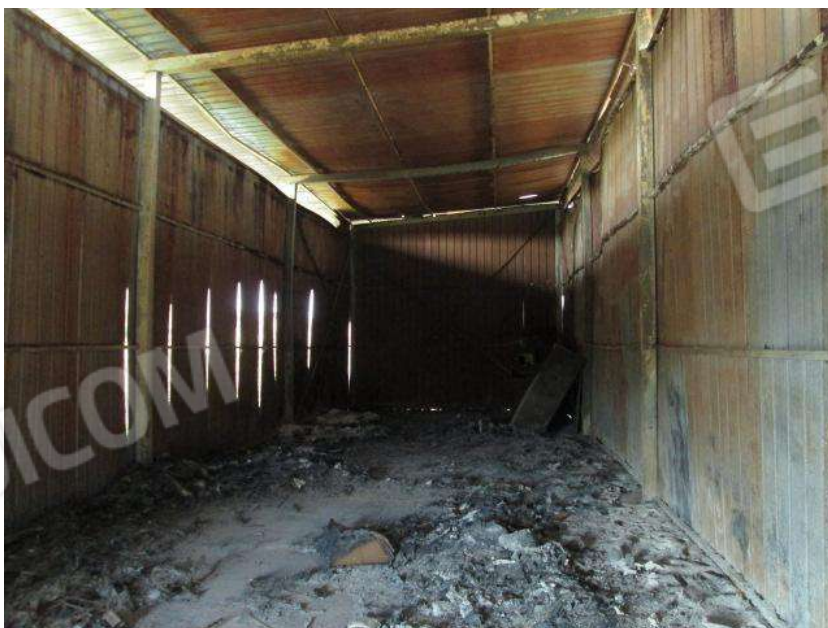
Foto 70. Vista interna del Corpo F.2 - Deposito.
