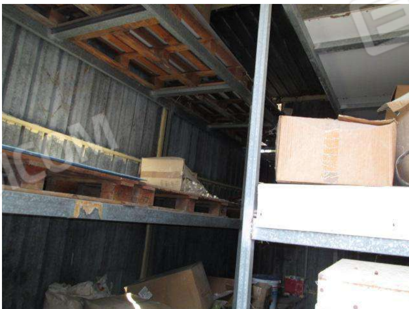
Foto 64. Vista interna del Corpo F.3 - Deposito.
