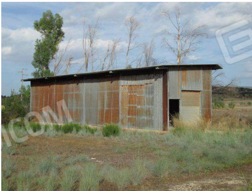
Foto 68. Vista esterna del Corpo F.2 - Deposito.
