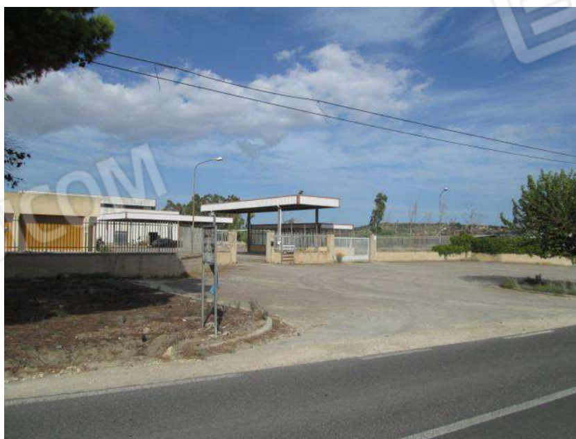
Foto 2. Vista esterna del complesso immobiliare dalla SP 26.
