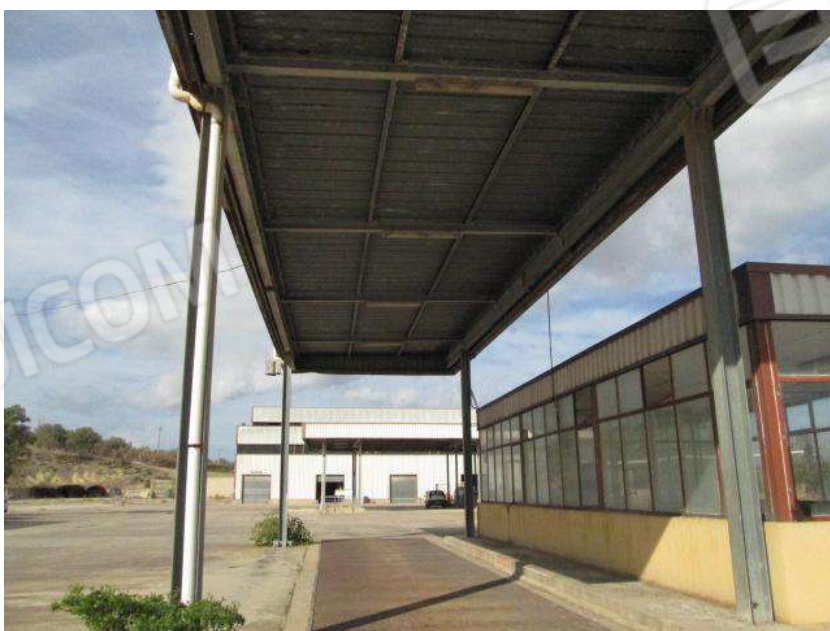
Foto 54. Vista esterna del Corpo E.
