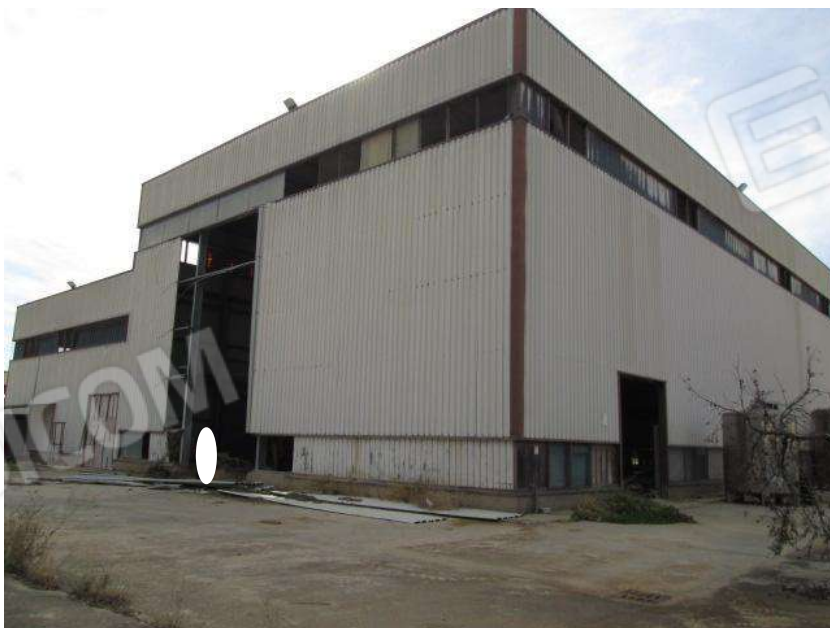
Foto 40. Vista esterna del Corpo B.
