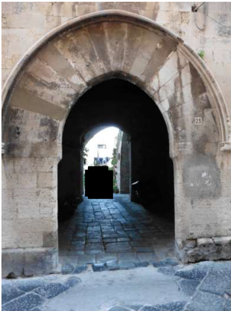
Foto 1 – Appartamento “2A” – Ingresso al cortile interno, su cui si affaccia l’unità immobiliare in oggetto
