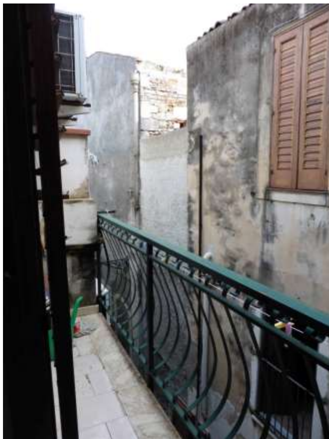
Foto 9 – Appartamento 6A – Balcone su ronco II di via Resalibera
