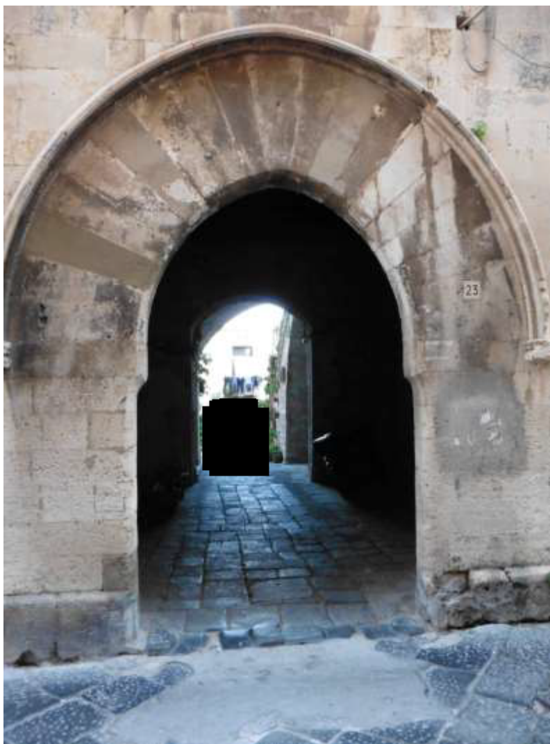
Foto 1 – Deposito “3A” – Ingresso al cortile interno, dal quale si accede all’immobile in oggetto
