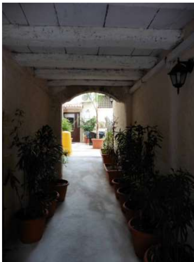
Foto 3 – Deposito “3A” – Accesso al deposito dal cortile interno del palazzo
