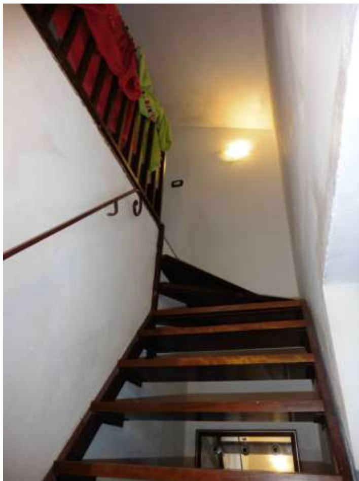
Foto 5 – Appartamento 6A – Scala interna all'appartamento
