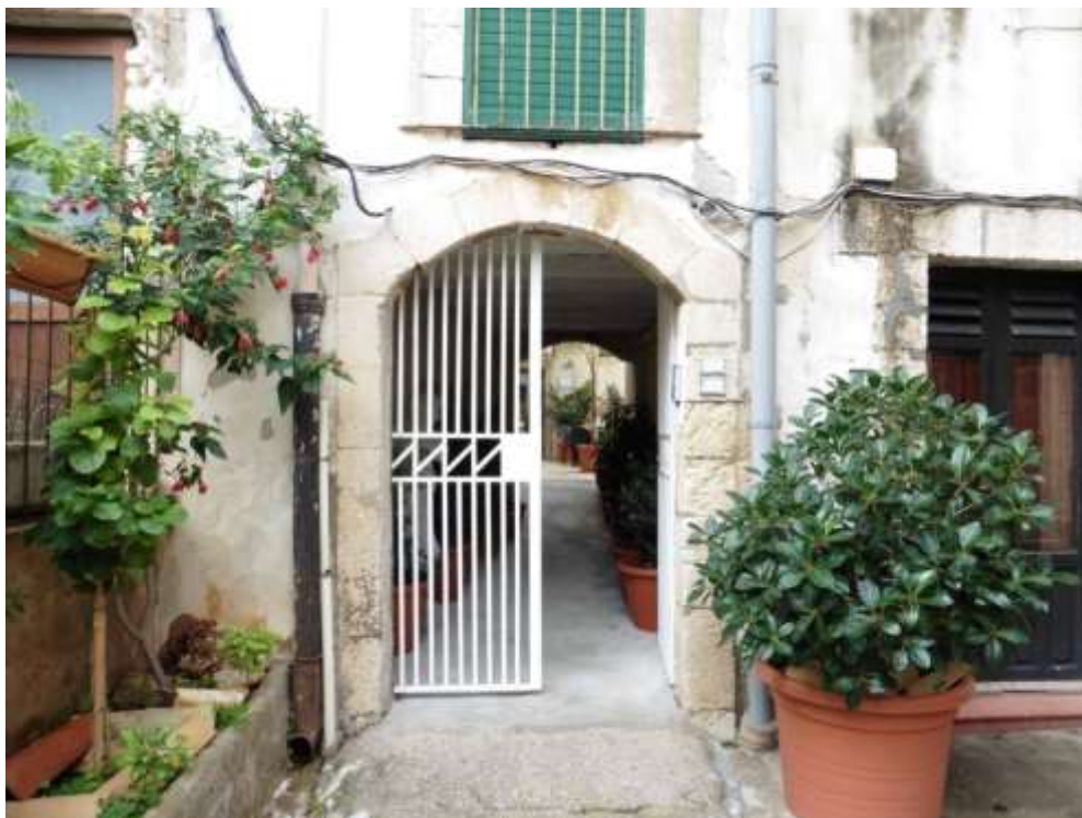
Foto 2 – Deposito “3A” – Accesso al deposito dal cortile interno del palazzo
