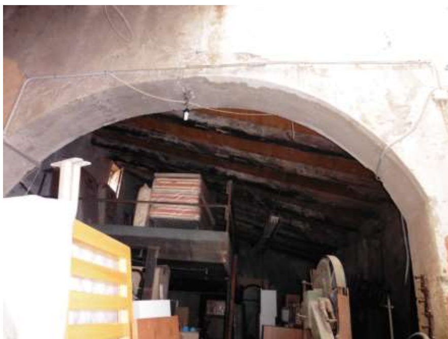
Foto 7 – Deposito 3A – Interno
