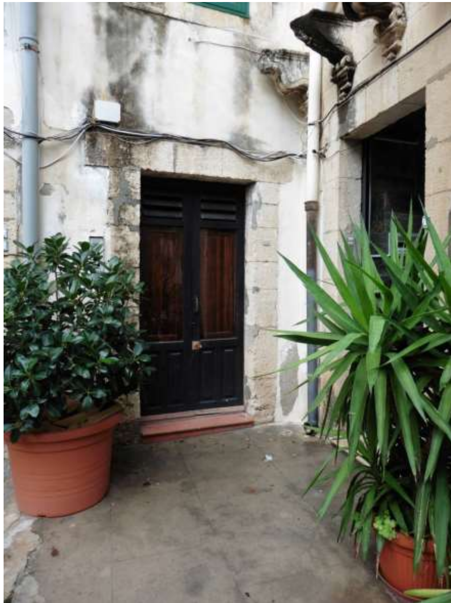
Foto 2 – Appartamento “1A” – Ingresso all’appartamento
