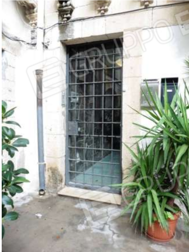
Foto 2 – Appartamento “4A” – Accesso all’unità strutturale di cui fa parte l’immobile
