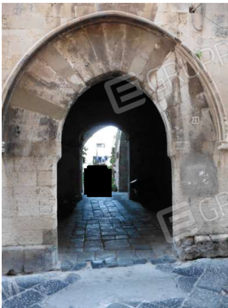
Foto 1 – Appartamento “4A” – Ingresso al cortile interno, dal quale si accede all'immobile in oggetto
