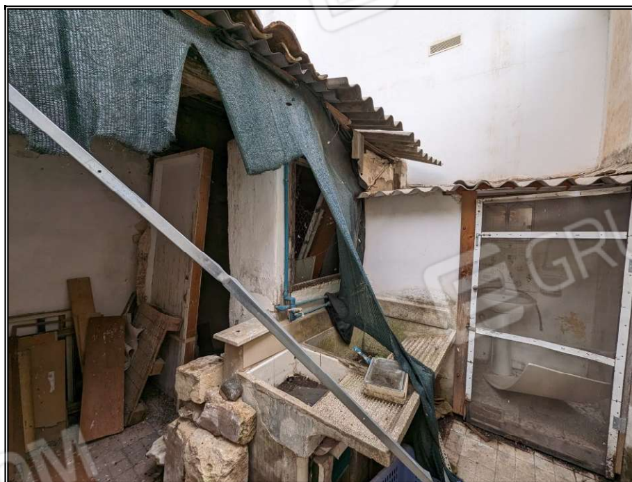
Foto n° 13 – Esterno ripostiglio, tettoia e w.c.
