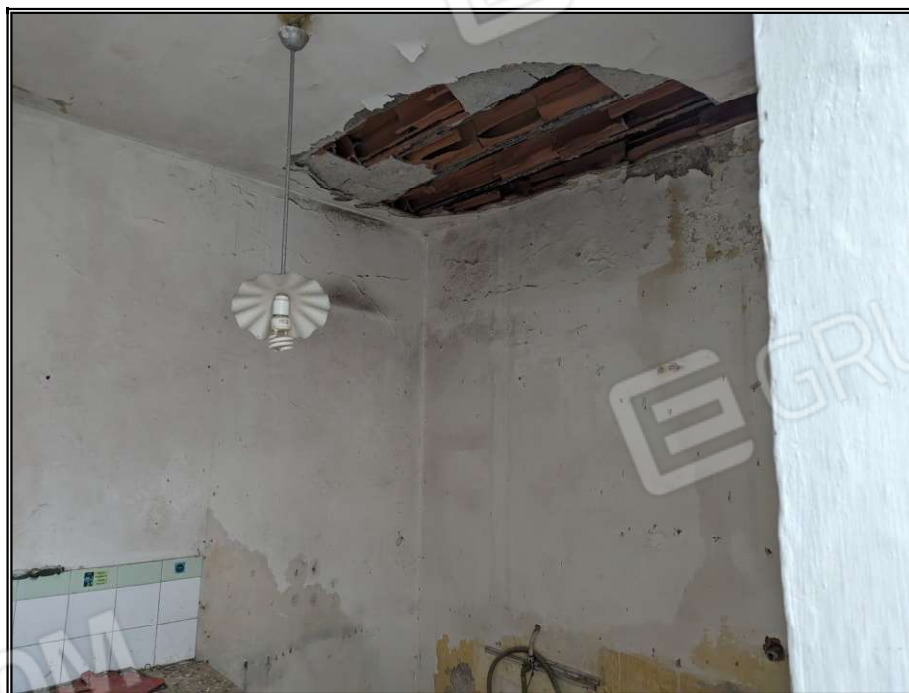
Foto n° 11 - Particolare soffitto locale forno
